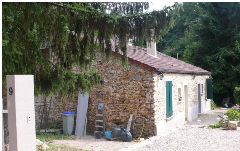
Bois des Roches : maison de carrier.
