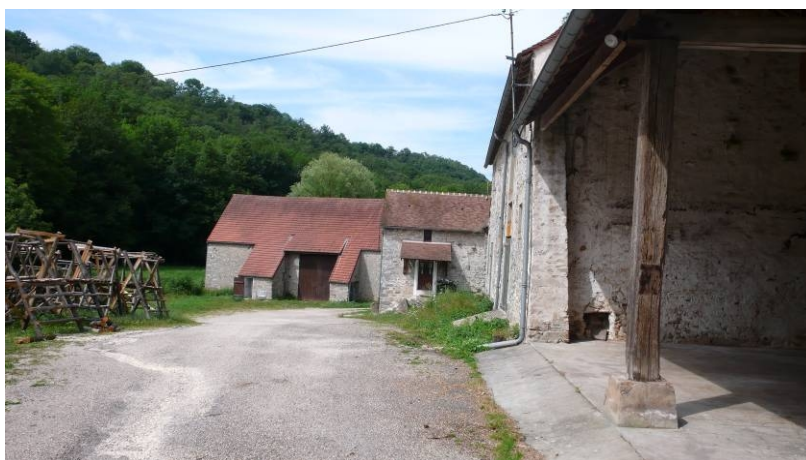
Les bâtiments composant SOU05 sont « ante-cadastrés ». Cet ensemble agricole comprend un ancien moulin, appelé le moulin neuf. Ce moulin était équipé de meules en pierre.
