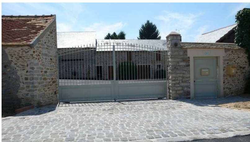
SOU01 est une petite ferme à cour fermée située dans le hameau des Emondants. De plan rectangulaire à quatre côté bâtis, elle est constituée de bâtiments « ante-cadastrés » et de bâtiments plus récents, vraisemblablement construits au cours du XIX e siècle.
