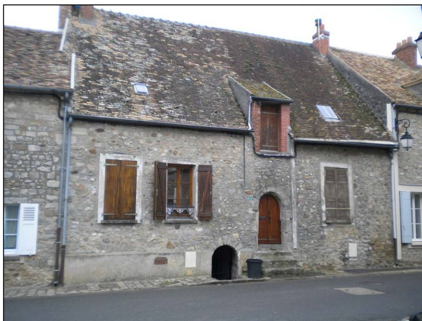
Maison recensée SSF38, rue du Four-à-Chaux, avec son entrée de cave. Ce bâtiment est situé juste à côté d'une maison de vigneron (SSF37, cf. infra)
