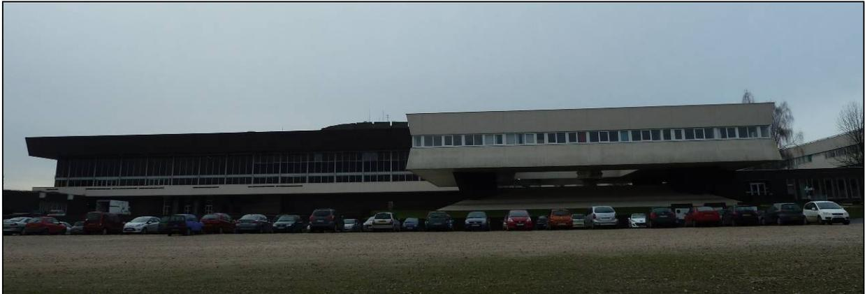
Les laboratoires sont situés à l'ouest du noyau central. Disposés en peigne et abritant de nombreuses salles standardisées, ils ont fait l'objet d'une recherche architecturale moindre et se présentent sous la forme de bâtiments parallélépipédiques à trois niveaux, au toit en terrasse et aux baies filantes, dans une composition proche des bâtiments techniques observés sur d'autres campus du secteur (Orsay, etc.) Ils ont été complétés par des modules préfabriqués (ci-contre).
