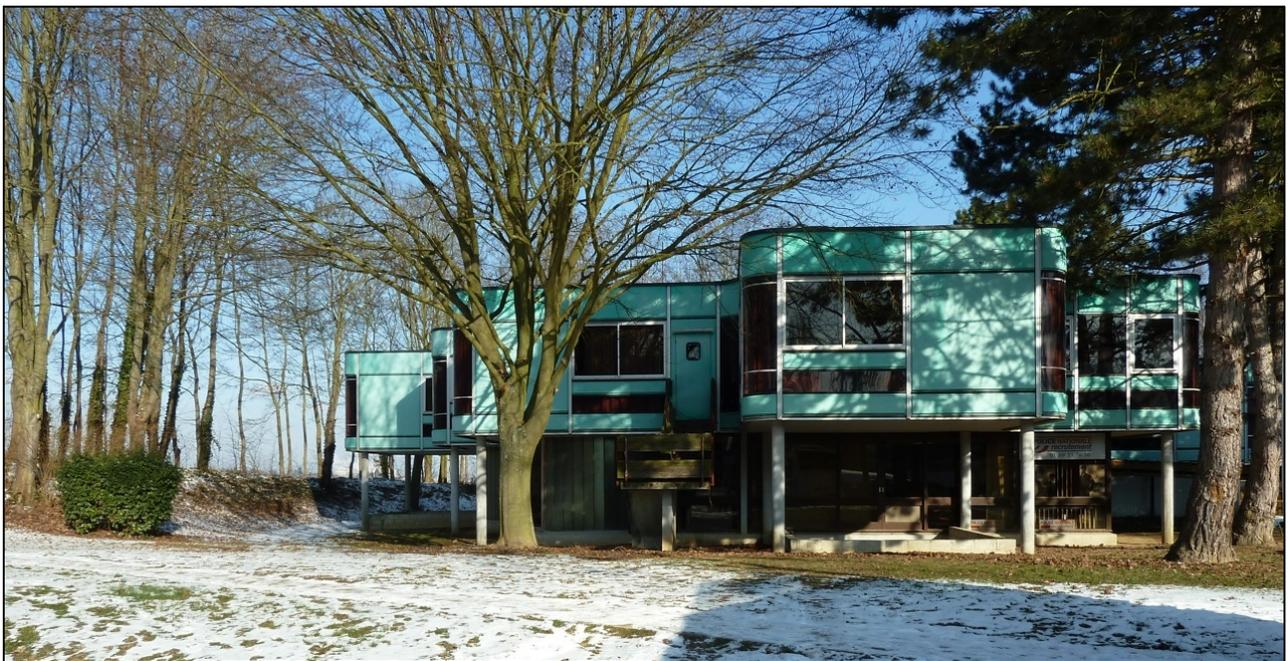
*Afin d'obtenir un maximum de luminosité, les surfaces vitrées prennent le plus d'espace possible : outre les grandes baies coulissantes, les angles s'ouvrent vers l'extérieur par une plaque de plexiglas coloré, convexe ou concave, fixée par des bandes rivetées. De la même façon, les allèges des fenêtres sont ouvertes par un bandeau de plexiglas translucide. Un double système de stores, intérieur et extérieur, permet de moduler la lumière entrante.*
