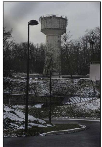
*Les installations techniques datant de l'installation de l'ONERA (fin des années 1940 – début des années 1950) sont surtout visibles aujourd'hui depuis le nord. Il s'agit de bâtiments aux élévations sobres, en béton enduit de blanc. Le site dispose de son propre château d'eau, lui aussi de facture très simple, où un fût cylindrique supporte une cuve circulaire débordante. (Photographies Philippe Ayrault)*
