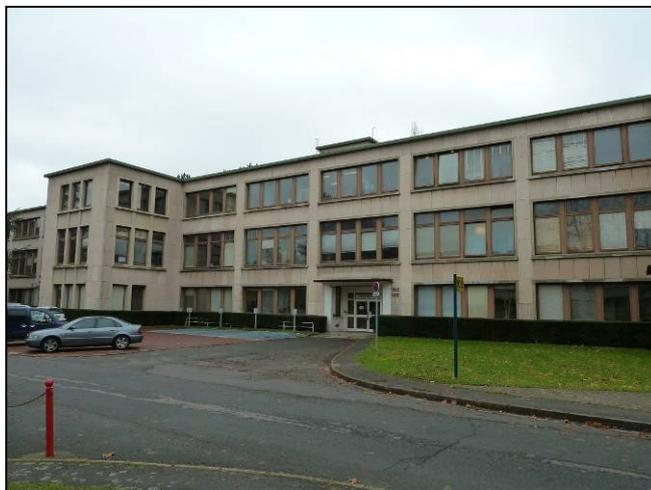
*A gauche, le bâtiment 100A, consacré à l'Institut de Physique nucléaire et construit semble-t-il en 1958. Il s'agit d'un bâtiment de quatre niveaux, de plan rectangulaire longiligne accentué par les baies filantes. Le premier niveau est un étage de soubassement. L'accès se fait par le rez-de-chaussée surélevé (deuxième niveau) via un palier dans la continuité du niveau du sol. La couverture est en terrasse. La façade est recouverte de petites dalles de béton rosé.*
