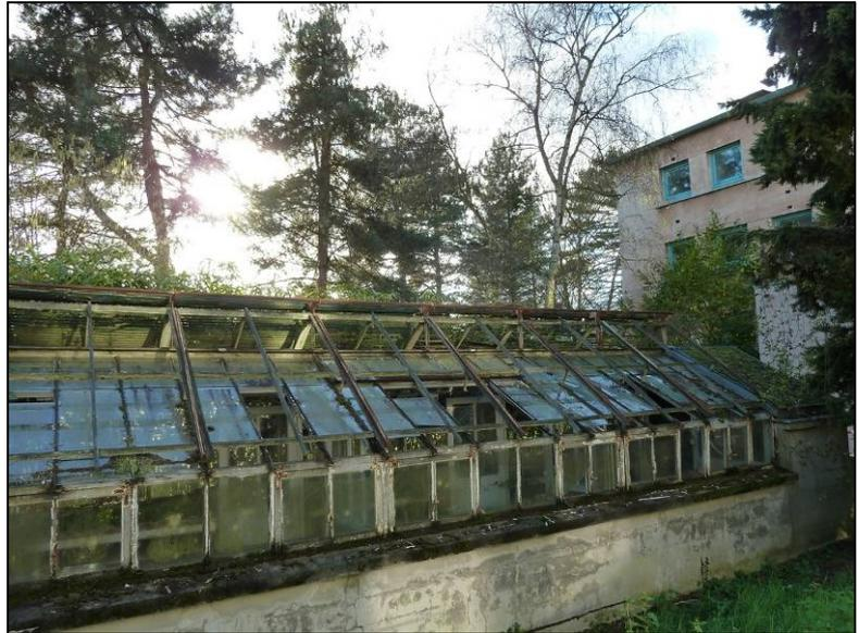
*Ces anciennes serres se trouvent au sud du bâtiment 440, datant du début des années 1960 et accueillant actuellement l'Institut de Biologie animale et cellulaire (IBAIC). A l'abandon, elles ont néanmoins conservé les mécanismes et châssis d'ouverture et de fermeture de volets roulants extérieurs, permettant d'ajuster la température et la luminosité. Les verrières sont installées sur un soubassement en béton.*
