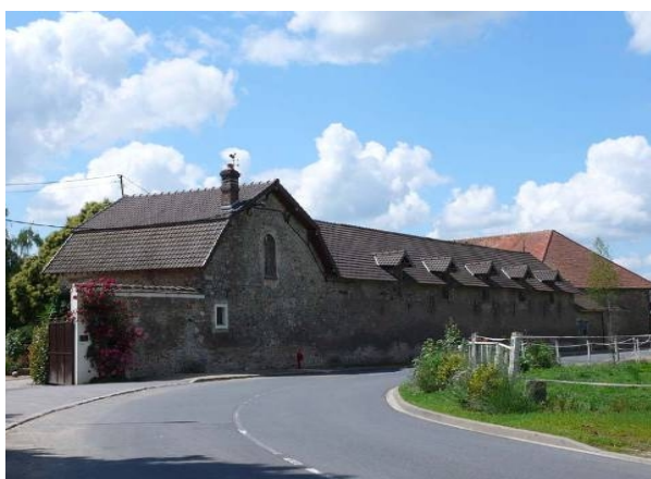
Pavillon d'entrée et bâtiment d'exploitation
