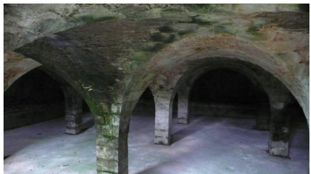
MEN73 : voûte des anciens réservoirs d'eau
