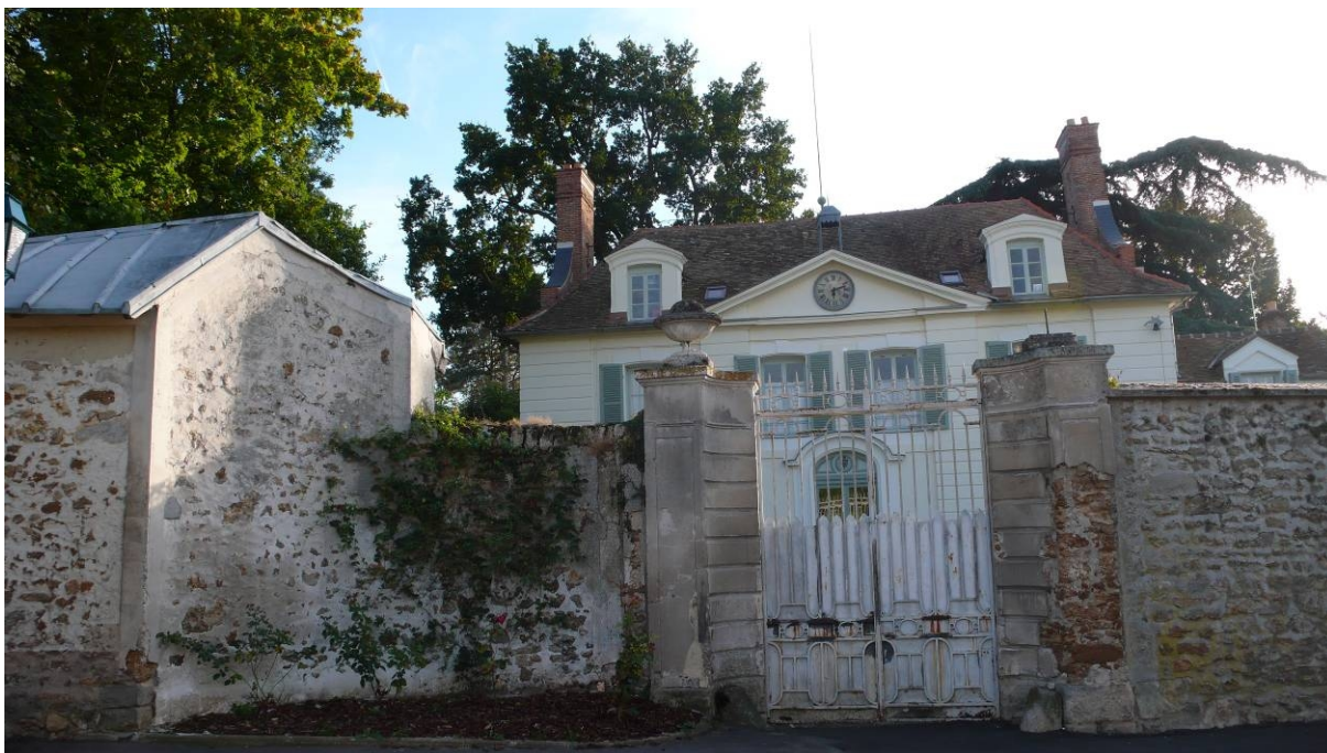
MEN35 (28, rue de Bel Air) : le bâtiment actuel date du XVIII e siècle. Le corps central est composé de quatre travées et d'un étage carré surmonté d'un étage de combles aménagés. La modénature de plâtre est soignée.
