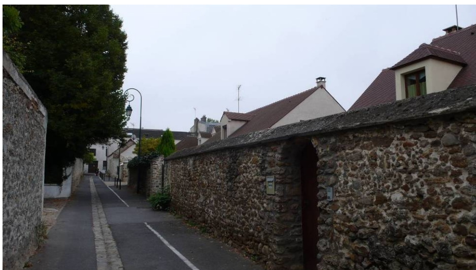
Murs de clôture de la rue Périchon
