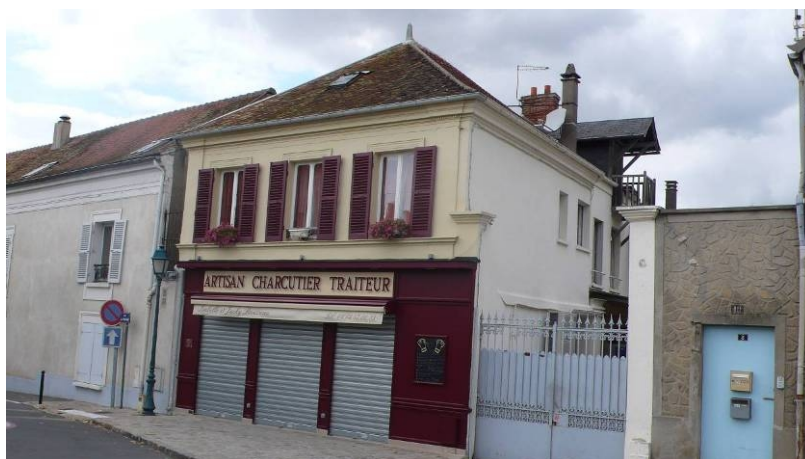
MEN169 (1, rue du Général Pierre) : la lucarne engagée caractéristique des boulangeries est également toujours en place. La façade sur rue possède une belle modénature de plâtre (corniche, bandeaux lissés et bandeau horizontal).
