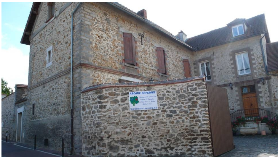
MEN134 (4, rue de l'Arcade) est une ferme « ante-cadastre » dont le logis à un étage carré surmonté d'un étage de combles aménagés possède un chaînage d'angle de grès très régulier. Le bâtiment fut repris au XIX e siècle comme en témoigne la présence de briques dans l'encadrement des baies.
