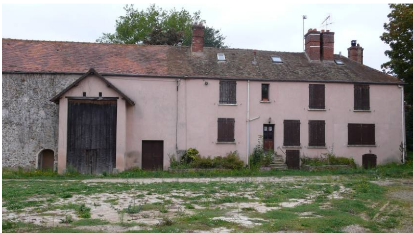
MEN110 (31, rue de Milly) est une ferme « ante-cadastre » qui était autrefois rattachée à la maison de notable attenante, appelée l'Etape. Le bâtiment agricole possède une porte charretière précédée d'un porche dans lequel un pigeonnier a été aménagé. Cet ensemble agricole abrite aujourd'hui une partie des services municipaux de la commune.
