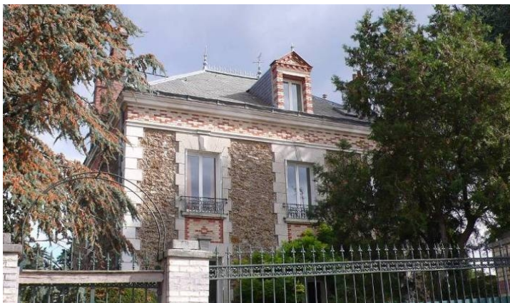
MEN146 (10, rue Périchon) semble avoir été construite à la fin du XIX e siècle. Elle possède trois travées, un étage carré et un étage de combles aménagé (lucarne sur versant de toiture). Elle est coiffée d'un toit en pavillon recouvert d'ardoises. La modénature est composée d'un décor de plâtre (encadrement des baies et chaînes d'angle) ainsi que par un décor de briques bichromes au niveau des allèges, de la corniche et de la lucarne.
