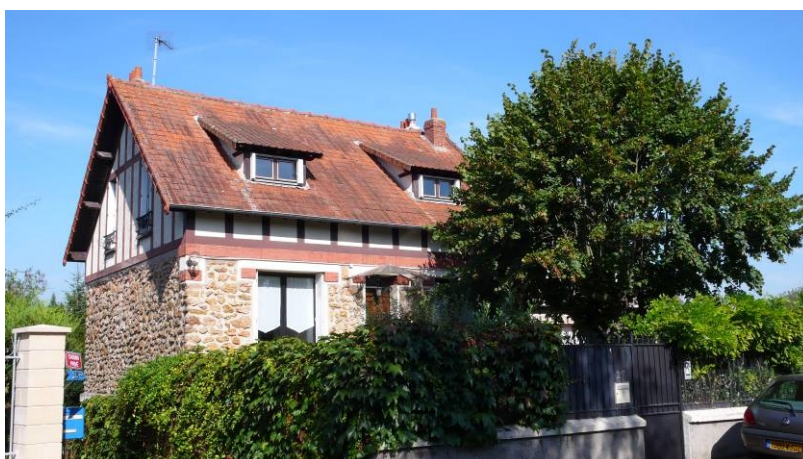
MEN20 (27, rue Canoville) est une construction de style néo-régional dont la façade antérieure est située sur le mur gouttereau.
