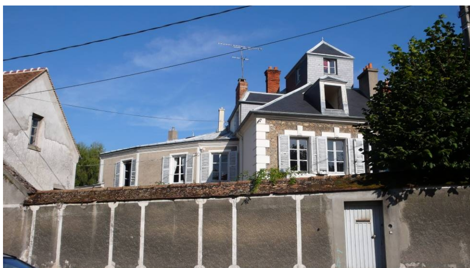
MEN48 (2, rue du Général Leclerc) est une maison « ante-cadastre » qui fut remaniée à plusieurs reprises comme en témoigne l'enchevêtrement des styles architecturaux. Le corps central en pavillon est coiffé d'un belvédère. Les murs sont ornés d'une modénature de plâtre. L'aile latérale est plus sobre : les encadrements de baies et les chaînes d'angle sont soulignés par des bandeaux lissés. Enfin, l'annexe sur la rue du Général Leclerc est un bâtiment modeste dont les murs ont été récemment enduit au ciment.
