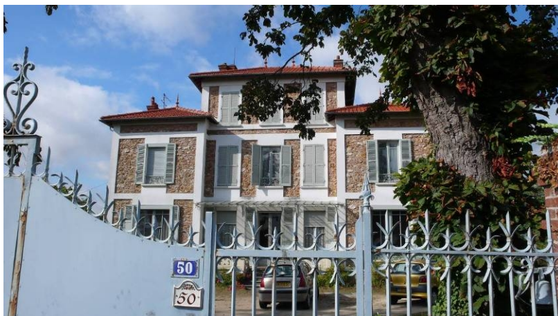
MEN138 est une imposante villa construite à la fin du XIX e siècle au 50, boulevard du Général de Gaulle. Elle est composée d'un corps central et de deux ailes symétriques. La modénature se limite à la présence de bandeaux lissés.
