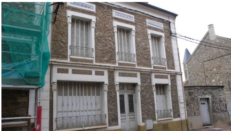
MEN127 (4 bis, rue de Milly) fut construite au XIX e siècle. La maçonnerie en meulière rocaillée laisse penser que les façades étaient à pierre vue dès l'origine. Les encadrements de baies et les chaînes d'angles sont en revanche soulignés par des bandeaux lissés. La modénature de plâtre est également composée d'un bandeau horizontal et d'une corniche moulurée. Des carreaux de faïence sont placés au-dessus des baies du premier étage.
