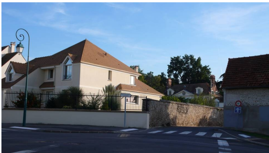
Lotissement de l'avenue du Bois Chapet. Une partie des anciens murs de clôture en pierre a été conservée. En arrière-plan la maison de notable recensée MEN35.
