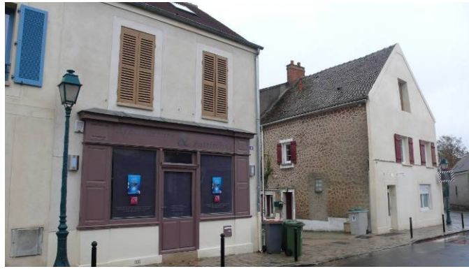
MEN182 (11, rue du Général Pierre) : il convient de saluer la restauration récente de cette maison à boutique qui a permis de conserver la devanture en bois.
