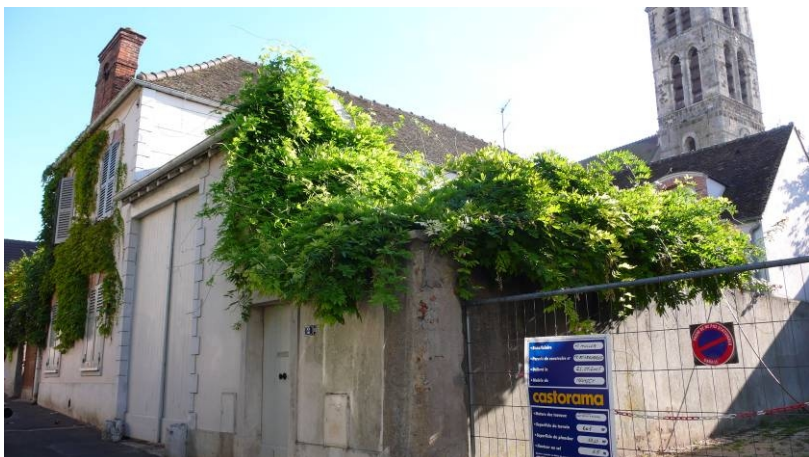
MEN54 (2 bis, rue du Puits Massé) est une ancienne ferme « ante-cadastre » qui possède une imposante porte charretière associée à une porte piétonne.
