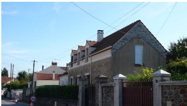
Bâtiment rural dénaturé situé au 72, rue du Petit Mennecy. Le bâtiment a été surélevé et des lucarnes passantes ont été ajoutées.
