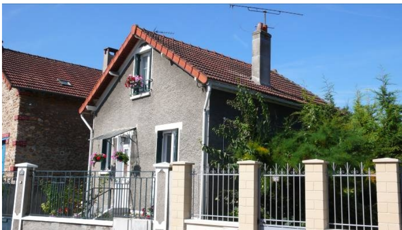
MEN22 (23, rue Canoville) constitue l'exemple type d'habitat individuel qui s'est développé dans les années 1920 : pavillon dont la façade antérieure est située sur le pignon et dont les murs sont recouverts d'enduit (les bandeaux lissés encadrant les baies sont les seuls éléments de décor).
