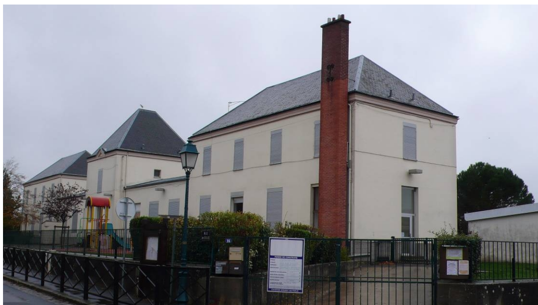
Photographie de l'école de Mennecy prise au cours du mois de septembre 2009 : l'ensemble des éléments de modénature a disparu. Les souches de cheminée ont été détruites, les murs de clôture en pierre remplacés par des grilles.
