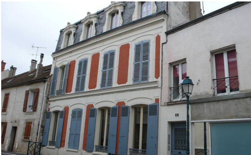
MEN77 (6, rue de la Fontaine) est une maison de bourg construite en 1870 à l'emplacement d'un bâtiment « ante-cadastre ». Les remarquables éléments de modénature ont été conservés.
