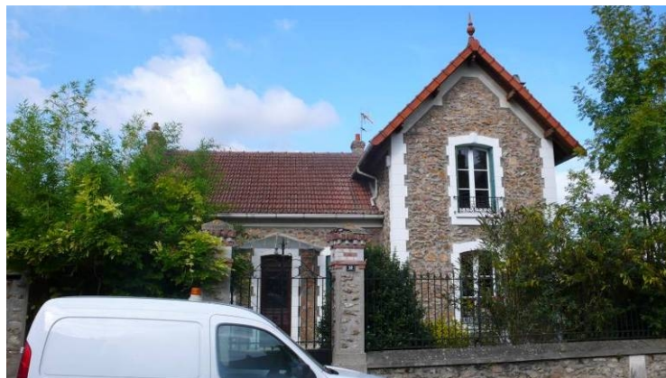
MEN158 (16, rue de la République) est construit selon un plan en « L ». Les encadrements de baies et les chaînes d'angle sont soulignés par des bandeaux lissés.
