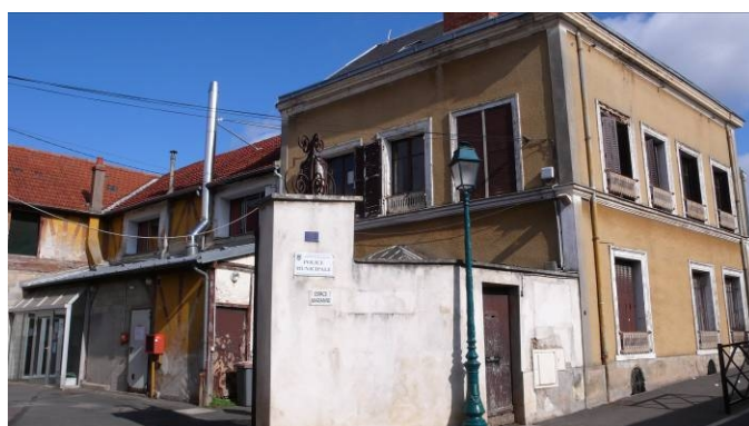
Ancien ensemble de bâtiments pour le négoce d'un marchand de vins en gros aujourd'hui dénaturé ( 7, rue de l'Arcade). Les bâtiments accueillent aujourd'hui les services de la police municipale.
