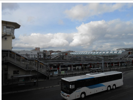
La passerelle vitrée dite du Lien
