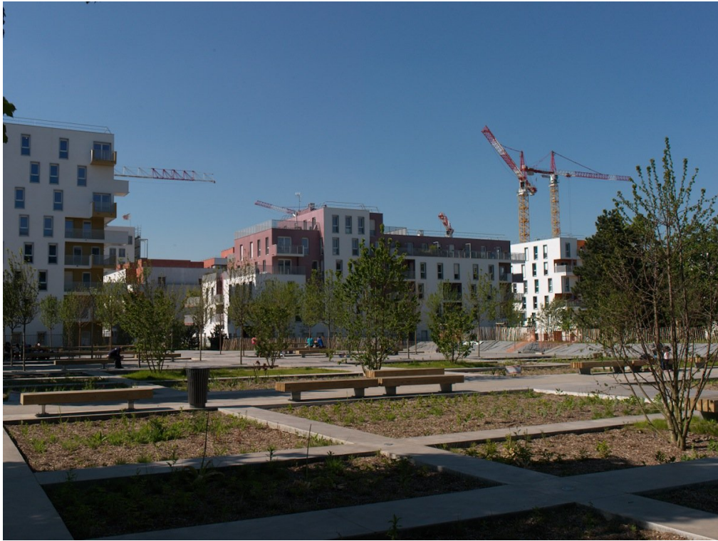
Massy Atlantis en construction
