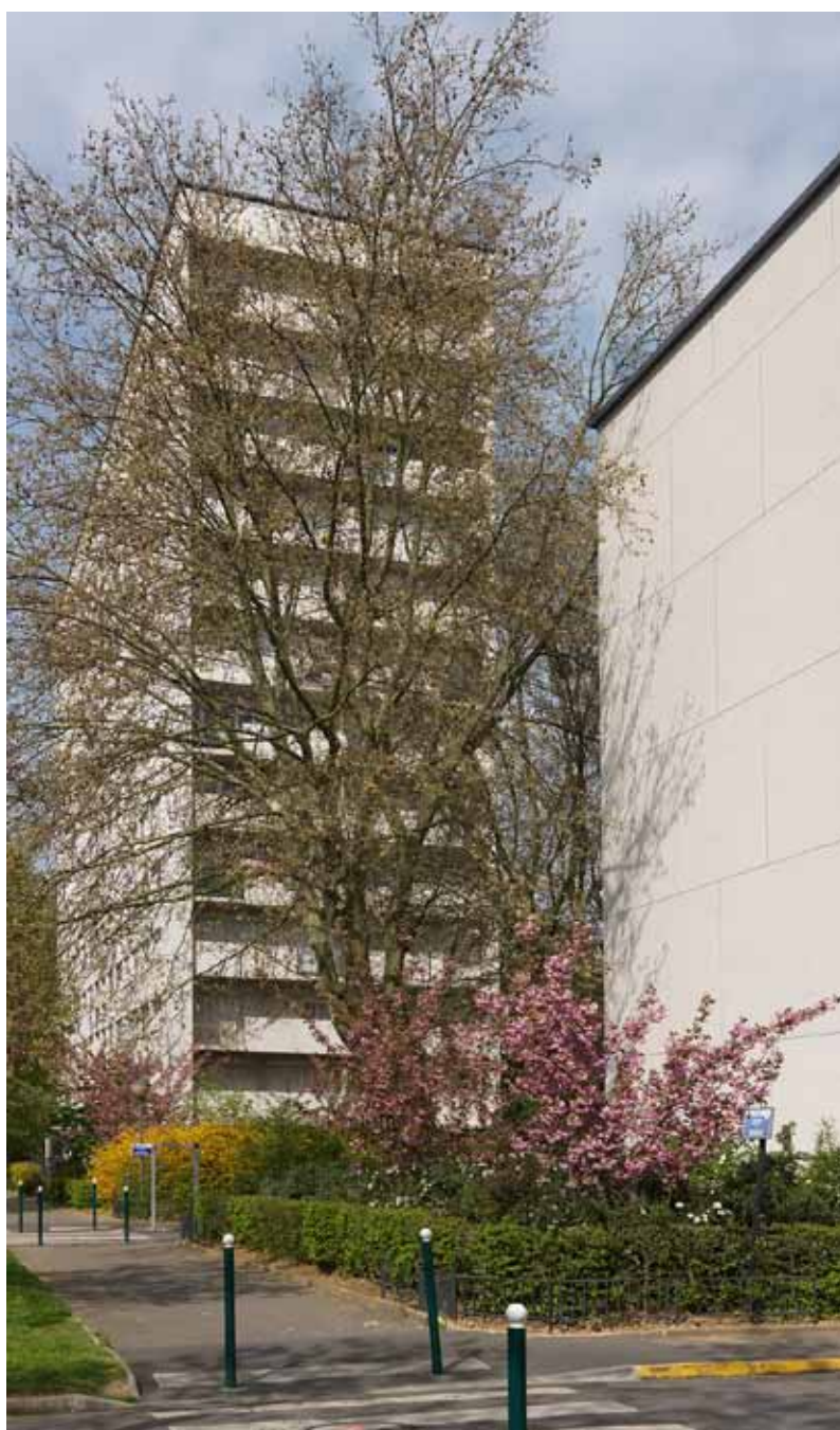
Pignon d'une barre R+12 située le long de l'avenue de Bourgogne. Le pignon est entièrement constitué de loggias.
