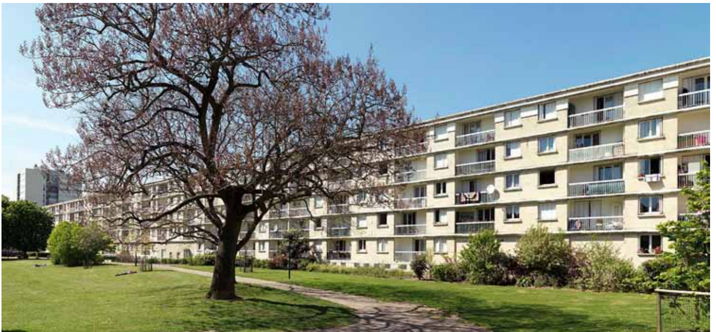
Façade arrière sur jardin de la barre A.
