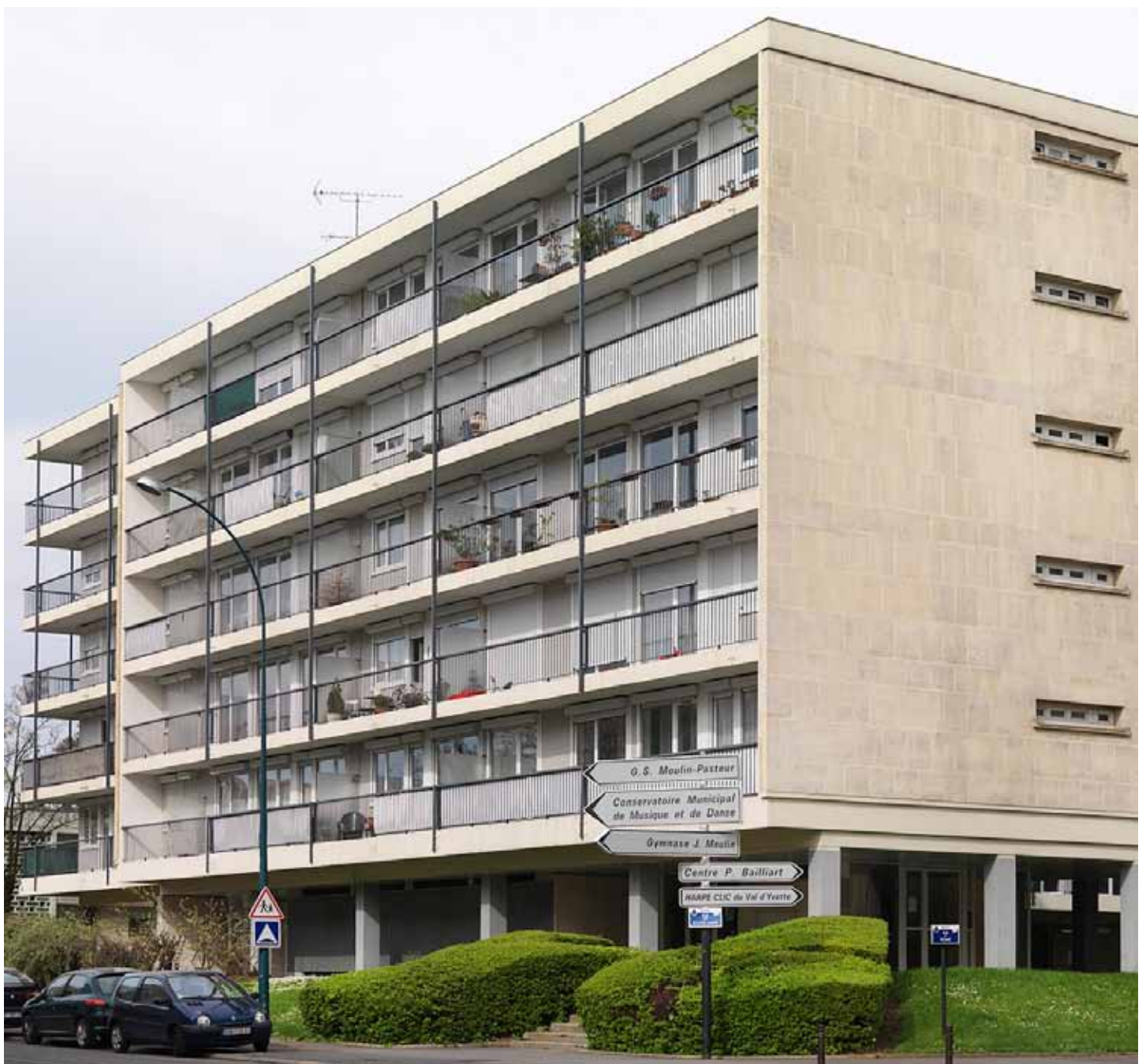
La façade située rue des Etats-Unis. Elle est identique à l'autre façade avec des balcons et garde-corps filant le long du bâtiment. Seul le pignon est différent puisqu'il est plein avec une imposte par niveau au centre de la façade.
