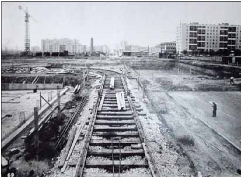
Le chemin de rail sur le chantier de construction.
