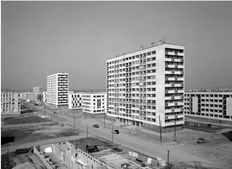
Le chantier de construction avenue de Bourgogne.
