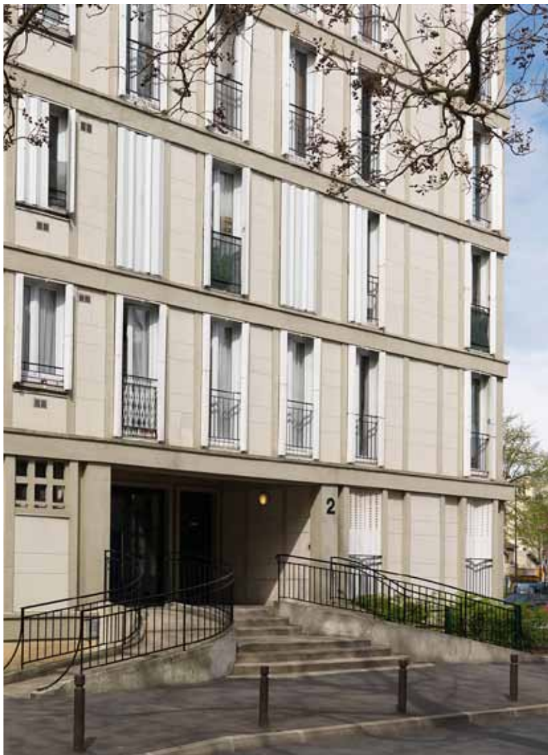
Entrée d'immeuble avec un escalier à volée droite dans l'alignement et double rampe d'accès en volute sur les côtés.
