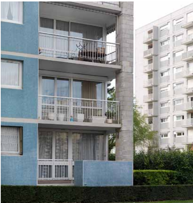
Pignon du bâtiment 3 situé avenue du Noyer-Lambert. On remarque l'ouverture latérale des balcons et le décor réalisé en mosaïque de grès cérame bleu. Décrochement du balcon situé au rez-de-chaussée pour rythmer la façade.
