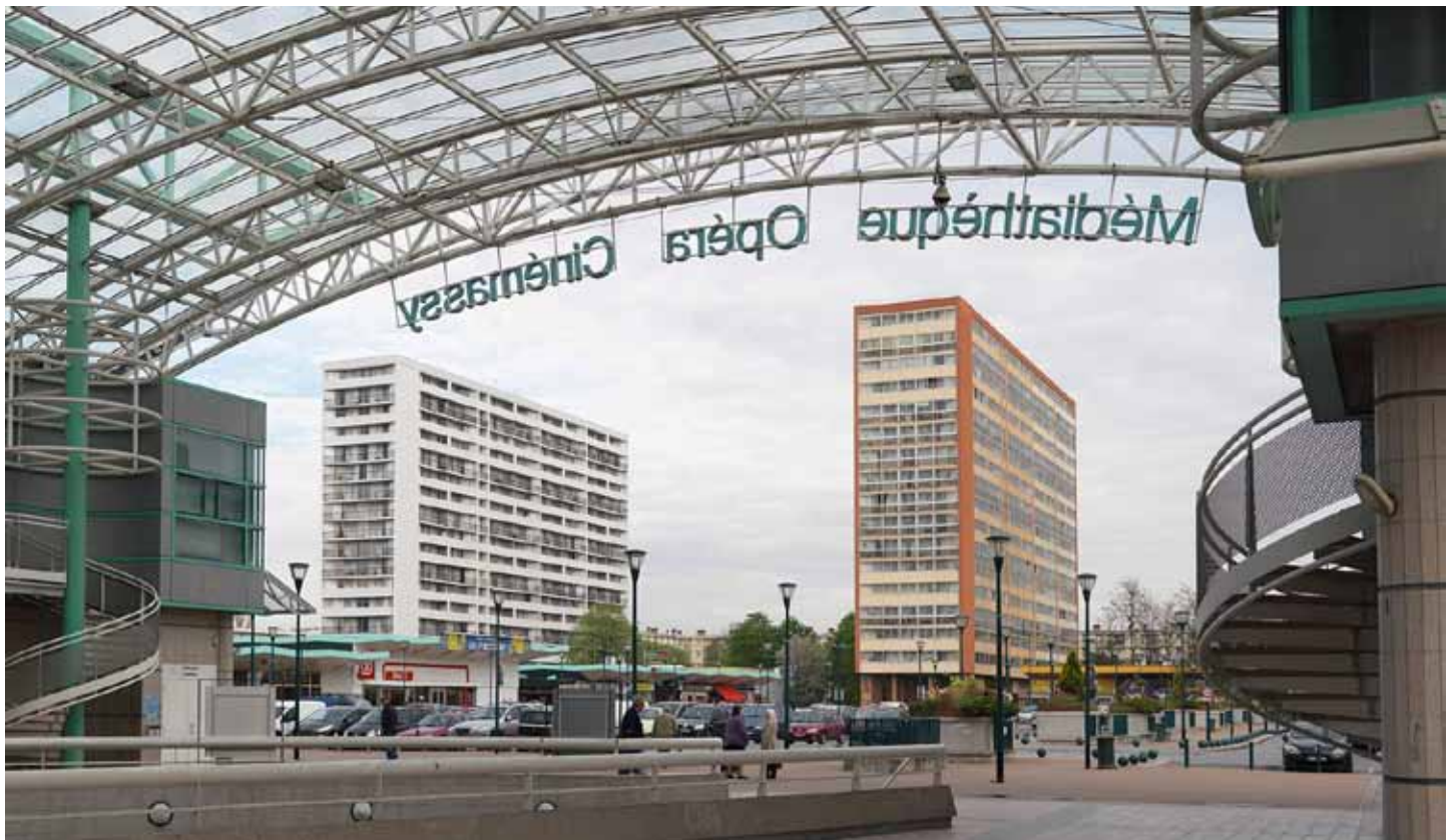
La place de France avec deux des trois barres construites par les architectes Pierre Sonrel et Jean Duthilleul vues depuis le parvis piétonnier de l'opéra.
