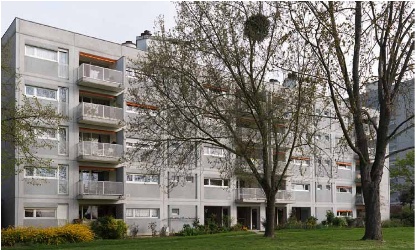
Le rez-de-chaussée de la barre F.
