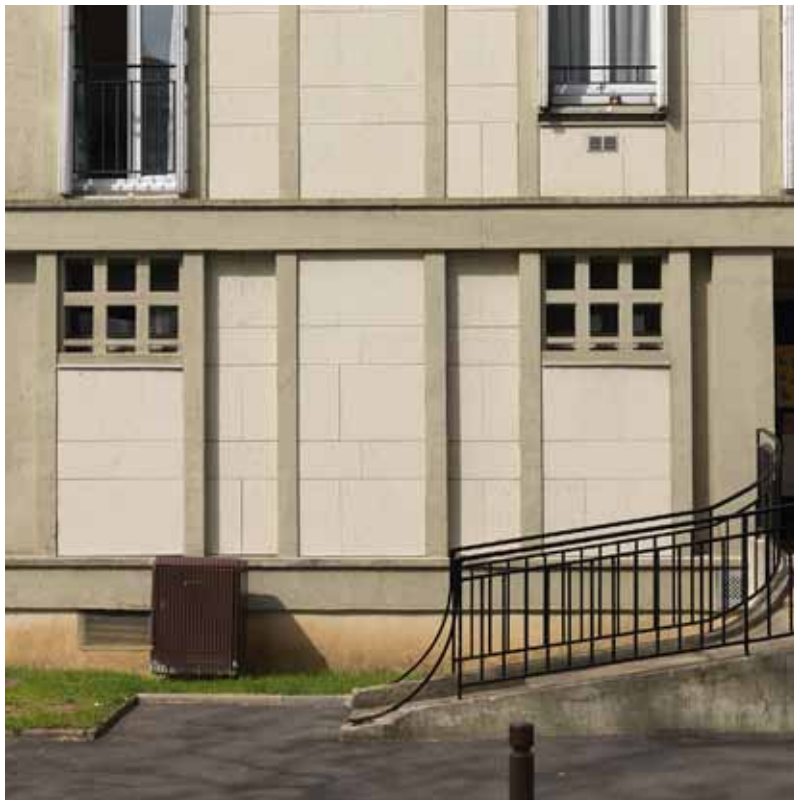
Façade avec une partie de la rampe d'accès. Les fenêtres du rez-de-chaussée ont été remplacées par de petites ouvertures avec un quadrillage de sécurité en béton.
