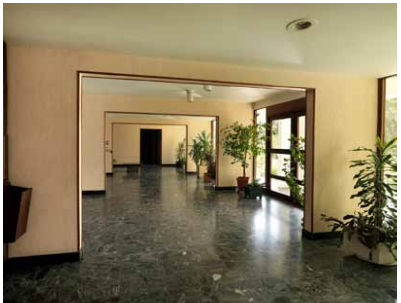
Vue du hall d'entrée de la barre E. Les boiseries, le mobilier intégré et le carrelage de marbre sont des éléments d'origine.
