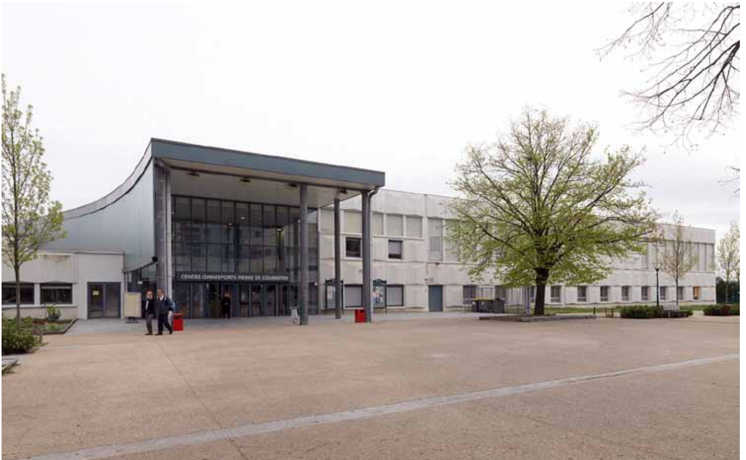
Parvis et entrée du centre omnisports Pierre de Coubertin. La réfection du parvis a été réalisée en 2006 ainsi que l'entrée avec le porche.
