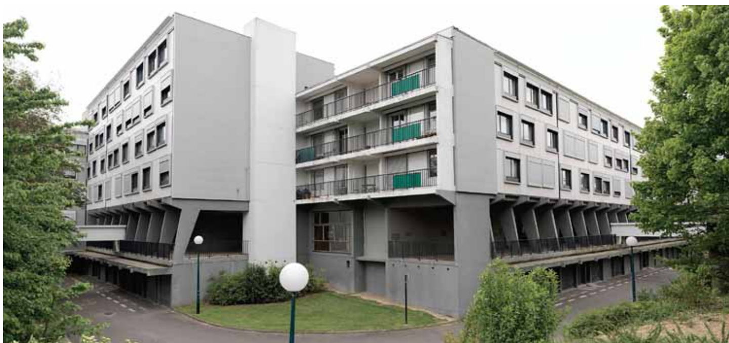
Les barres E et F. La structuration verticale du bâtiment est organisée à partir de box fermé sur une rue située contrebas de l'immeuble, d'un rez-de-chaussée sur pilotis accédant à des parking en rez-de-chaussée par des passerelles, d'une élévation de trois ou quatre étages selon les immeubles.
