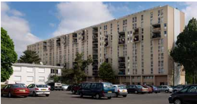
Barre R+10 avec les loggias sur séjour décalées en façade.
