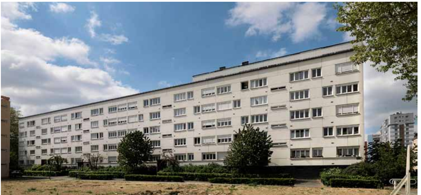
Façade arrière de la barre H.
