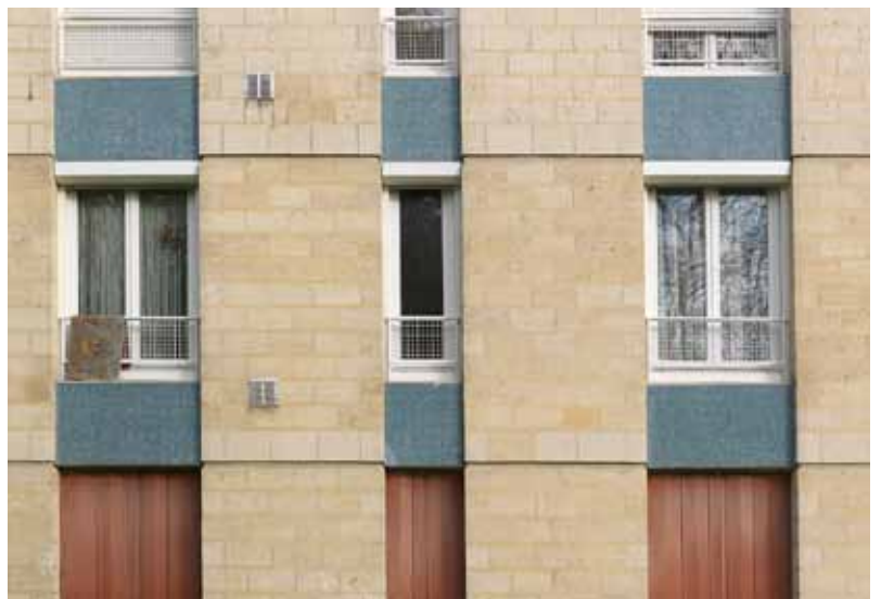
Détail de la partie inférieure d'une façade. Fenêtres étroites verticales et allèges accentuent la verticalité renforcée par l'usage des matériaux alternés : pierre de Saint-Maximin et mosaïque de grès cérame bleu.
