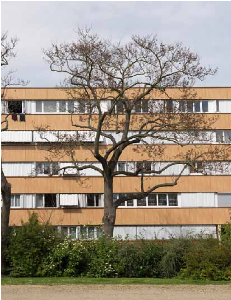
Passage traversant au rez-de-chaussée permettant l'accès au parking de l'allée du Béarn et au parc Descartes de l'autre côté du bâtiment.
