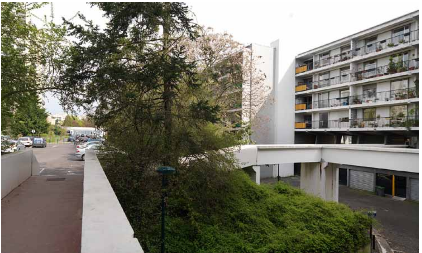
Parking souterrain, parking de plain-pied et passerelle d'accès des bâtiments au parking extérieur.
