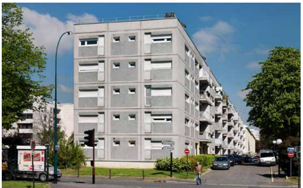
Vue de la barre A. mur pignon avec deux types de modules : fenêtres doubles (l'une verticale et l'autre en bandeau) pour les chambres, lucarne pour les dégagements et pièce d'eau.
