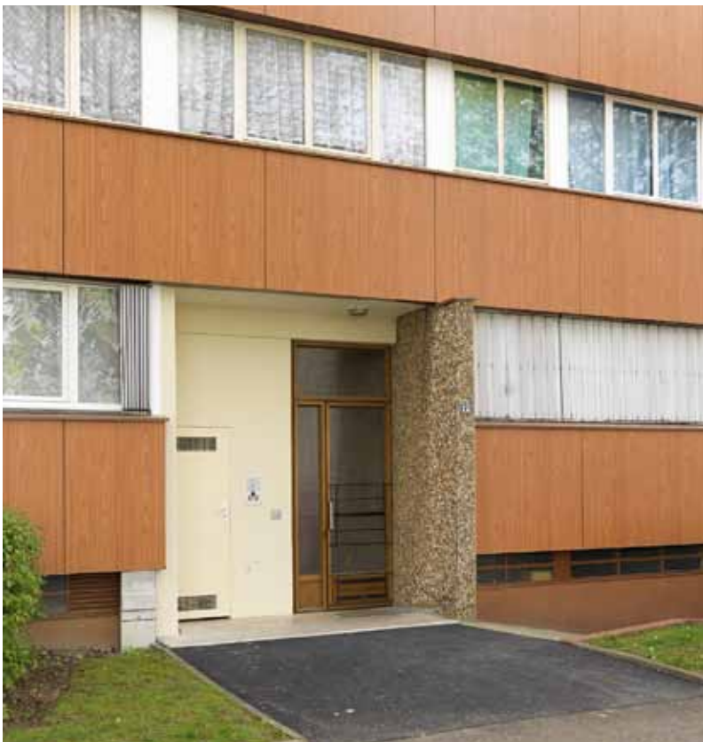
Une entrée d'immeuble. L'entrée étroite et désaxée est délimité sur un côté par un mur en granito. Les façades ont été réhabilitées fin 2010 par la pose de plaques isolantes à l'extérieur.
