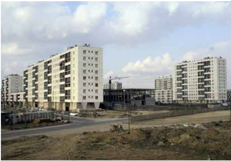
Le chantier de construction des barres F, G, H et J depuis l'avenue du Noyer Lambert. 1965. © MEEDDAT.
