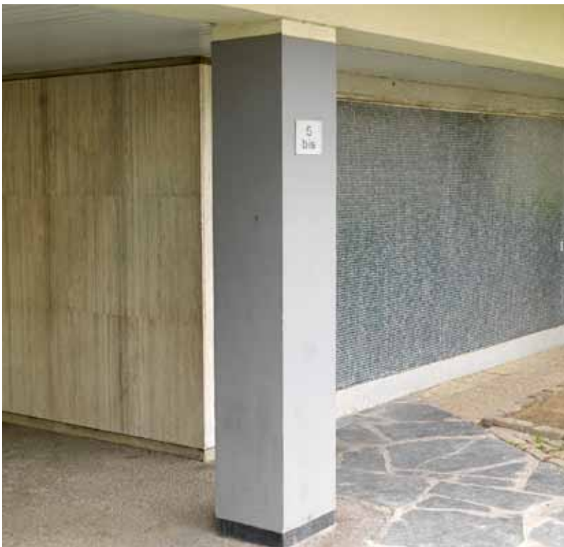
Détail d'un pilier du rez-de-chaussée. Les murs en arrière-plan alternent pierre brute et mosaïque de grès cérame bleu-gris.
