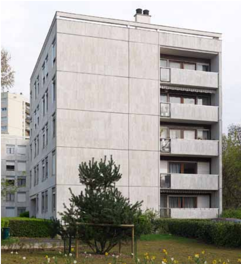
Ce pignon est constitué de panneaux préfabriqués (système Raymond Camus) en travertin romain. On distingue deux panneaux pleins et panneaux de loggia avec balcon dont le garde-corps est également préfabriqué en travertin, ce qui donne une unité à l'ensemble.
