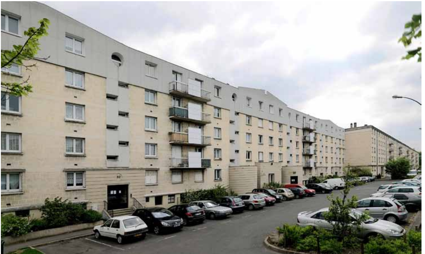
La barre A après rénovation.
