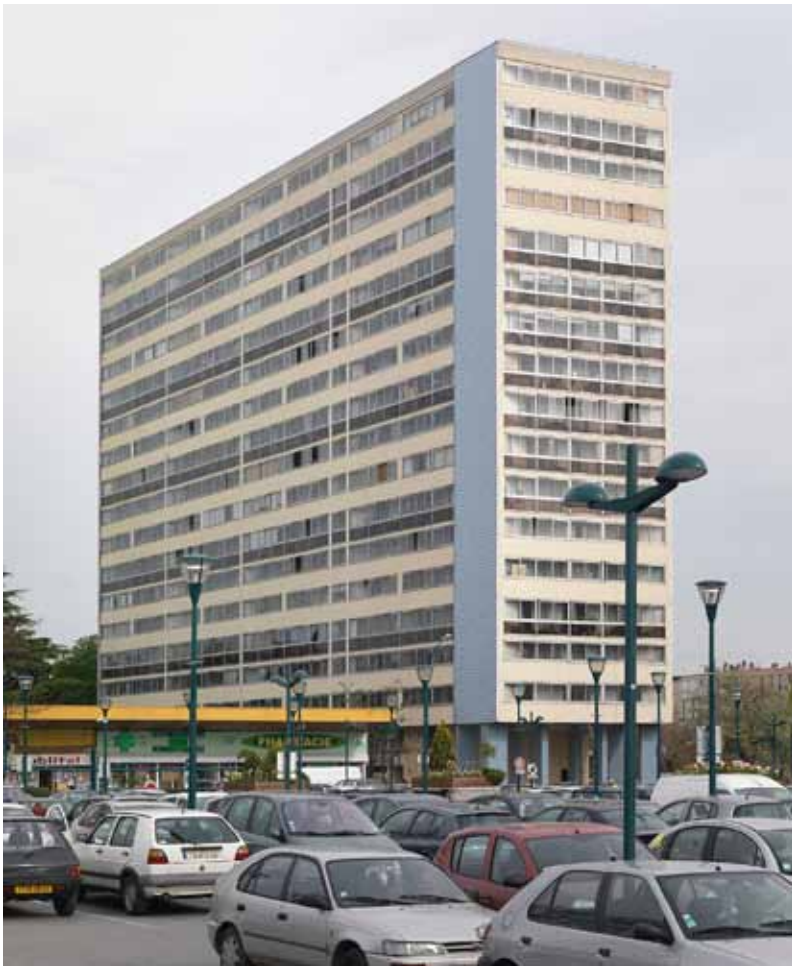
Une des barres R+16 réhabilitée dans les années 1980 pour l'isolation : les loggias ont toutes été fermées et certaines parties de la façade ont été recouvertes d'isolant bleu.
