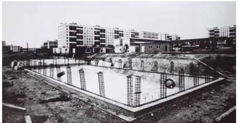
Vue du chantier de construction : la piscine.
