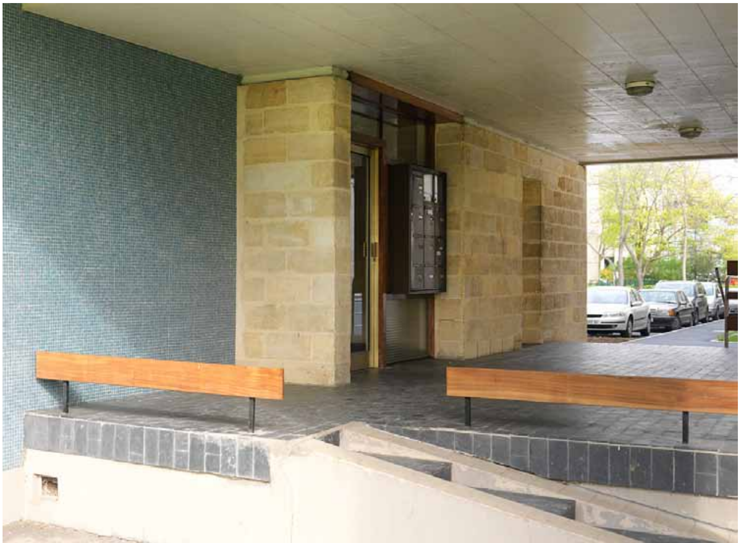
Détail d'un sous-porche traversant : l'entrée de l'immeuble peut se faire par le parking (square Jean-Bouin) ou par les allées du parc de la Blanchette.
