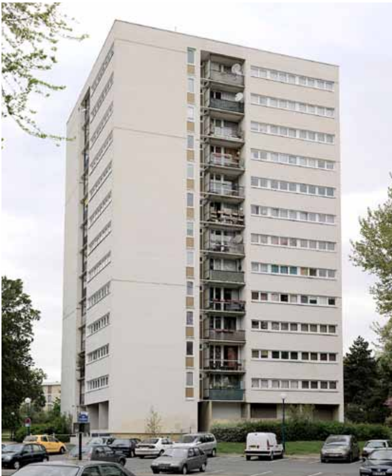
Vue générale de la tour N.
