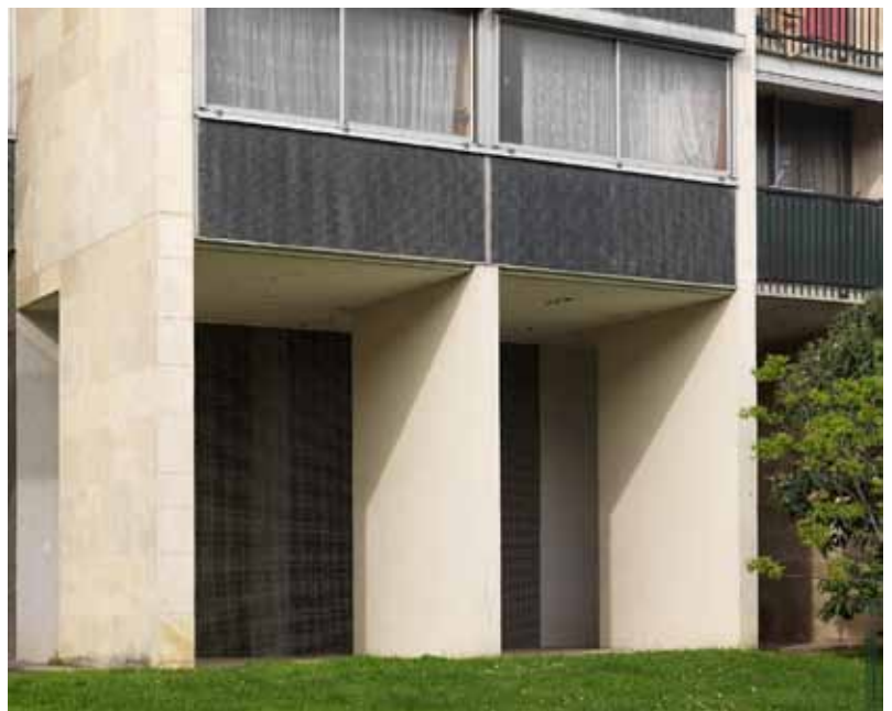
Rez-de-chaussée d'une barre R+13 située avenue Nationale. Les rez-de-chaussée occupent deux niveaux et sont coupés par des murs rideaux formant une galerie couverte autour de l'immeuble.
