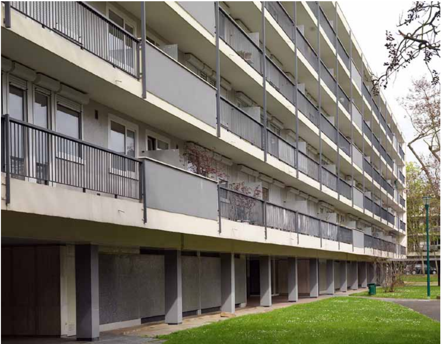
La façade côté jardin. Les rez-de-chaussée sont traversant, les piliers permettant la circulation des piétons. Les façades sont animés de balcons filants avec garde-corps métalliques.
