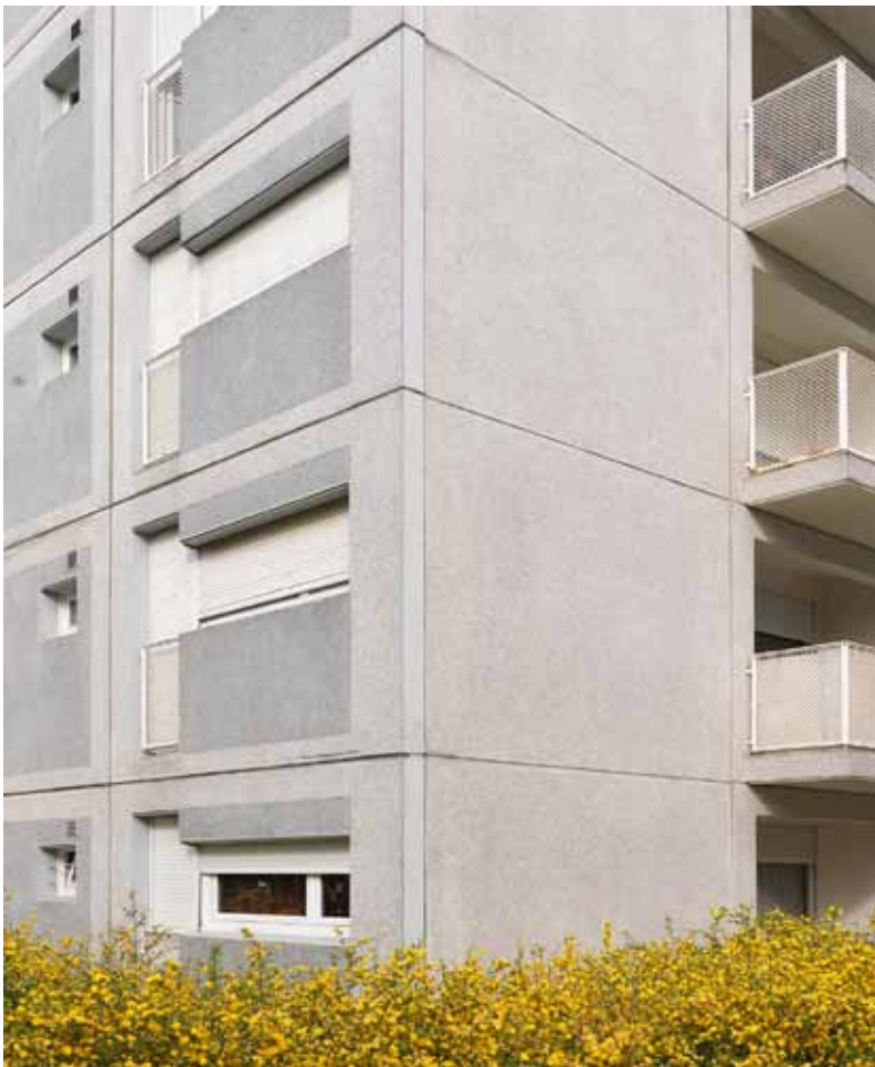
Pignon d'une façade. Les combinaisons des différents modules permettent d'individualiser les façades. Ici : module avec balcon, module plein (employé uniquement pour les pignons), module avec ouverture en L et un module avec deux petites fenêtres. Cette technique permet d'attribuer un type de fenêtre par type de pièce, il est donc possible de comprendre l'aménagement intérieur grâce à la lecture d'une façade.
