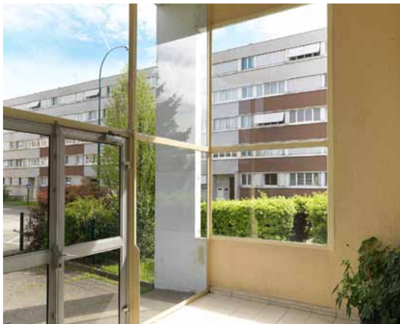
Le Hall d'entrée caractérisé de grandes baies vitrées autour de la porte et se prolongeant sur le côté. L'originalité de l'architecture repose sur le décalage entre le mur extérieur et la vitre. La vitre n'est pas fixée au mur extérieur mais se prolonge sur le pignon extérieur.
