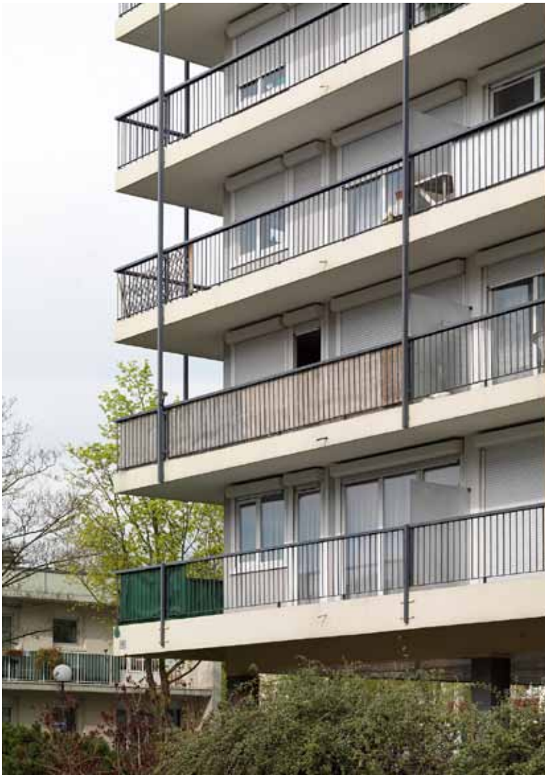
La façade côté rue : les angles sont ouverts et les balcons filants s'articulent autour de la façade.
