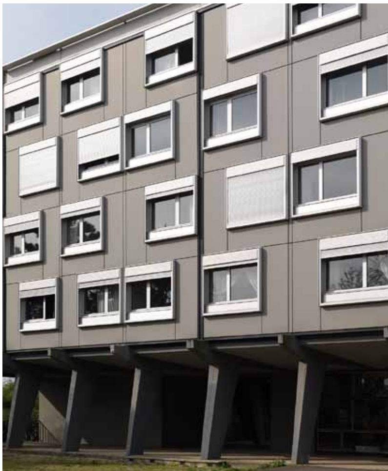
Façade et huisseries rénovées.
