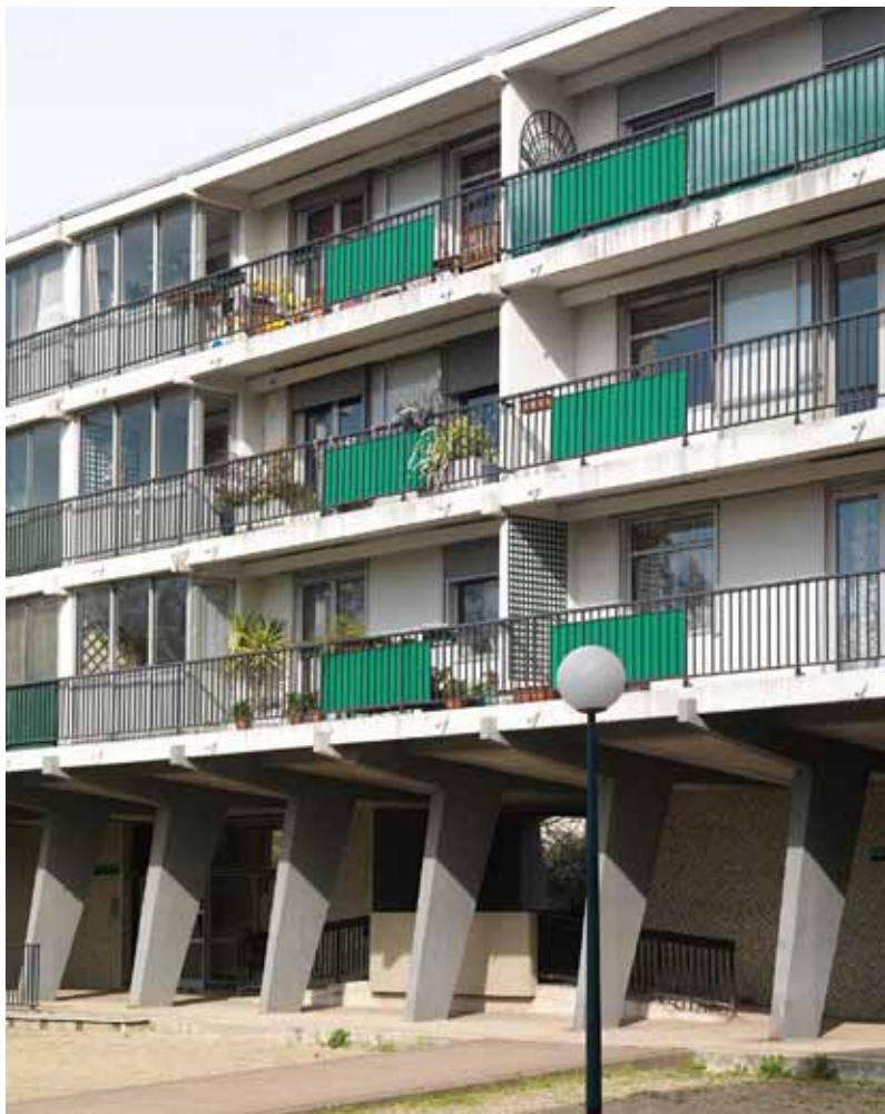
Façade non rénovée avec balcons et mosaïque d'origine.
