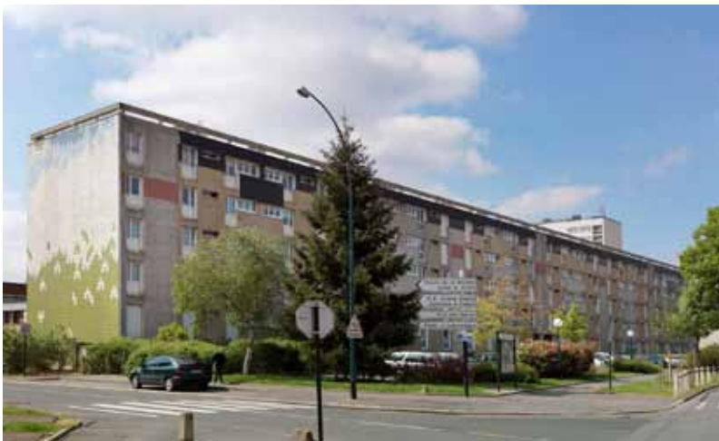
Façade arrière et pignon décoré avant rénovation de la barre A.
