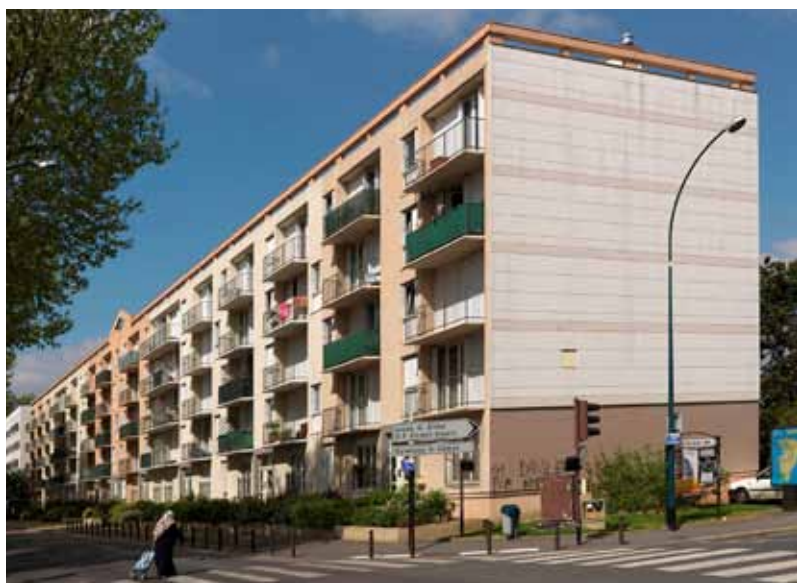
Façade principale et pignon de la barre H.
