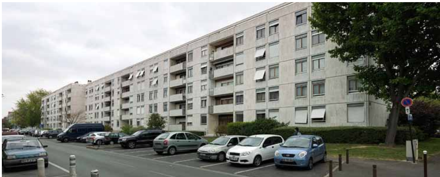
Vue générale de la barre B.
