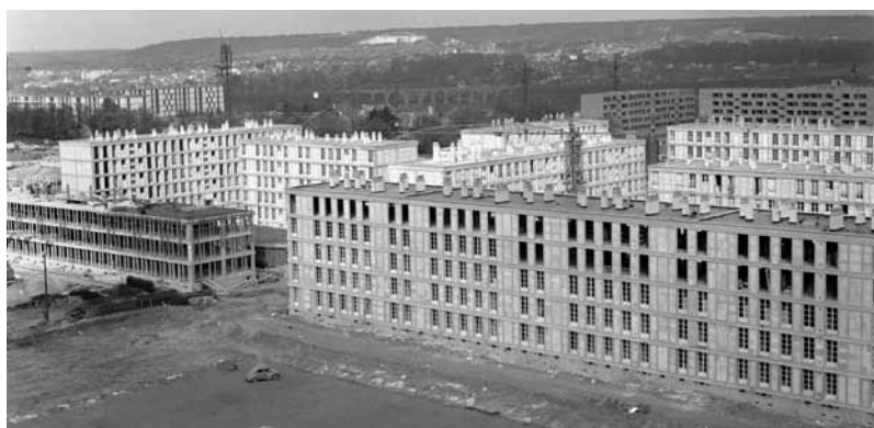
Vue générale du chantier de construction.
