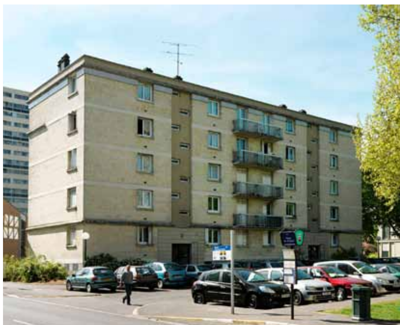
Façade principale sur parking de la barre B.
