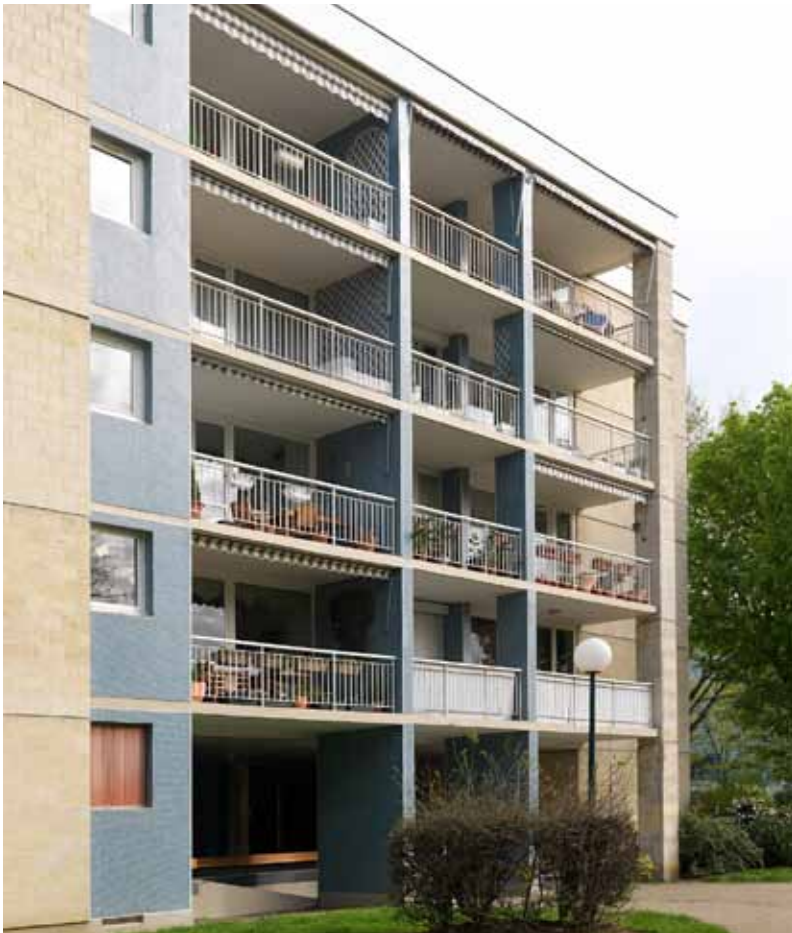
Façade principale du bâtiment 3 en L situé côté parc de la Blanchette. Ce corps de bâtiment constitue la retour du L marqué par le décrochement au niveau du balcon de droite. La façade est rythmée verticalement par les refends porteurs qui se prolongent horizontalement sur les balcons et verticalement pour jouer le rôle de pilotis. L'alternance de la pierre de Saint-Maximin et de la mosaïque bleue rythme la façade.
