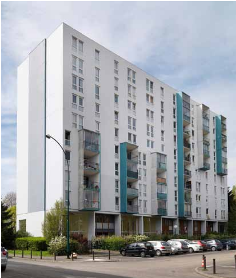
Barre R+10 située à l'est du grand ensemble. Les appartements sont traversant et possèdent tous une loggia. Afin d'éviter d'avoir une façade plane, les architectes ont réparties les loggias entre les deux façades.
