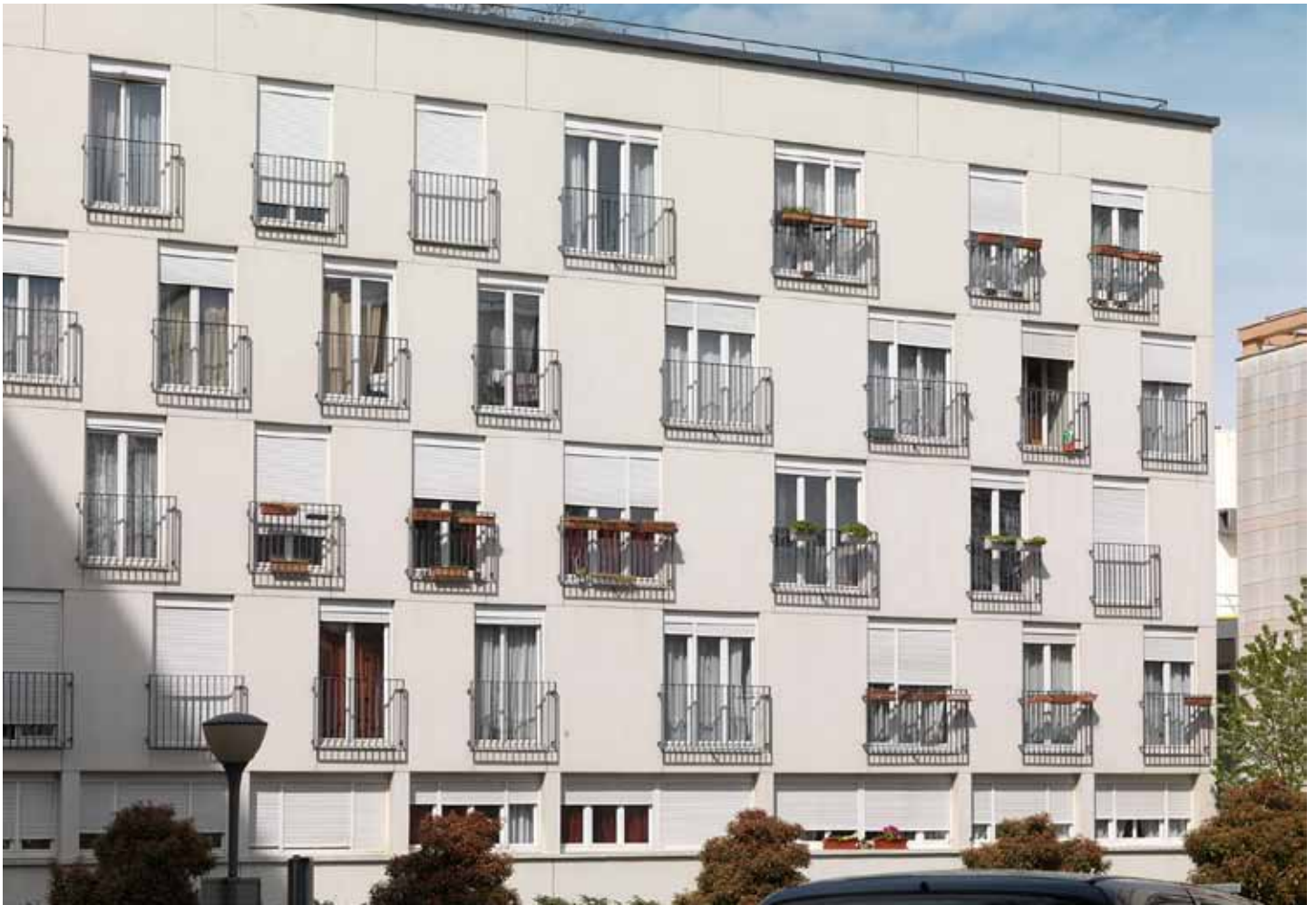
Vue de la façade côté rue avec deux types de fenêtres ayant toutes des garde-corps métalliques. La réhabilitation des façades a été réalisée en 2004, financée en Palulos.
