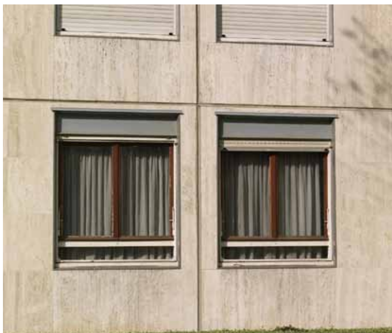
Détail de panneaux de fenêtres. Préfabriqués selon le procédé Raymond Camus. Les fenêtres sont placées à gauche ou à droite du panneau ce qui permet de jouer sur la composition de la façade, ici les architectes ont rapproché les fenêtres.
