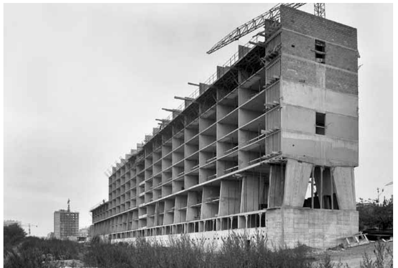
Vue du chantier de construction des barres G et H.
