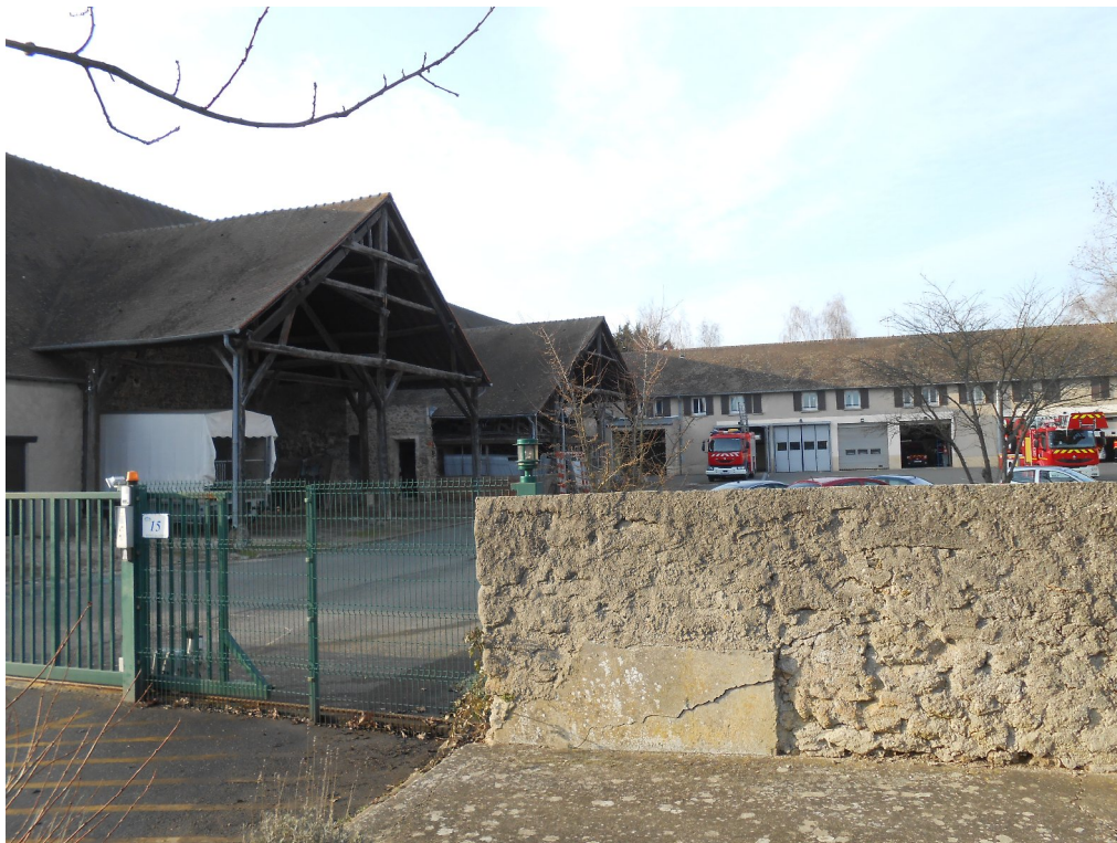
Vue générale de la ferme du Grand Vivier.
