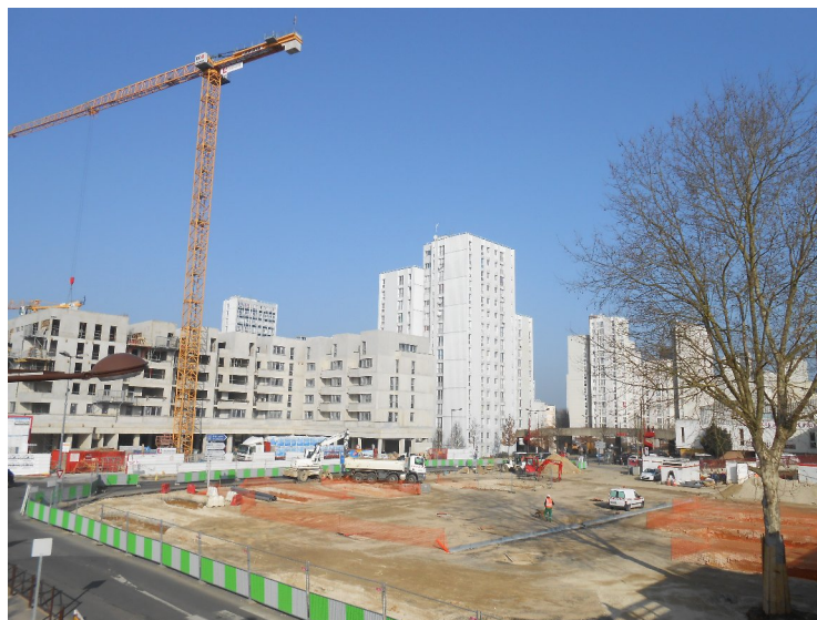
Travaux de la place du marché en mars 2013. A l'arrière-plan, la résidence des Hautes Bergères.
