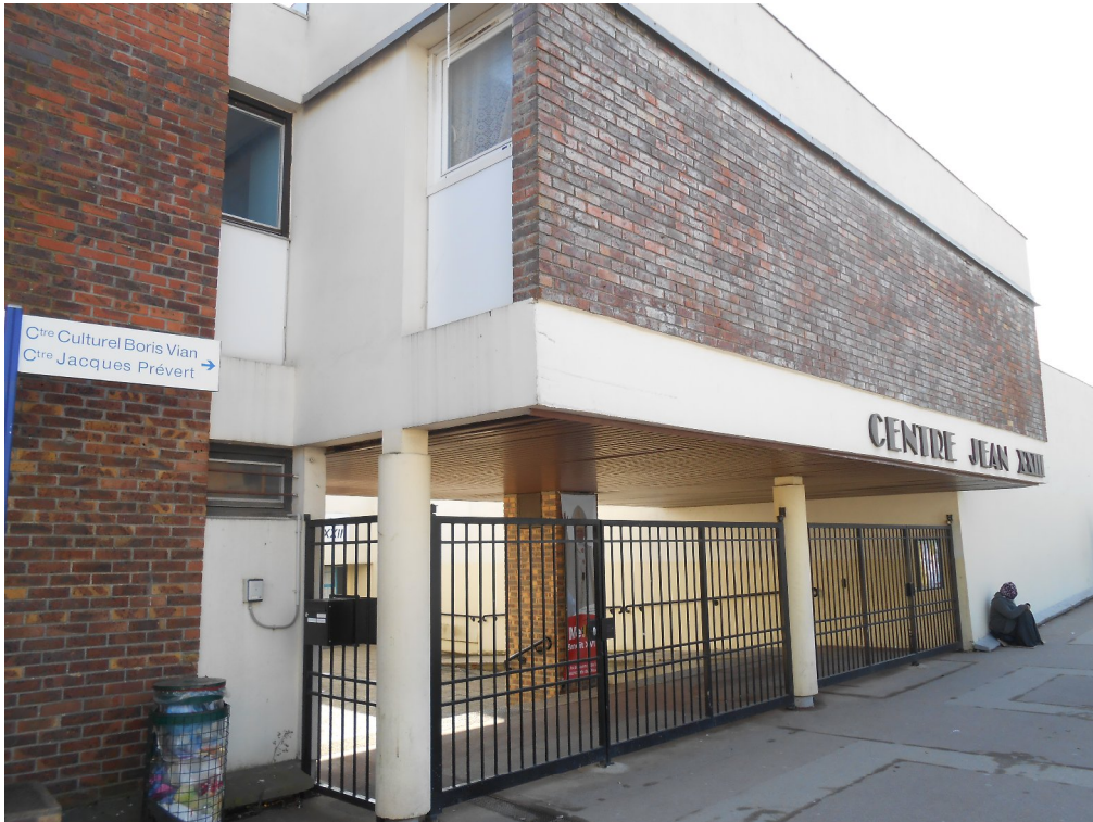
Le centre culturel Jean XXIII, achevé en 1977 et bâti sur des plans de François Prieur, sur la dalle où se trouvent concentrés les équipements publics du centre-ville. Il a été réalisé grâce à la constitution, dès 1968, d'une association pour l'équipement culturel des Ulis, fondée sous l'impulsion du père Havar, responsable des Chantiers Diocésains. Les murs, en béton banché, sont revêtus de briques dites de Vaugirard, utilisées en parement.
