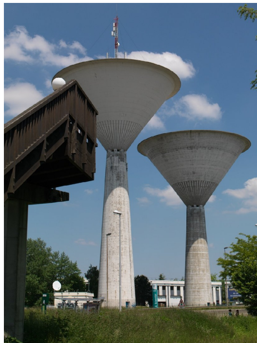
Les deux châteaux d'eau, à l'entrée de la ZA de Courtaboeuf.
