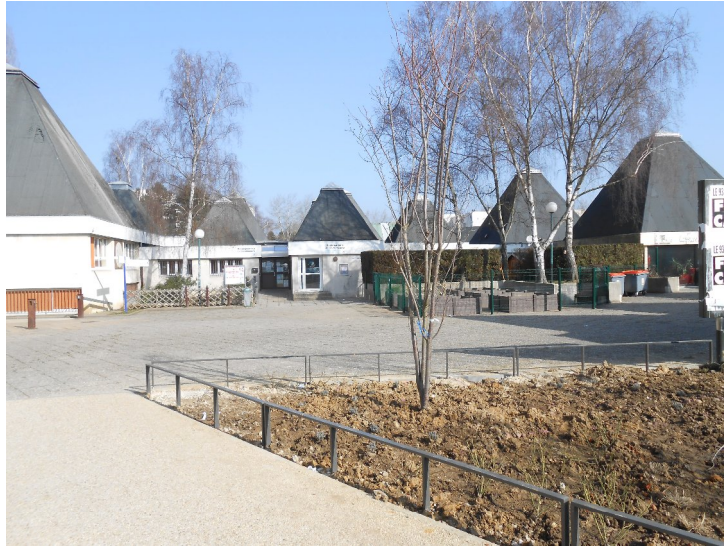
Vue générale du groupe scolaire de Courdimanche.
