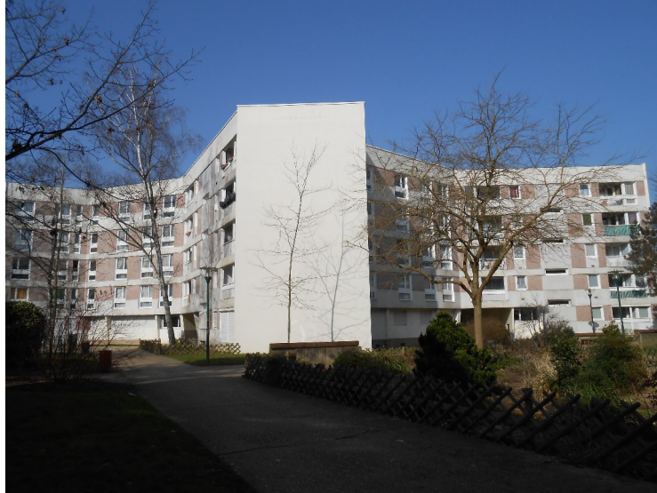
Vue générale de la résidence des Bathes. Les unités de logements sont en arc de cercle ; elles se rejoignent sur un mur-pignon aveugle.
