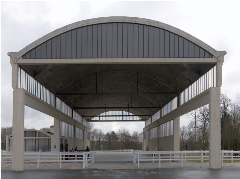
13a. Figure 13 a,b,c À Fontaine-le-Port, l'ancienne scierie Millet est remarquable par sa grande halle (a) qui supportait le pont-roulant et abritait les bancs de sciage.
