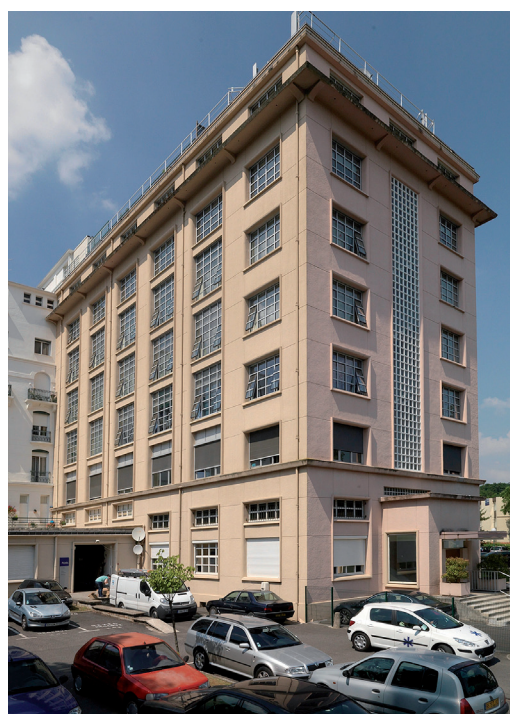
25. ancien hôtel Savoy. Le bâtiment initial, oeuvre de l'architecte Edouard Johan Niermans, est alors agrandi d'une aile perpendiculaire de 7 niveaux offrant 12000 m 2 de bureaux. La société PIC emploie alors 1200 salariés dont 400 sur le site d'Avon.
