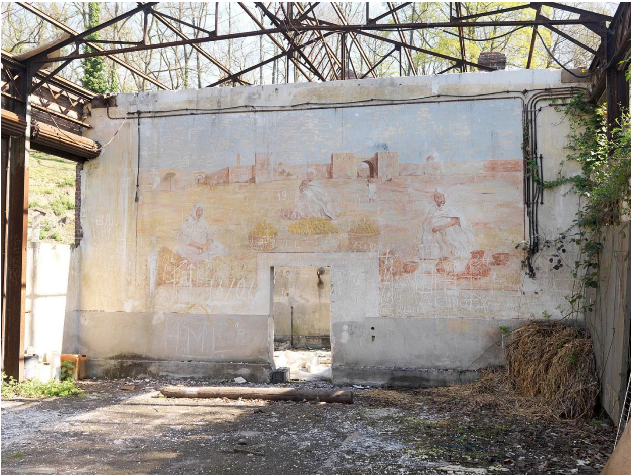
Le « hangar des harkis », avec sa charpente métallique à nu, est ainsi baptisé à cause de la fresque qui orne l'un des murs-pignons intérieurs et représente des bédouins devant une citadelle au milieu du désert.
