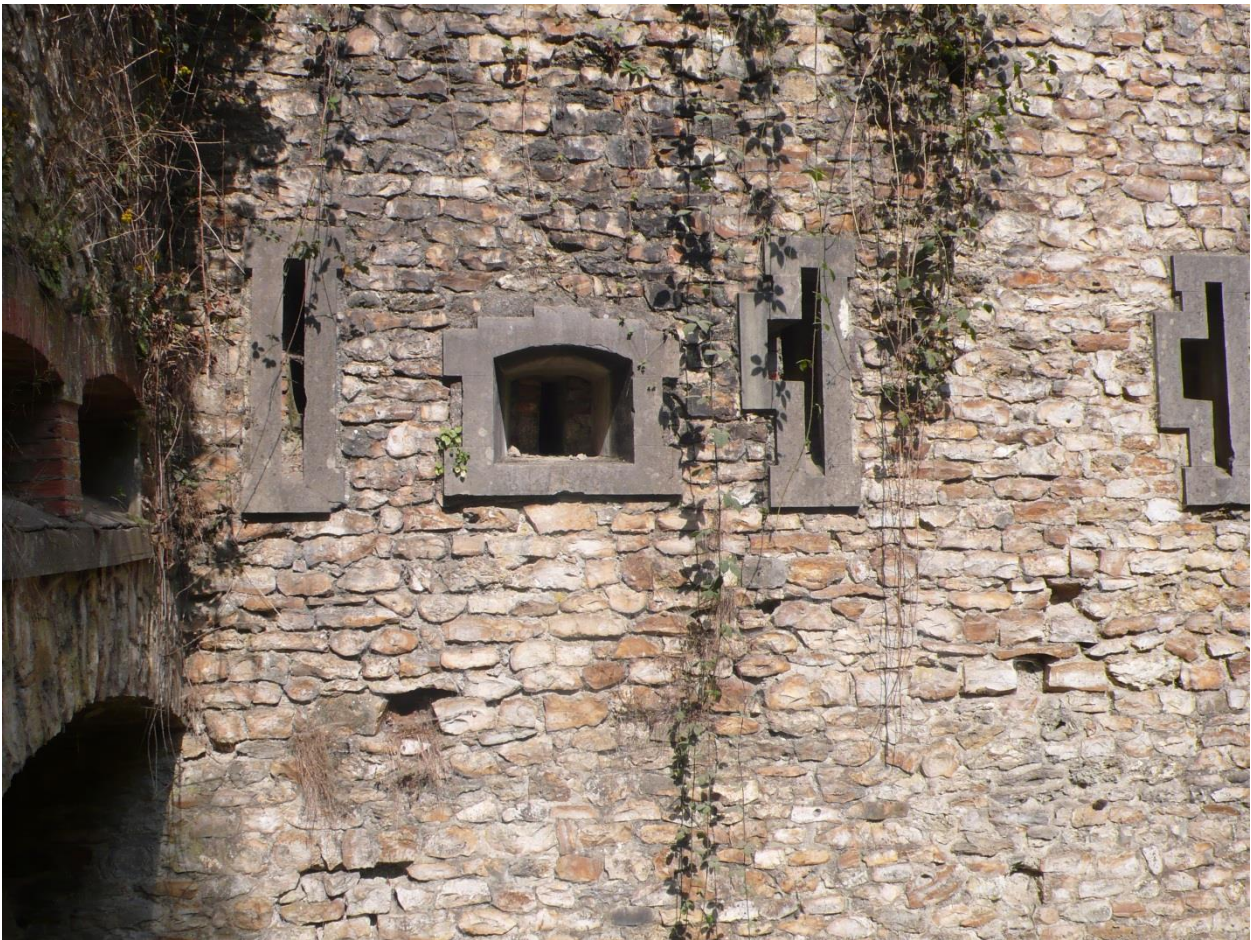
Vue rapprochée de la caponnière de gorge du fort de Cormeilles. Comme le montre ce cliché, les ouvertures de tir ont été renforcées avec du béton, qui est venu masquer les encadrements de brique d'origine (encore visibles à gauche).
