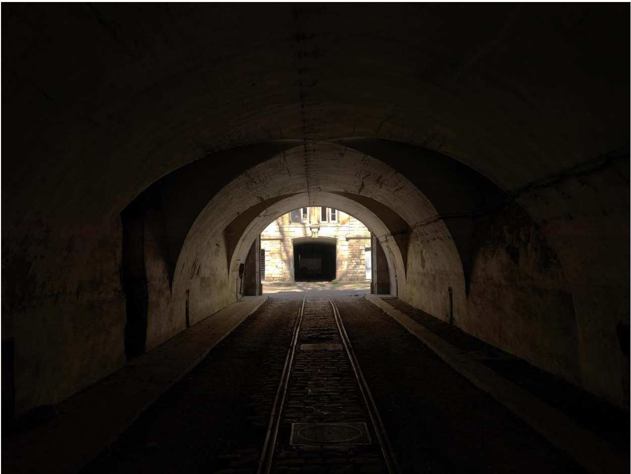
Un passage couvert conduit de l'entrée vers la caserne des officiers. Au sol, les rails de la voie ferrée de un mètre installée dans le fort en 1876-1877.
