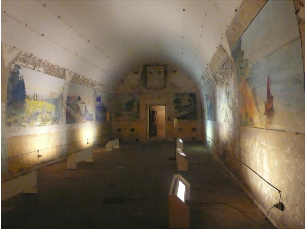
Le magasin à poudre du saillant IV est une pièce de plan rectangulaire voûtée en plein cintre.
