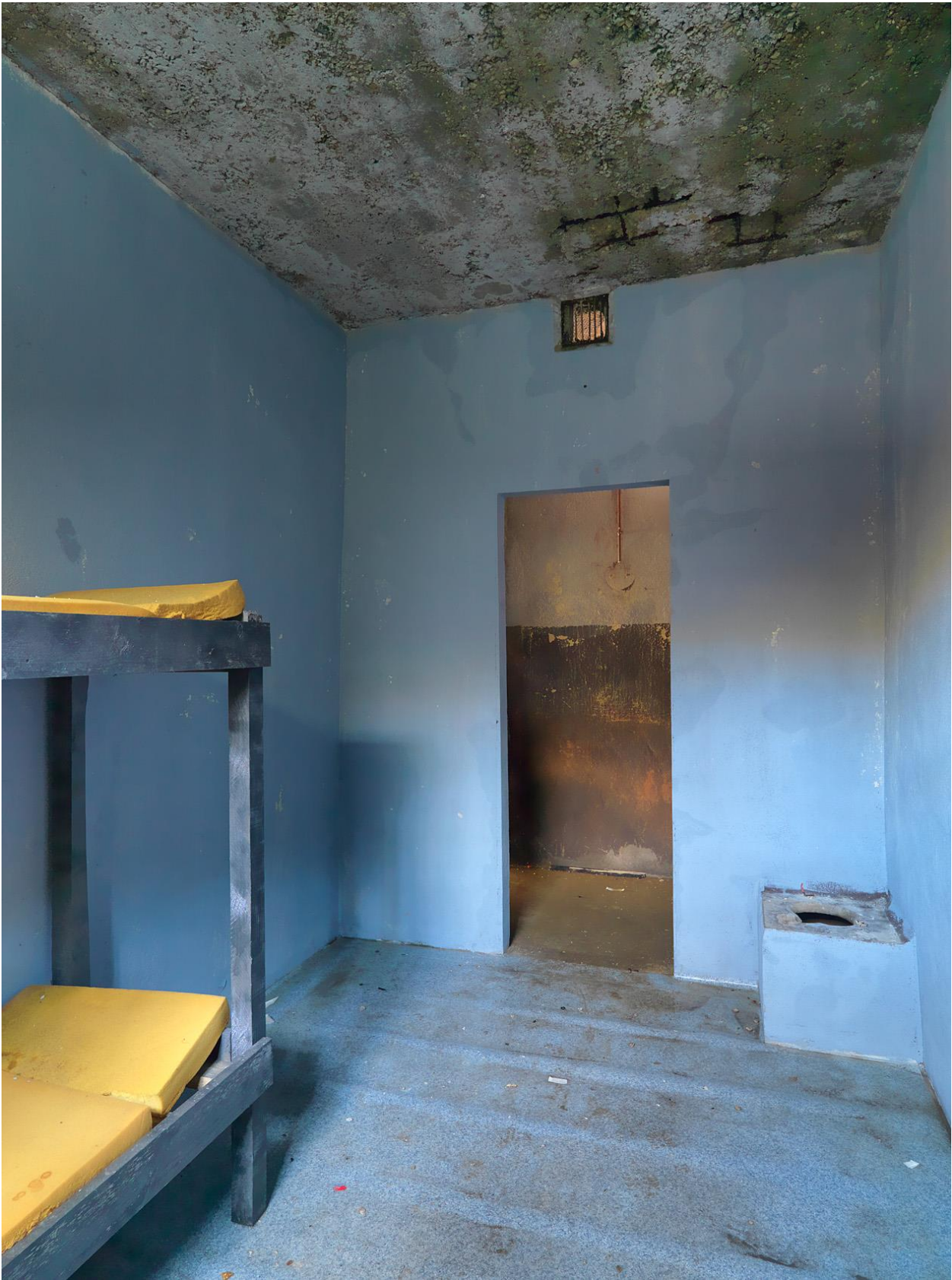
Cellule pour plusieurs détenus, dans le bâtiment en béton aujourd'hui détruit qui se trouvait au sud de la caserne de la troupe.
