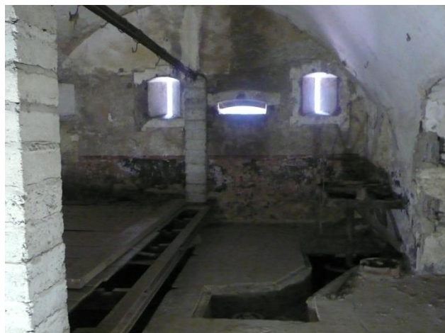
A gauche, plan des locaux d'entrée du fort de Corneilles, 1877. (Service Historique de la Défense, 2 V 105). A droite, une vue de la chambre contenant le mécanisme de recul pour le pont roulant , à l'ouest de l'entrée. Ce pont roulant s'escamote latéralement.
