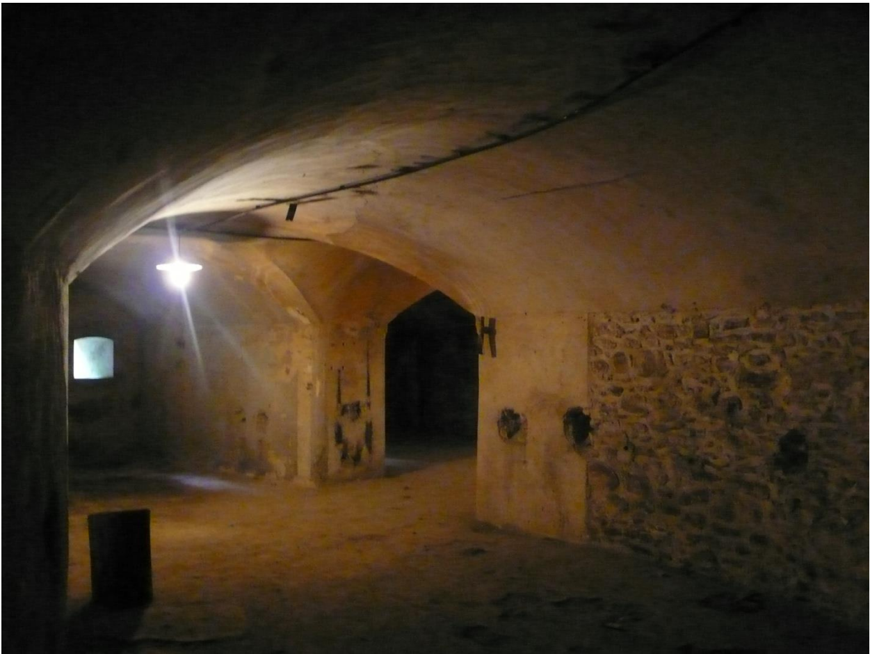
Intérieur de la caponnière double, constituée d'une enfilade de cellules à voûtes surbaissées au 1/6 e .
