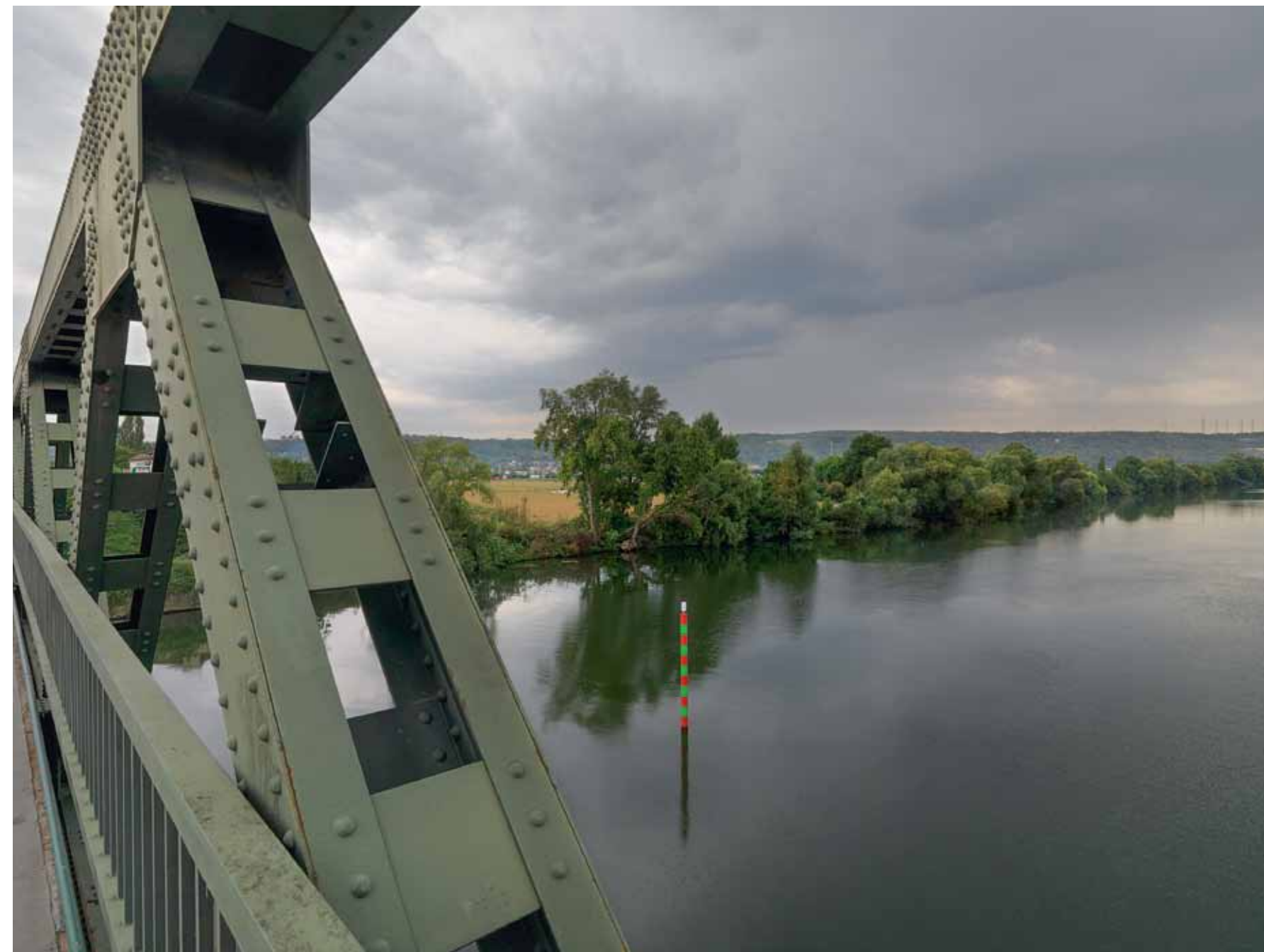
Pont de Rangipont à Épône.
