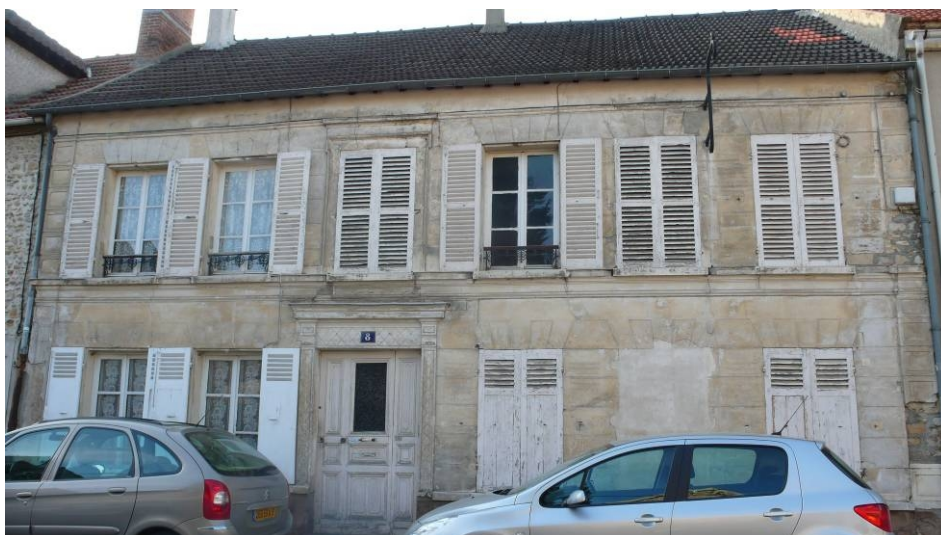
ETR85 (8, Grande Rue) est une maison de bourg « ante-cadastre » de six travées et un étage carré. La façade sur rue a conservé son enduit d'origine dont la modénature est particulièrement soignée. Seule la couverture du bâtiment semble avoir été modifiée par rapport à son état d'origine.
