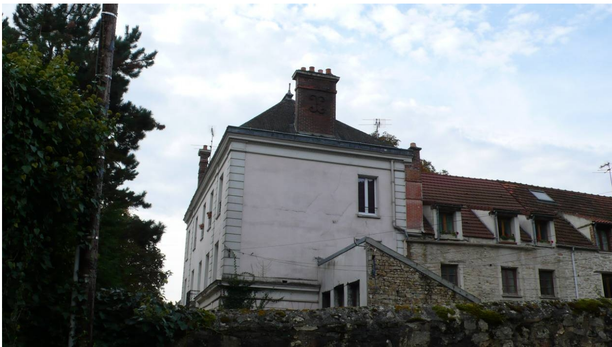
Maison de notable située dans le hameau de Fontaineliveau : les annexes ont été entièrement transformées par le percement de baies et l'ajout de lucarnes, une aile en appentis a été accolée au corps central de la maison de notable. Il semblerait en revanche que le corps central n'ait pas subi de transformations majeures et qu'il ait conservé sa modénature d'origine.
