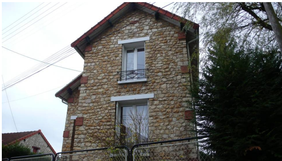
ETR281 (5, rue de la Croix Boissée) fut construit au cours de la première moitié du XX e siècle à l'aide de moellons de meulière et de calcaire par l'entreprise de Mme G. Thissier. Le pavillon présente un plan en « L » et possède un décor en parement de briques au niveau des chaînes d'angle.
