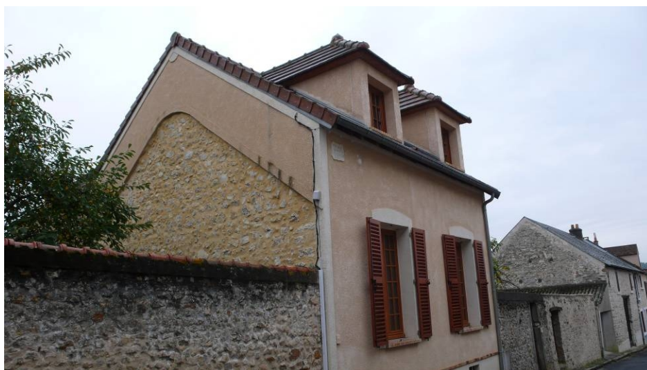
Bâtiment dénaturé situé au 12, rue du Haut Puits : les travaux de surélévation qui ont permis d'aménager les combles et d'ajouter les lucarnes ont été réalisés par Michel Damien Casagrande en 2001.
