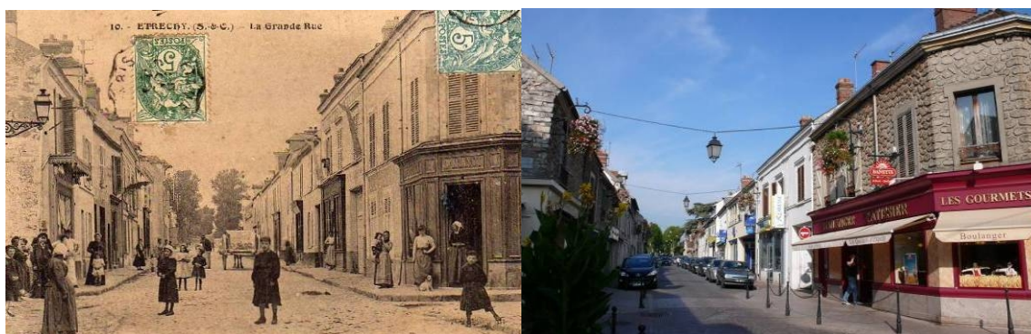
Carte postale, datant du début du XX e siècle, de la Grande Rue et photographie du même point de vue prise au cours du mois de septembre 2009.
