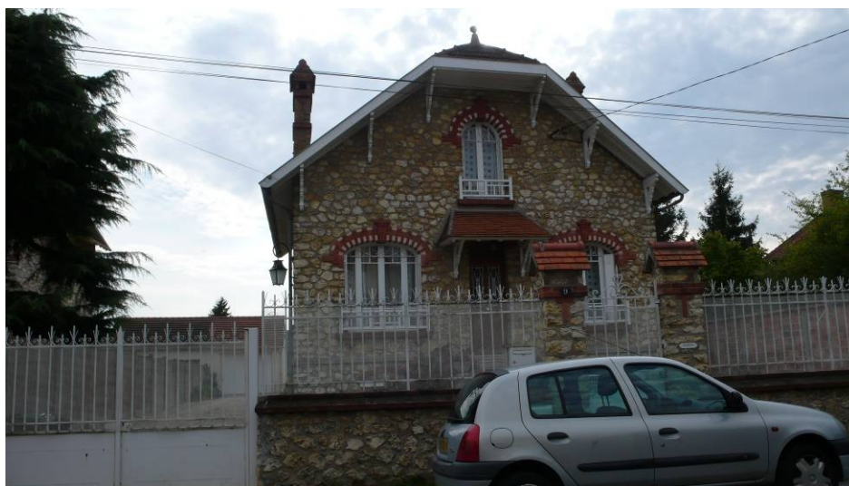
ETR241 (9, route de Chauffour) est construit en pierre calcaire. Les baies cintrées sont ornées d'un décor de briques bichromes. Le débord du toit à demi-croupe est supporté par des aisseliers en bois.
