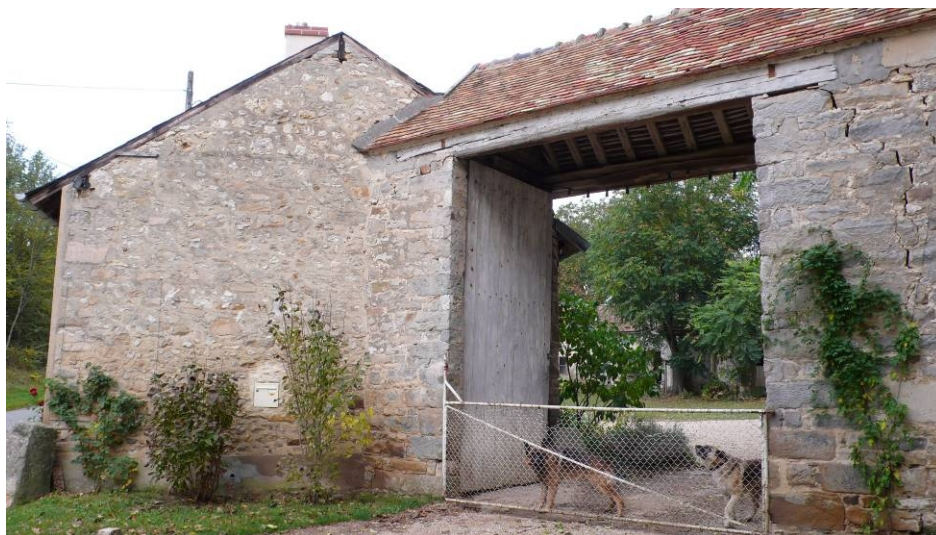
ETR201 est une grande ferme à cour fermée située à proximité du hameau de Fontaineliveau. Les murs des bâtiments sont constitués de moellons de meulière et de calcaire et renforcés par des chaînages d'angle en blocs de grès.
