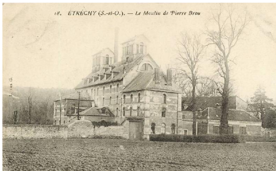
Carte postale ancienne du moulin de Pierre Brou sur laquelle on distingue les belvédères, aujourd'hui disparus, qui coiffaient le corps central du moulin.
