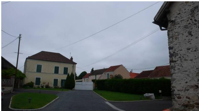
*ECH14 : logis « ante-cadastre » de la ferme située au 18-20, rue Jean Comte. La façade sur cour, recouverte d'enduit, est agrémentée d'un chaînage d'angle en décor de plâtre, d'une corniche et d'un bandeau vertical séparant le rez-de-chaussée du premier niveau.*
