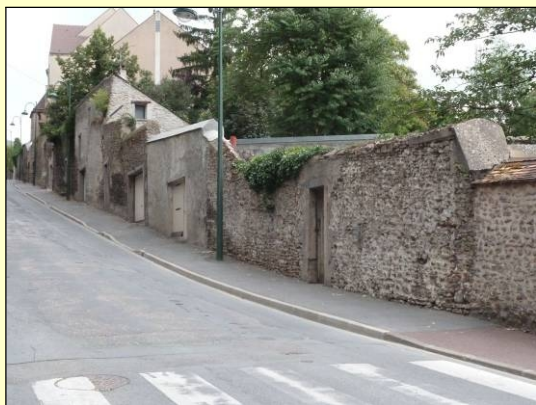
Les murs de l'ancien rempart de la ville.
