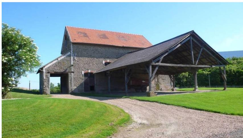
*VEG11 : Ancienne distillerie dont les baies cintrées possèdent un décor de briques caractéristique du XIX<sup>e</sup> siècle. La distillerie est flanquée d'un hangar à charpente en bois. Le déchargement des betteraves avant distillation se faisait au niveau de l'appentis.*
