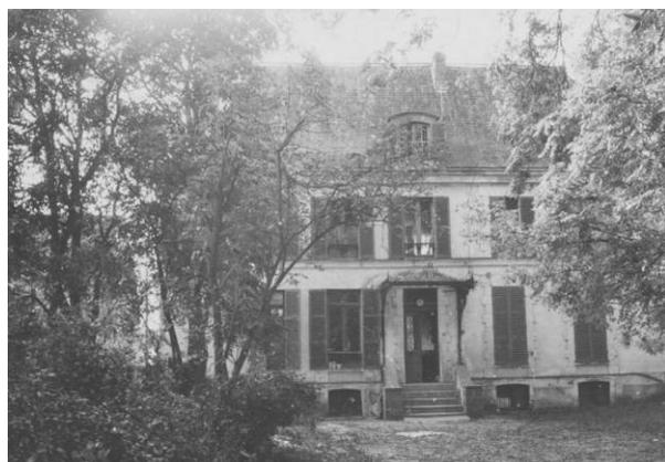
*VEG85 : bâtiment constitué de cinq travées et d'un étage carré surmonté d'un étage de combles. Un étage de combles supplémentaire a été ajouté par rapport à l'état constaté sur les photographies du dossier de pré-inventaire (1972). Le bâtiment est construit sur un sous-bassement en blocs de grès. La modénature a été conservée (encadrement des baies, bandeau horizontal, structure métallique de la marquise et corniche).*
