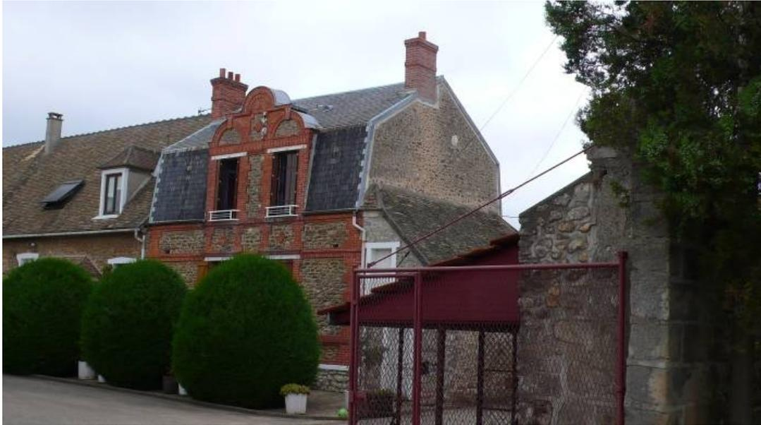
*Une partie du logis « ante-cadastre » de la ferme de Pocancy à Janville-sur-Juine (JAN02) a été reprise au cours du XIX<sup>e</sup> siècle. La pente du toit, à l'origine en bâtière, a été modifiée afin d'aménager les combles. L'ardoise a remplacé la tuile plate. On note également la présence d'une double lucarne à fronton trilobé et d'une modénature de briques caractéristique de la deuxième moitié du XIX<sup>e</sup> siècle.*
