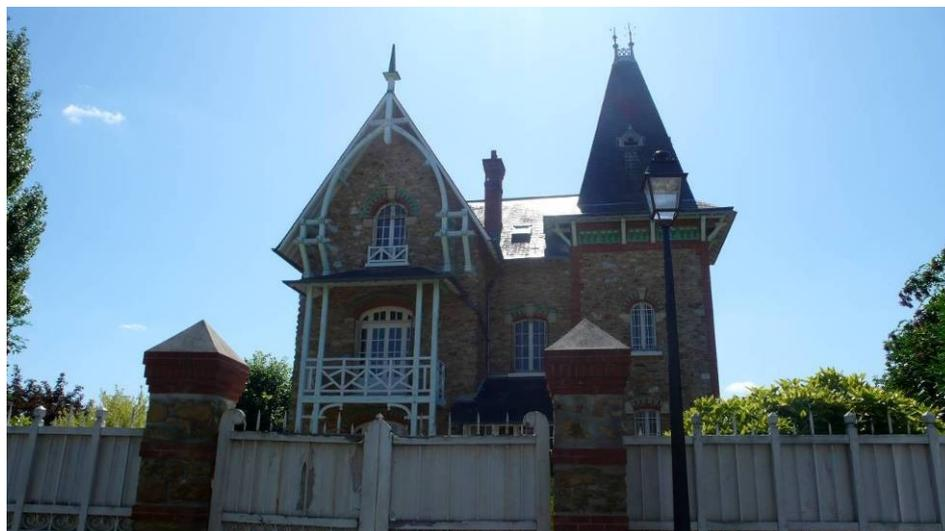
*LAR33 (19, rue de la Gare) a été construite par l'architecte E. Martin au cours du premier quart du XX<sup>e</sup> siècle. Cet édifice est composé d'un corps central en « L » et flanqué d'une tour d'escalier coiffé d'un toit en pavillon à égout retroussé. La modénature de briques et de carreaux de faïence émaillée est particulièrement soignée.*
