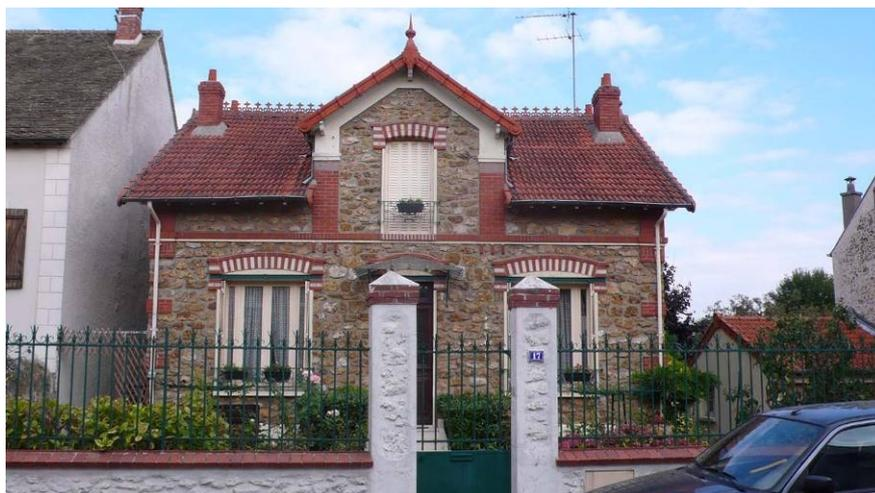
*La façade antérieure de MEN178 (17, rue de la Sablière) est située sur le mur gouttereau. Ce bâtiment a conservé l'ensemble de ses éléments de modénature : tuiles de rive, épis de faîtage, crête de faîte, décor de briques, linteaux métalliques associés à un décor de briques bi-chromes et ferronnerie.*
