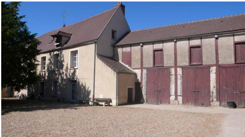
VEG11 : ancienne charreterie à structure porteuse en bois surmontée d'un grenier clos.
