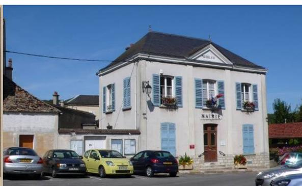
Photographie extraite de la Monographie de l'Instituteur et photographie de la mairie de Chamarande prise au cours du mois de septembre 2009 : on constate que la plupart des éléments de modénature de la façade ont été masqués par un enduit au ciment. Les souches de cheminée ont disparu et la date de construction de l'édifice a été ajoutée sur le fronton.
