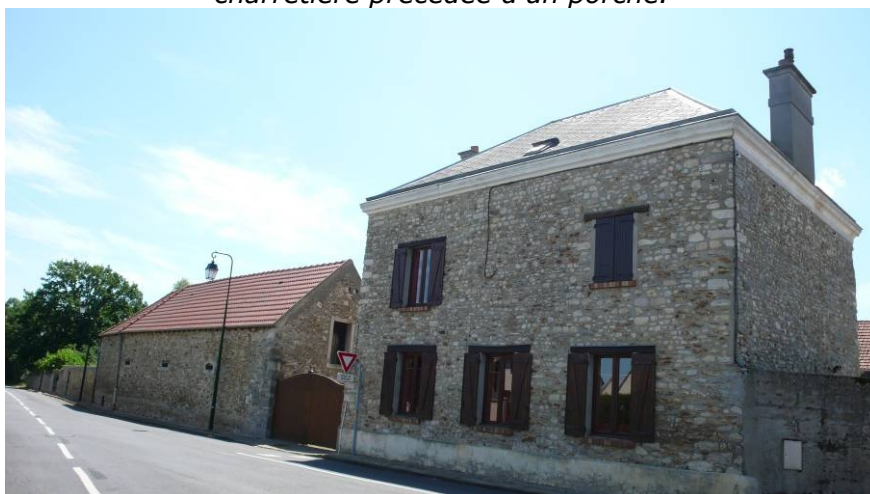
CLE05 : logis traité en maison de bourg. Les chaînages d'angle sont composés de blocs de grès et de blocs de calcaire grossièrement équarris.
