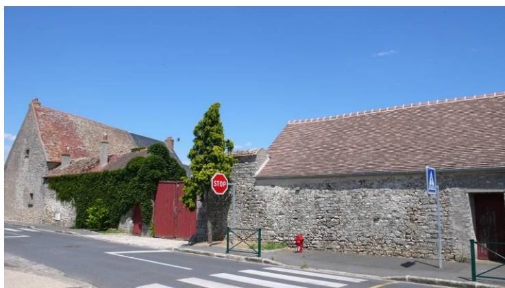
CLE05 : logis traité en maison de bourg. Les chaînages d'angle sont composés de blocs de grès et de blocs de calcaire grossièrement équarris.
