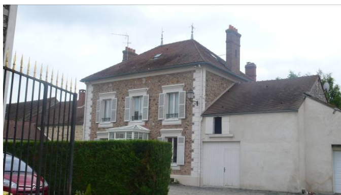
CHA15 (située au 15, rue des Bleuets dans le hameau de Louteville) est composée de deux bâtiments « ante-cadastrés » dont la maçonnerie est en partie constituée de blocs de grès de teinte orangée.
