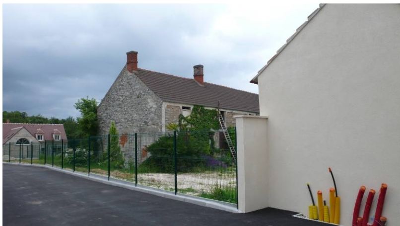
Voie passant au centre de la cour de l'ancienne ferme et permettant d'accéder aux divers pavillons construits en contre-bas.
