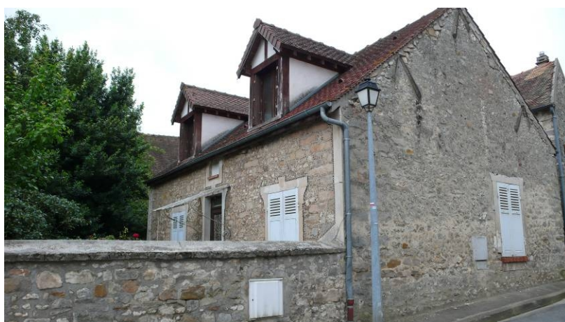
CHA64 située au 6, rue du Gazon, dans le hameau de Beauvais, et dans la maçonnerie de laquelle on retrouve des blocs de grès de teinte rosée.
