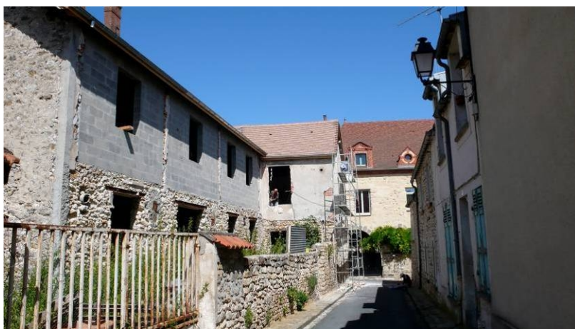
Maison dénaturée au 5, rue de la Gare. Cet ensemble, constitué d'un bâtiment « antecadastre » donnant sur la rue de la Gare et d'un bâtiment plus récent situé le long de la rue de la Salle est en cours de transformation. La maçonnerie en moellons de meulière et de calcaire est remplacée au premier niveau par des parpaings et des baies sont percées à intervalles réguliers.
