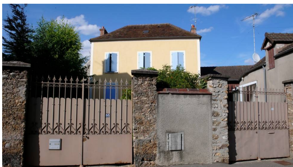
CHM65 (33, rue du Commandant Maurice Arnoux) fut construite au cours du XIX e siècle. Elle est composée d'un étage carré et de trois travées. Les murs sont recouverts d'enduit. Les entourages des baies et les angles sont soulignés par des bandeaux lissés.
