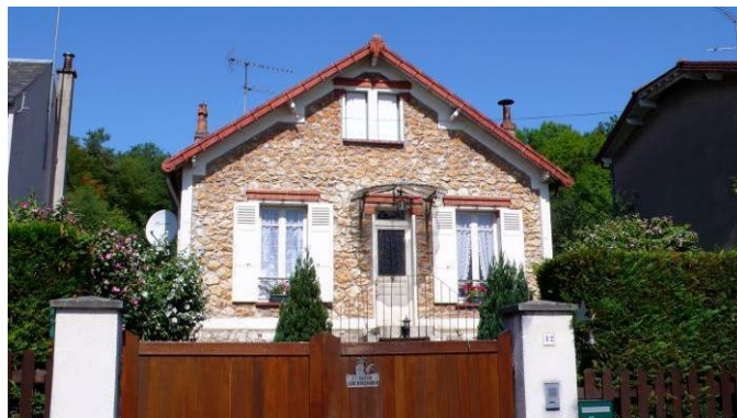
CHM05 (42, rue de Frères Bolifraud) possède des linteaux composés d'une pièce métallique surmontée d'un décor de briques.
