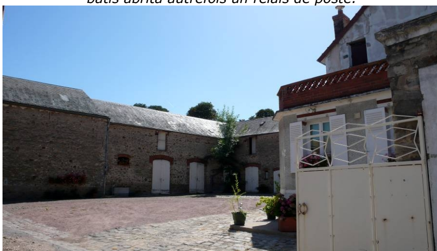
CHM40 (8, rue du Commandant Maurice Arnoux) est une grande ferme à cour fermée située dans le centre-bourg de Chamarande. Cet ensemble de bâtiments à vocation agricole fut construit au cours du XIX e siècle. A droite, une extension de plain-pied a été ajoutée au bâtiment d'origine (linteaux constitués d'une pièce métallique dont les rivets sont cachés par des rosettes).
