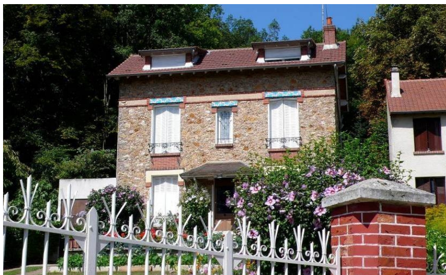
Villa dénaturée au 8, rue des Frères Bolifraud. Une aile dénaturante a été accolée à cette villa dont les linteaux sont ornés de carreaux de faïence à décor floral.
