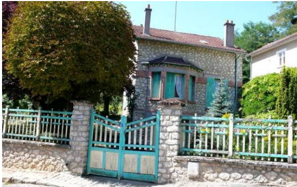
CHM08 (32, rue des Frères Bolifraud) possède un toit à demi-croupe dont le débord est supporté par des aisseliers et des baies cintrés à décor de briques bichromes.
