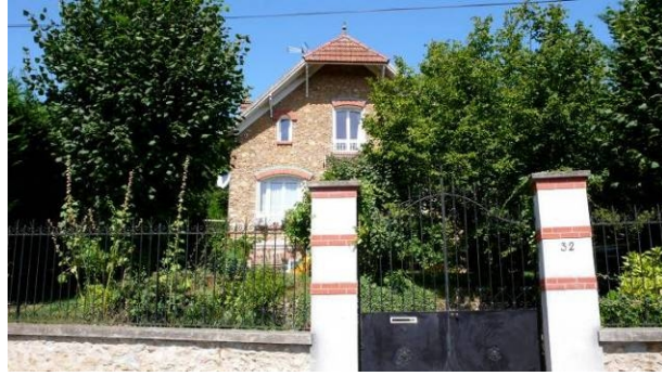
CHM08 (32, rue des Frères Bolifraud) possède un toit à demi-croupe dont le débord est supporté par des aisseliers et des baies cintrés à décor de briques bichromes.
