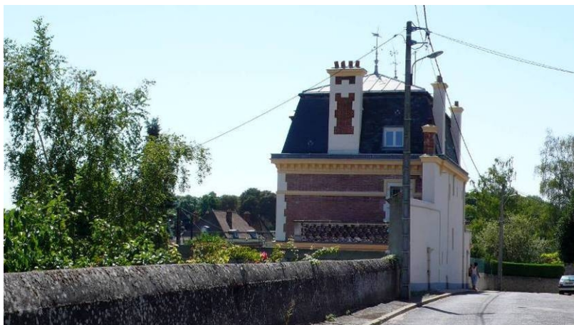
CHM20 (1, chemin des Berbiettes) est située le long de ligne de chemin de fer. Elle possède un toit en pavillon et une modénature de plâtre soignée composée de chaînes d'angle, d'une corniche à denticules et de bandeaux horizontaux.
