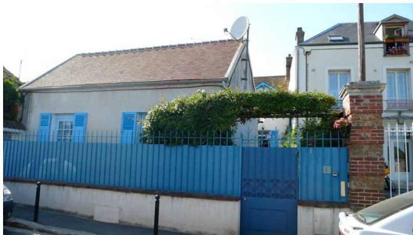
CHM60 (59, rue du Commandant Maurice Arnoux) est « ante-cadastrée ». Elle se compose d'un ancien logis en fond de parcelle et d'une annexe agricole.
