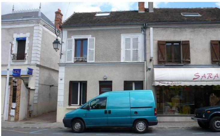
*BAL104 (39, rue du Général de Gaulle) est une maison de bourg « ante-cadastre » composée d'un étage carré. La façade sur rue est recouverte d'un enduit au ciment. Cet édifice possède cependant toujours ses éléments de décor en plâtre (corniche et chaînage d'angle).*
