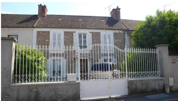
*BAL115 (5, rue des Ecoles) est une maison de bourg construite au cours du XIX<sup>e</sup> siècle. Construite en retrait de la rue, elle est composée de trois travées. La maçonnerie est composée de moellons de calcaire et de meulière ainsi que de blocs de grès grossièrement équarris. Les entourages de baies et les chaînages d'angle sont soulignés par des bandeaux lissés.*
