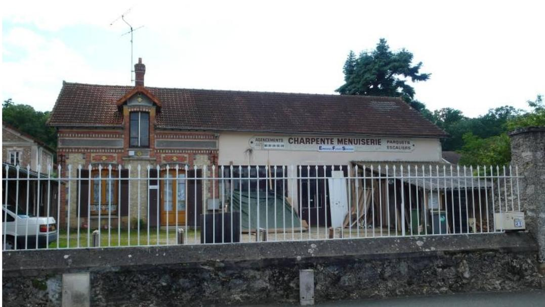
*BAL125 : le jeu d'alternance des briques polychromes crée un décor soigné composant des frises, bandeaux et chaînes d'angle. On note également la présence de briques polychromes émaillées au niveau des linteaux.*
