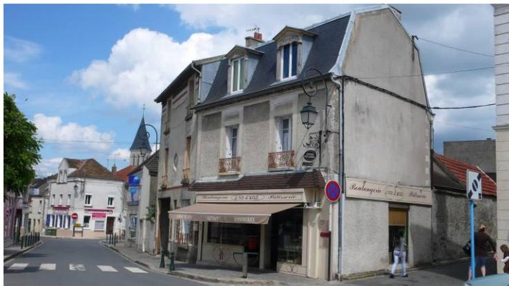
*BAL105 (35, rue du Général de Gaulle) est une maison à boutique du centre-bourg dont le toit est en forme de coque de bateau inversé. La façade est recouverte d'enduit et l'encadrement des baies est souligné par un bandeau lissé.*
