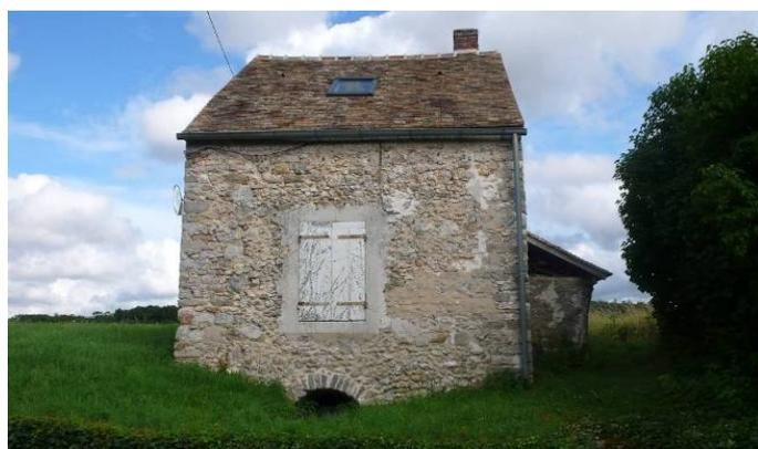
*ASG61 est une construction « ante-cadastre » située dans le hameau de Chagrenon (face au 9, route de Gillevoisin). Ce petit édifice est construit en moellons de meulière et de calcaire renforcés par des chaînages d'angle en grès sur un sous-bassement auquel on accède par une petite porte cintrée.*
