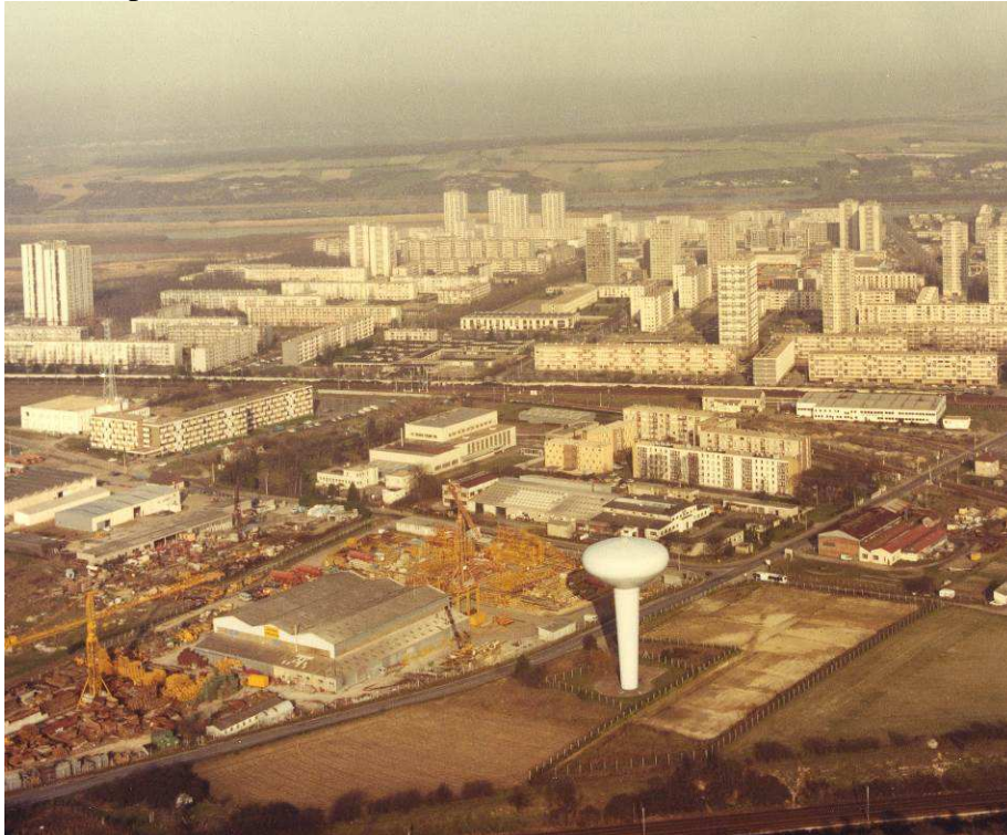
Vue d'ensemble du val Fourré © CREDOP (201678000039NUC4AB)
