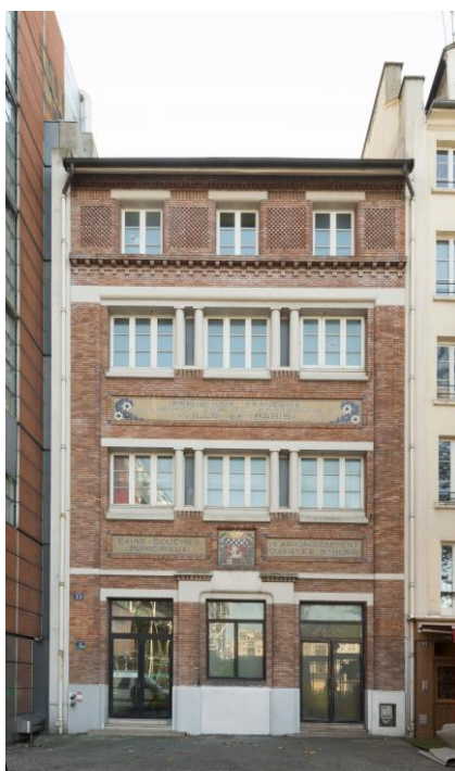
Les bains-douches de la rue Saint-Merri (Paris, 4 e )
