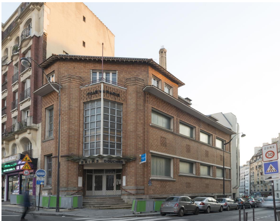
Les bains-douches de la rue Petitot (Paris, 19 e ).
