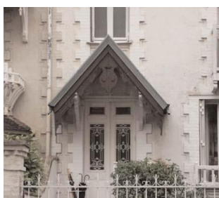
Marquise rue de la Barre
