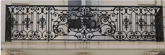
Exemple de garde-corps 19 e siècle en fonte, rue du Général de Gaulle
