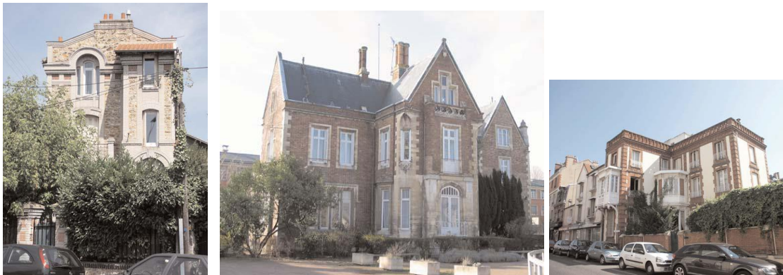
Exemples de façades atypiques : 12 rue Carlier 1 er quart 20 e et « le château d'Enghien » 73 avenue de Ceinture, milieu 19 e , maison en L et bow-window en angle 5 rue de la Libération
