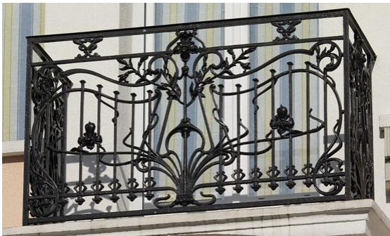
Garde-corps Art nouveau, fonte, rue des Thermes
