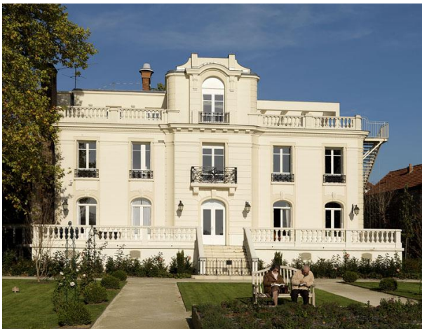
La villa du Lac, 45 ter avenue de Ceinture
