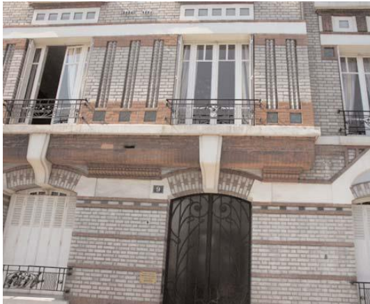
Jeux de polychromie avec brique rouge et brique silico_calcaire 9 rue Blanche
