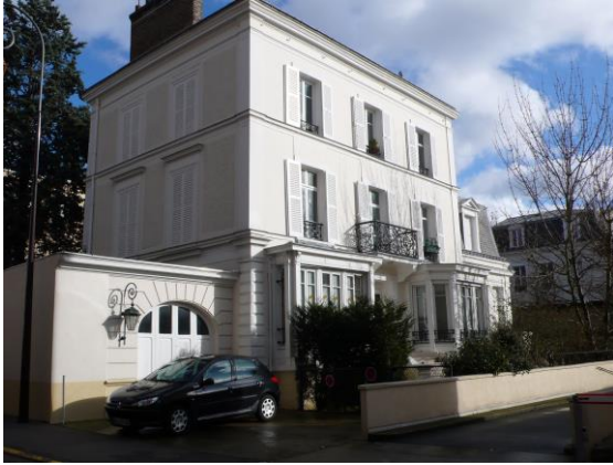
Façade, rue du temple avec fausses travées
