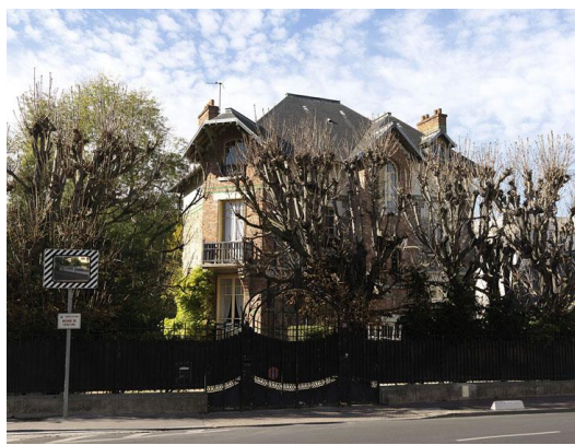
Vue de l'une des trois maisons construites par Sorel
