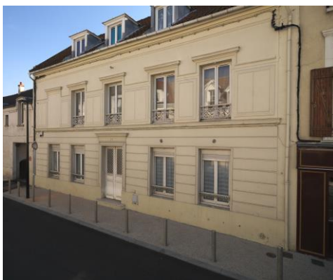
Décor d'enduit, 16 rue de Mainville
