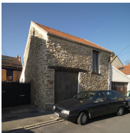
Ancienne grange à Mainville, 27 rue des Creuses
