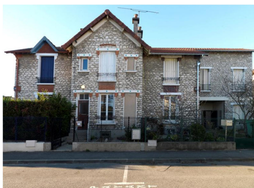
2016780050NUC4A 70-74 rue Saint-Vincent
