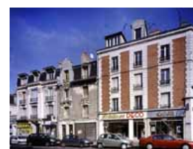
Exemple d'immeubles mitoyens, 25-29 rue Saint-Ambroise (dossier IA77000494).
