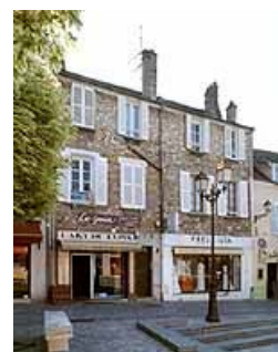
Façade en moellons de calcaire et grès, 4 place Jacques-Amyot (dossier IA77000531).
