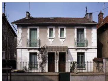
Maisons jumelles (Fig.43), 26-26bis avenue de la Libération
