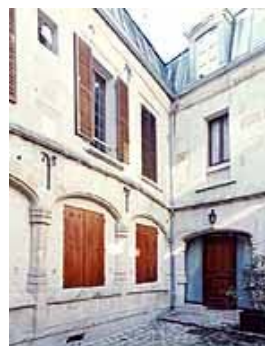
Galerie Renaissance sur la cour du 15, rue du Presbytère. (dossier IA7700572)
