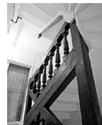
Escalier à deux noyaux (dossier IA77000520)
