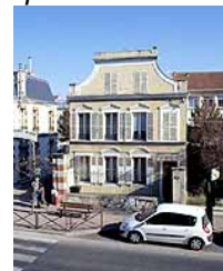
Façade à décor de plâtre, 8 boulevard Gambetta (dossier IA77000543).
