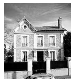
Exemple de maison en retrait de la rue 25bis rue Eugène-Gonon (Fig.47).
