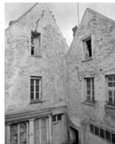
Pignons en moellons de calcaire et chaînes de grès, découverts par la chute de l'enduit. 12 rue Paul-Doumer (dossier IA77000495)
