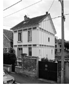
Maison construite selon le « système Bérard », 7 rue du Docteur-Pouillot (dossier IA77000591)
