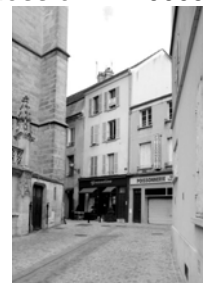
Ancienne façade pignon transformée en gouttereau au XIX e siècle, 1 rue des Cloches (Fig.18).
