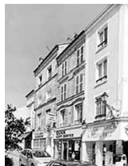
Immeubles de trois étages, 4-8 rue Saint-Aspais (Fig.22).
