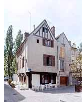
Maison à pan de bois, 3 rue du Presbytère (dossier IA77000567)
