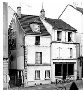
Maisons anciennes, 12-14 rue du Château (Fig.14). Celle de gauche a conservé son escalier en vis (XVIe siècle).
