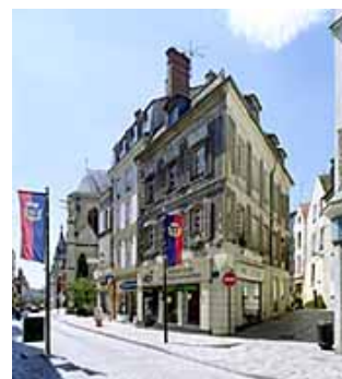
Maison du XVIIIe siècle, à l'angle de la rue Saint-Aspais et de la rue des Cloches (dossier IA77000581)
