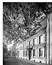
Exemple d'alignement sur rue : 32-36 quai Pasteur (Fig.63).
