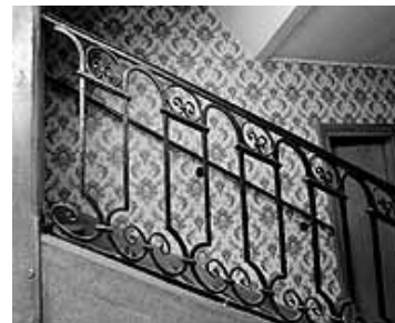
Escalier à rampe en fer forgé, XVIIIe s., 15 rue Notre-Dame (dossier IA77000702).
