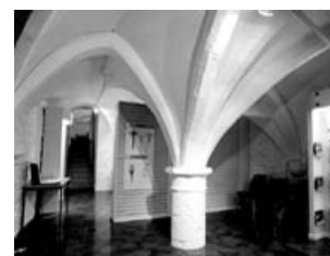
Cave médiévale sous bâti postérieur, 3 rue Paul-Doumer. (dossier IA77000590)
