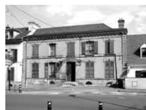
Façade enduite, 2 rue de Trois-Moulins (Fig.54).
