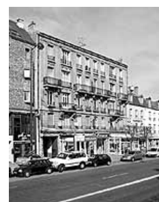
Immeuble 34 avenue Thiers, construit en 1910. Façade avec enduit imitant la pierre de taille (dossier IA77000481).
