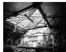
Atelier de serrurerie dans la cour de l'immeuble 2 rue des Granges ( dossier IA77000511 ).
