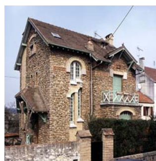
Maison 24 rue de la Varenne (Fig.60). Aux façades enduites se substitue le jeu sur les matériaux apparents : meulière, brique, bois peint, et décor de carreaux de céramique.
