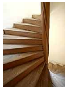
Escalier en vis à noyau nervuré, XVIe s. (dossier IA77000572)
