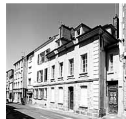
Maison 6 rue du Château (Fig.15) : corniche moulurée en forte saillie, interrompue par des lucarnes passantes
