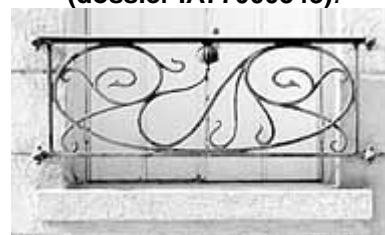
Garde-corps Art Nouveau, 7 rue du Presbytère (Fig.65).
