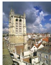
Toits de tuiles du quartier Saint-Aspais (dossier sur l'église, IA77000405).
