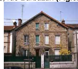
Maison jumelle avec linteaux métalliques aux fenêtres, 22, avenue de la Libération (Fig.44).
