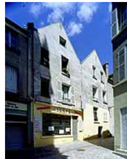
Maisons présentant leur mur pignon en façade, 5-7 rue des Cloches. (dossier IA77000594)
