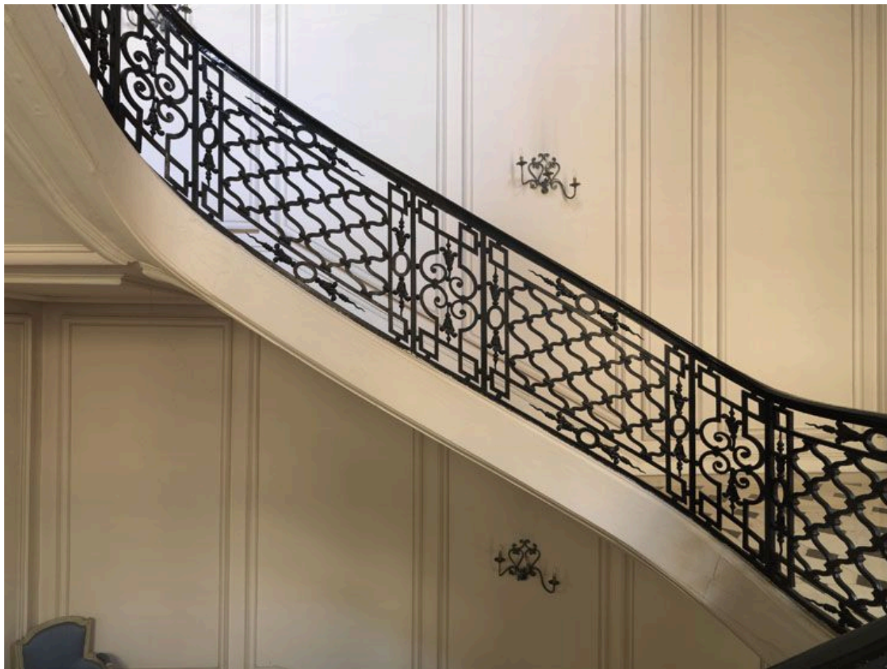
Vue d'un panneau rampant.
