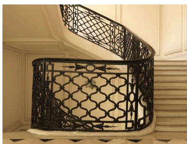
Vue de la partie tournante de la rampe. Phot. Laurent Kruszyk IVR11_20097500983NUC4A
