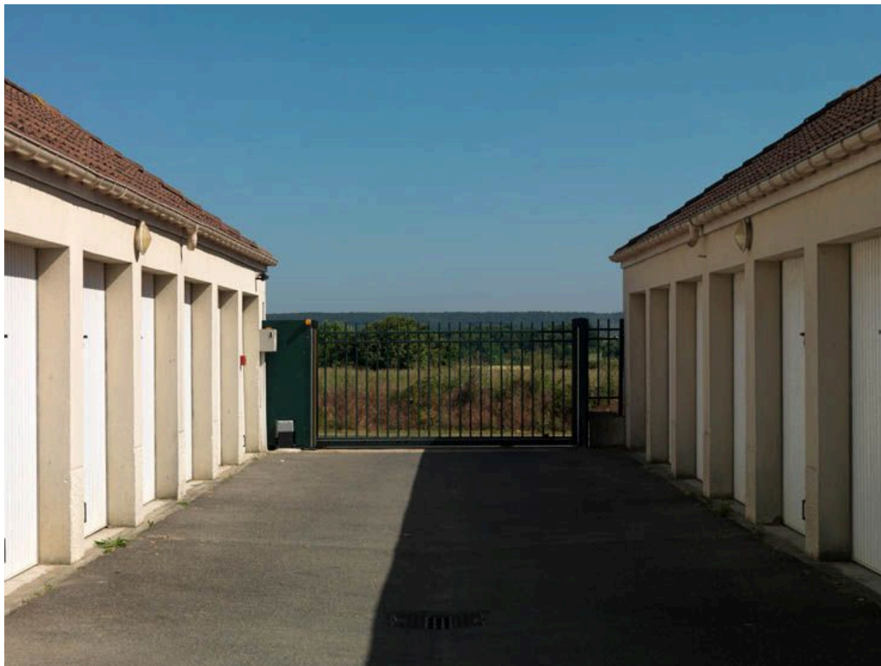
Boissy-sous-Saint-Yon. Résidence de la rue de Châtres.
