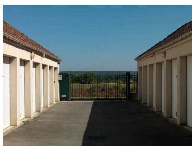
Boissy-sous-Saint-Yon. Résidence de la rue de Châtres. Phot. Philippe IVR11_20119100243NUC4A
