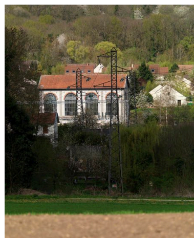
Saint-Chéron. Vue de la sous- station électrique de Saint-Evrout, depuis la rue du Vieux Châtre. Phot. Philippe IVR11_20119100072NUC4A
