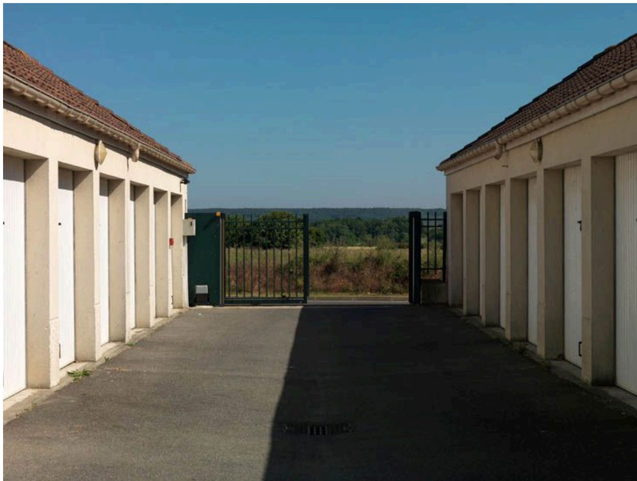
Boissy-sous-Saint-Yon. Résidence de la rue de Châtres.
