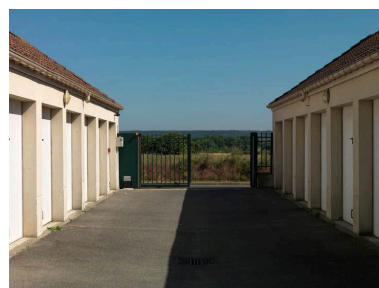
Boissy-sous-Saint-Yon. Résidence de la rue de Châtres. Phot. Philippe IVR11_20119100244NUC4A
