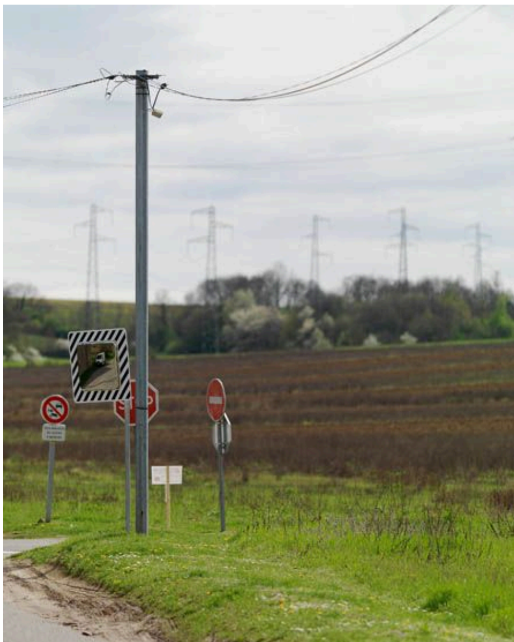
Roinville. Vue du carrefour du chemin des Prés et de la route de Poissard.
