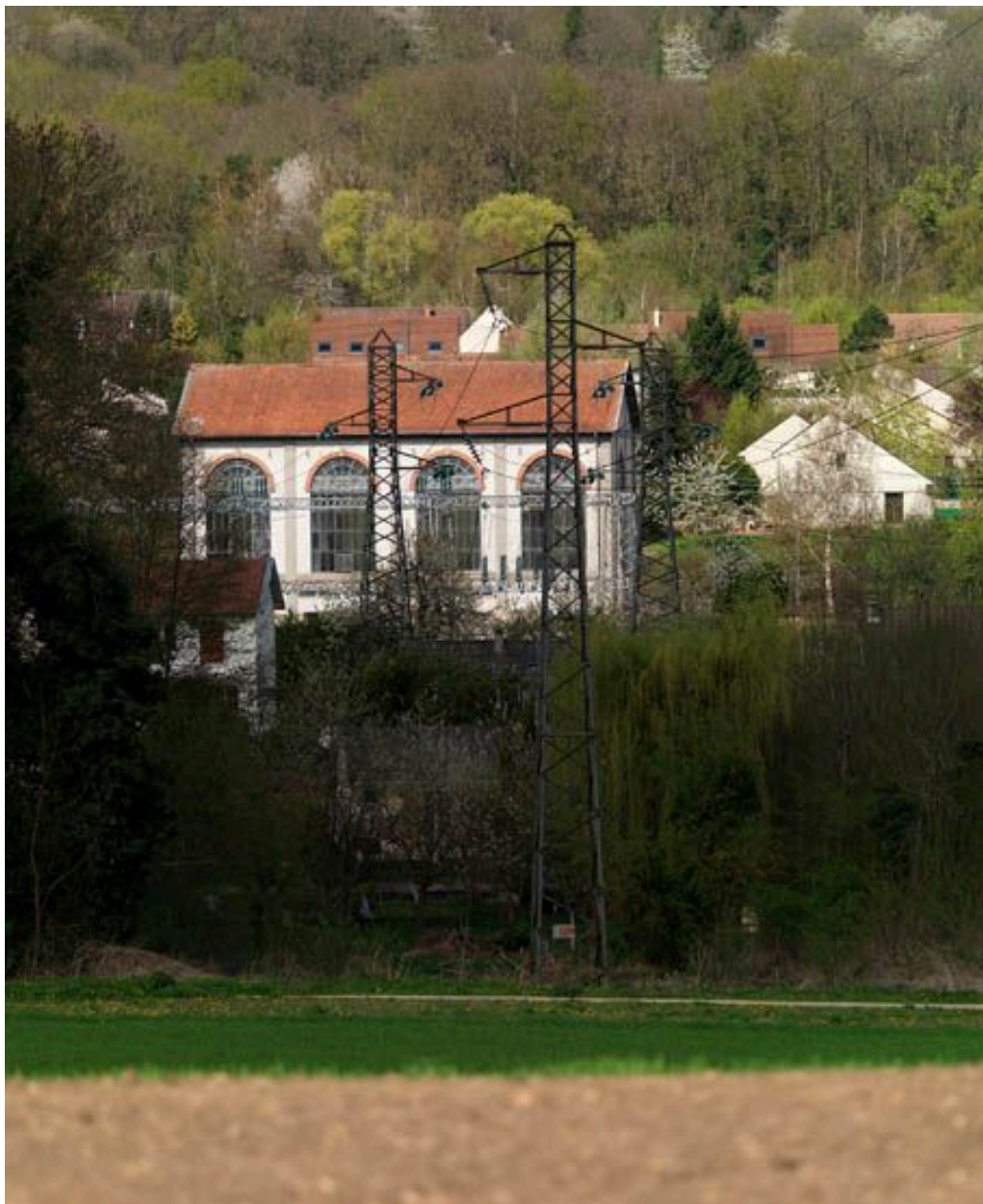
Saint-Chéron. Vue de la sous-station électrique de Saint-Evrout, depuis la rue du Vieux Châtre.
