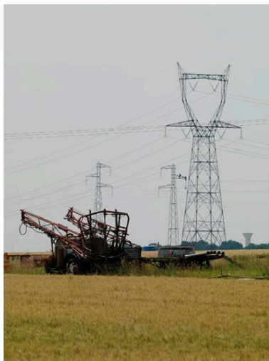
Forêt-le-Roi (La). Depuis la rue du Parc vers le sud. Phot. Philippe IVR11_20119100269NUC4A
