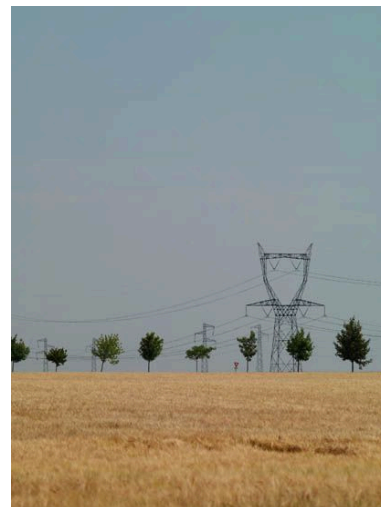
Mérobert. Route Neuve vers le nord-est. Phot. Philippe IVR11_20119100286NUC4A
