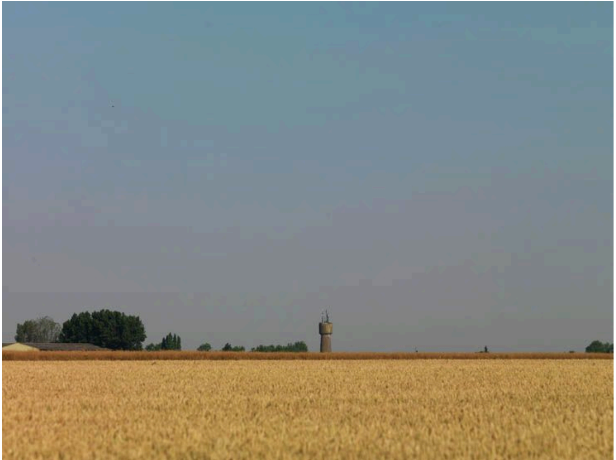
Mérobert. Château d'eau de Saint-Escobille depuis la départementale 21.
