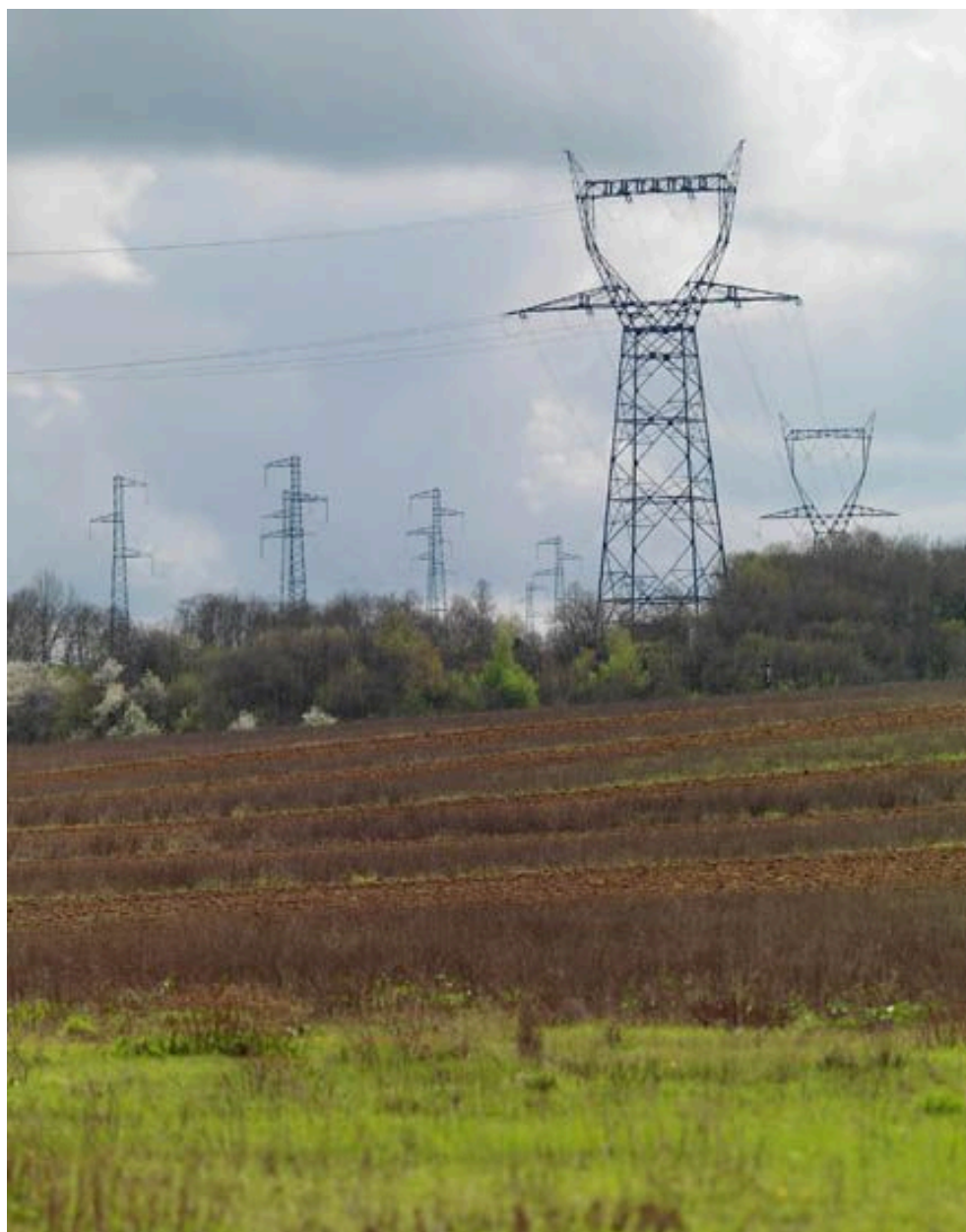
Roinville. Vue des pylônes électriques sur les buttes de la Bruyère, depuis la route de Poissard.
