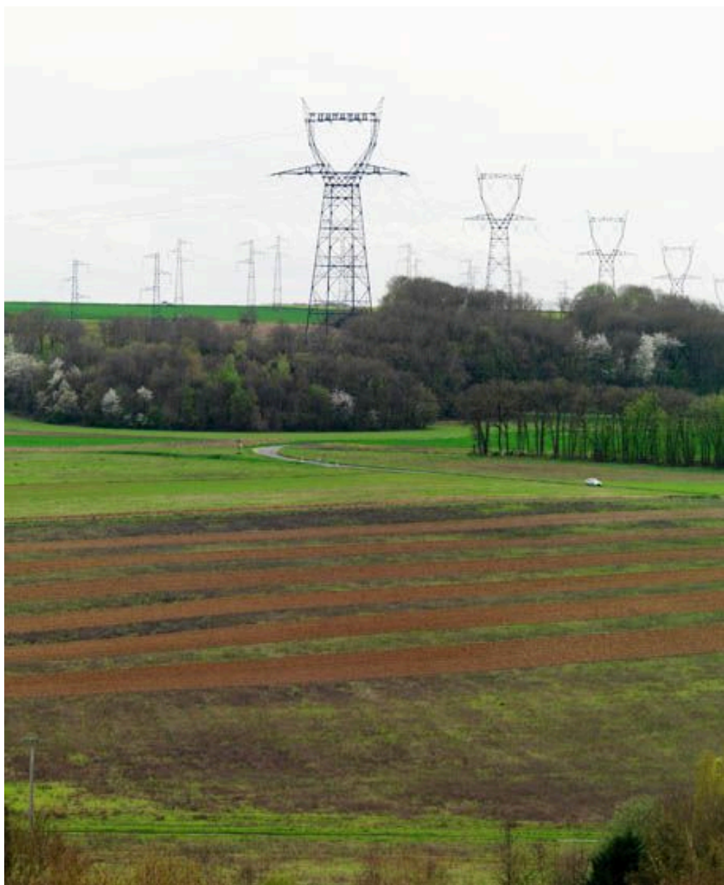
Roinville. Vues de pylônes électriques des buttes de la Bruyère, et des champs.
