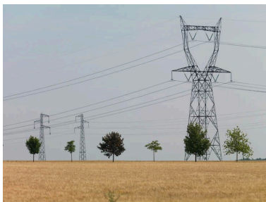
Mérobert. Route Neuve vers le nord-est. Phot. Philippe IVR11_20119100285NUC4A
