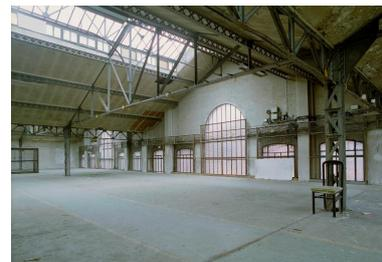
Premier étage du magasin pièces détachées ("plancher caoutchouc"), période Guitel-Etienne-Mobilor. Revers de la façade. L'ancien atelier de chaudronnerie de l'usine Rateau, élevé en 1917, comprend trois halles accolées ouvertes : la légèreté des supports permet l'ouverture du volume et la manipulation des pièces.
