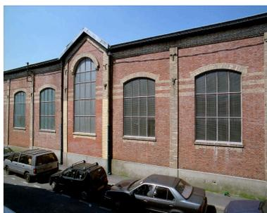
Détail de la façade de l'atelier de soudure et de montage (1916-1917). Le mur gouttereau, rythmé de pilastres plats et percé de larges baies coiffées d'arcs surbaissés, est interrompu par un pignon dont l'unique baie, plus haute, est surmontée d'un arc saillant en plein cintre.
