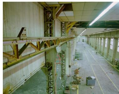
Intérieur de l'atelier de soudure et de montage, pris depuis le couloir d'accès aux bureaux du premier étage. Rail du pont roulant.
