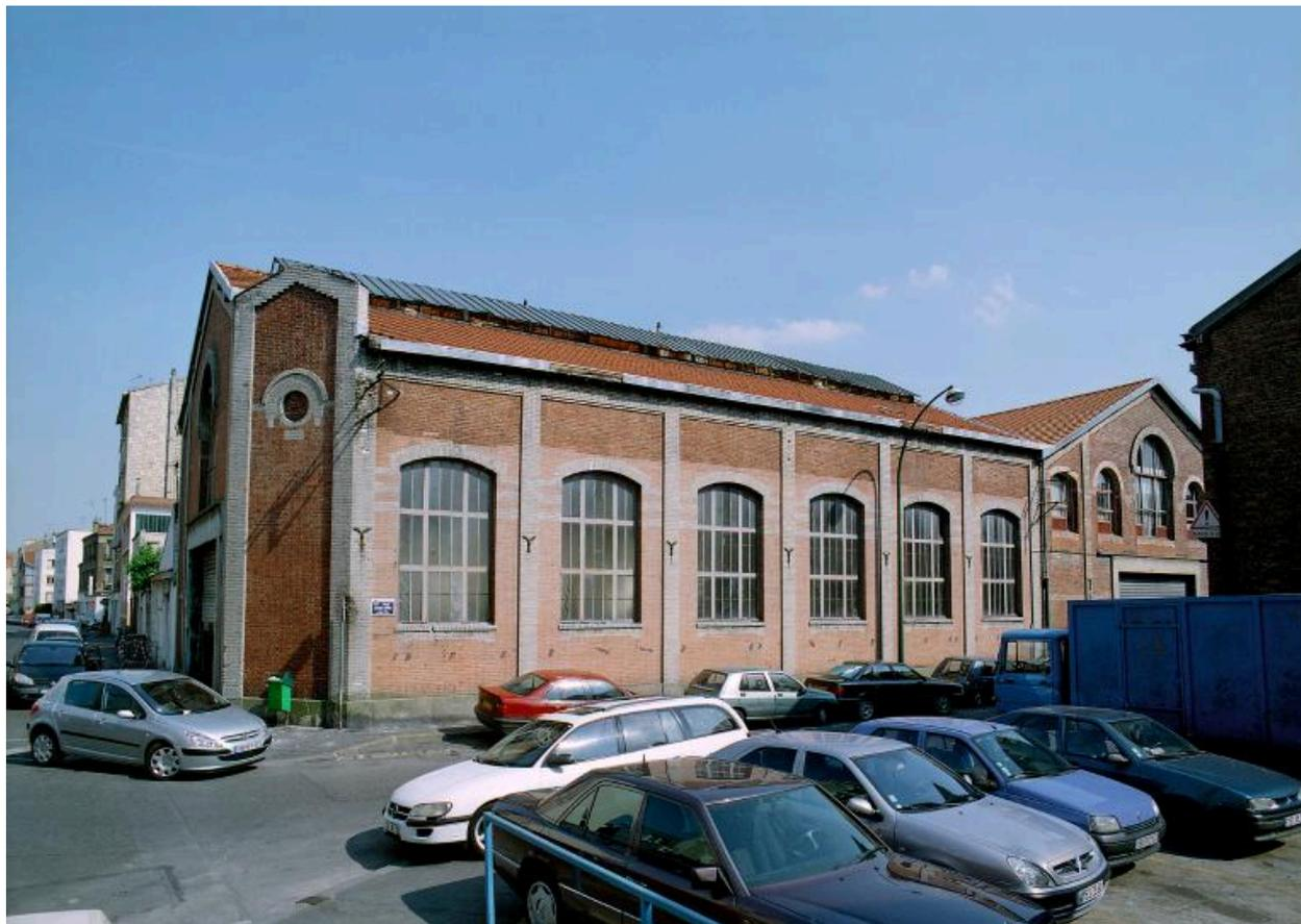
Atelier de mécanique (N° 4) de l'usine Rateau, élevé entre 1913 et 1916. Grandes baies coiffées d'arcs surbaissés, pour l'éclairage d'opérations minutieuses ; lanterneau vitré (aération et éclairage). Sept pilastres de brique silico-calcaire rythment une façade élevée en maçonnerie de brique rouge.
