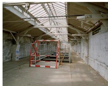
Magasin pièces détachées de l'usine Rateau. Le plancher (appelé "plancher petit outillage") et la trémie ont été aménagés par l'entreprise Guitel-Etienne. Aux deux extrémités de la trémie grillagée, ont été installées deux barrières de sécurité pivotantes : une fois la palette de carton déposée à l'entrée de trémie, la cage est basculée, et la marchandise récupérée par des charriots élévateurs.
