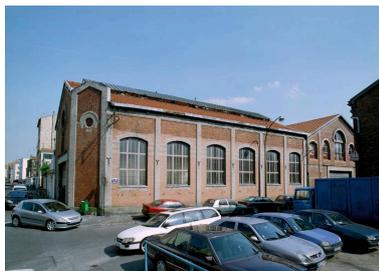
Atelier de mécanique (N° 4) de l'usine Rateau, élevé entre 1913 et 1916. Larges baies coiffées d'arcs surbaissés, pour l'éclairage d'opérations minutieuses ; lanterneau vitré (aération et éclairage). Sept pilastres de brique silico-calcaire rythment une façade élevée en maçonnerie de brique rouge.
