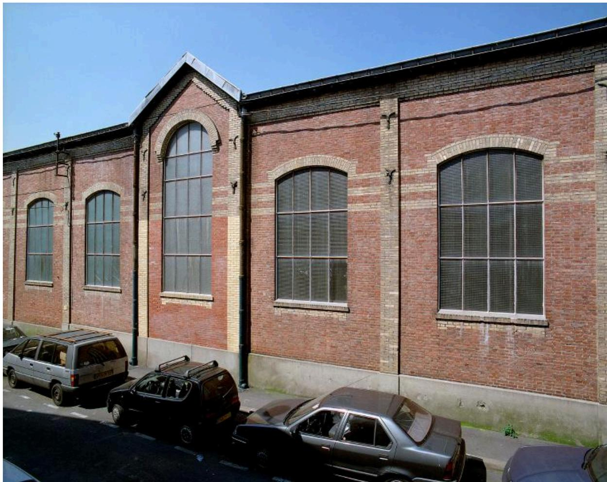
Détail de la façade de l'atelier de soudure et de montage (1916-1917). Le mur gouttereau, rythmé de pilastres plats et percé de larges baies coiffées d'arcs surbaissés, est interrompu par un pignon dont l'unique baie, plus haute, est surmontée d'un arc saillant en plein cintre.
