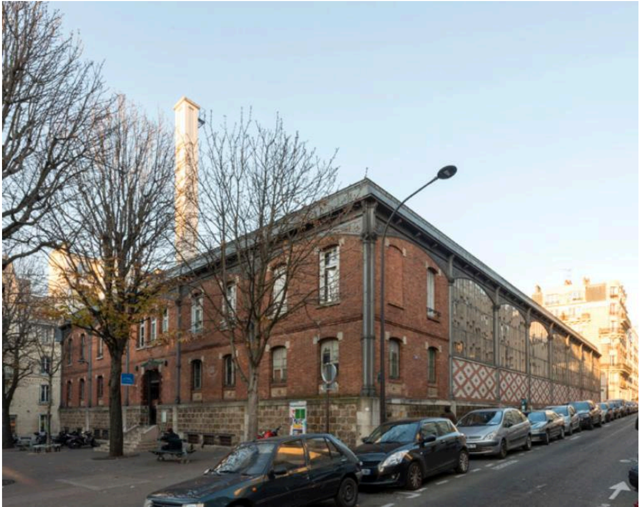
Vue générale des bains-douches de la rue des Pyrénées (Paris, 20e) aménagés en 1901-1904 dans l'ancien marché couvert de Belleville, édifié en 1876.
