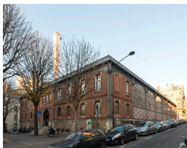
Vue générale des bains-douches de la rue des Pyrénées (Paris, 20e) aménagés en 1901-1904 dans l'ancien marché couvert de Belleville, édifié en 1876. Phot. Laurent Kruszyk IVR11_20177500049NUC4A
