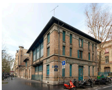
Vue générale des bains-douches de la rue Jean Jaurès (Paris, 19e), créés en 1913-1914 à
