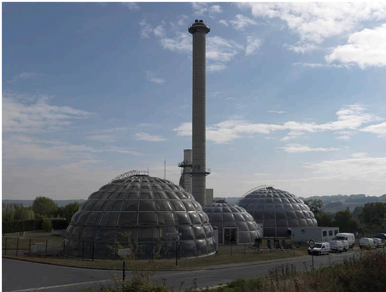
Vue d'ensemble de la chaufferie, depuis l'ouest.
