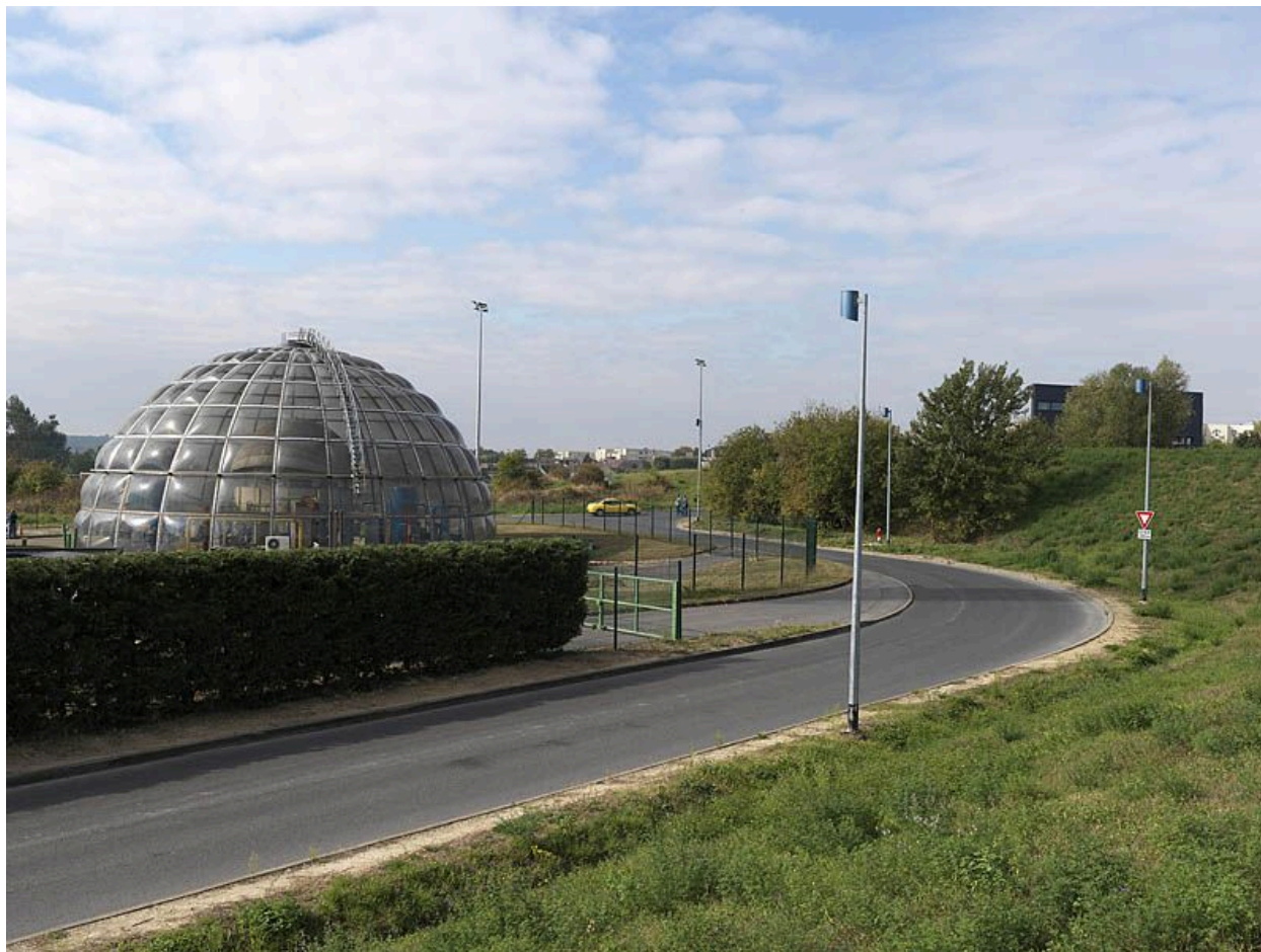
Vue de la petite coupole de 15 m ayant fonction de salle de contrôle.
