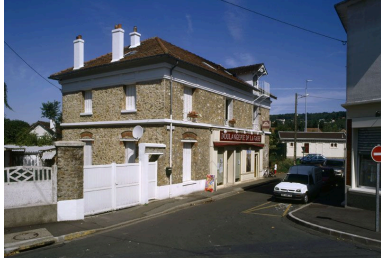
Vue d'ensemble. Phot. Philippe Ayrault IVR11_20067800887XA
