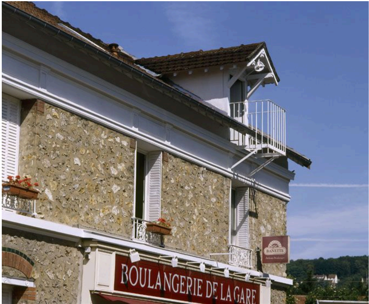
Détail de la lucarne avec sa poulie.
