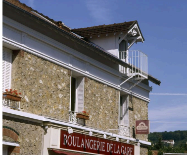
Détail de la lucarne avec sa poulie. Phot. Philippe Ayrault IVR11_20067800889XA
