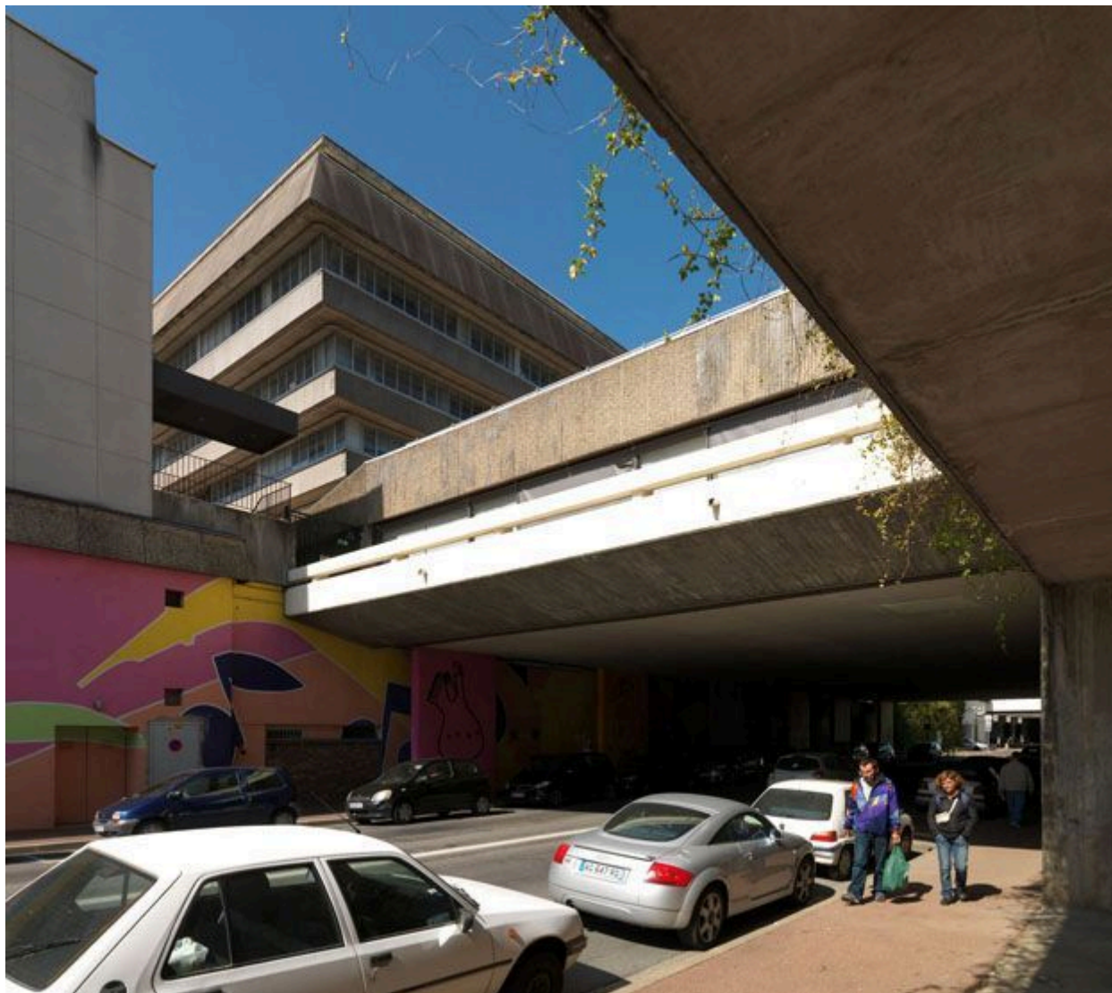
Vue de la rue de la Préfecture au niveau d'un passage sous la dalle. A gauche, le bâtiment de la préfecture.
