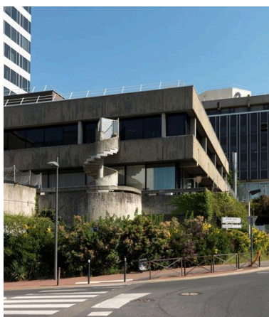
Vue d'un escalier hélicoidal à l'angle de la rue de la Préfecture. Phot. Philippe Ayrault IVR11_20129500580NUC4A
