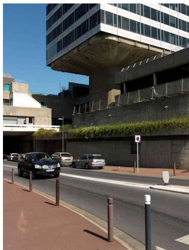
Vue de la rue de la préfecture qui pénètre sous la dalle. Phot. Philippe Ayrault IVR11_20129500576NUC4A
