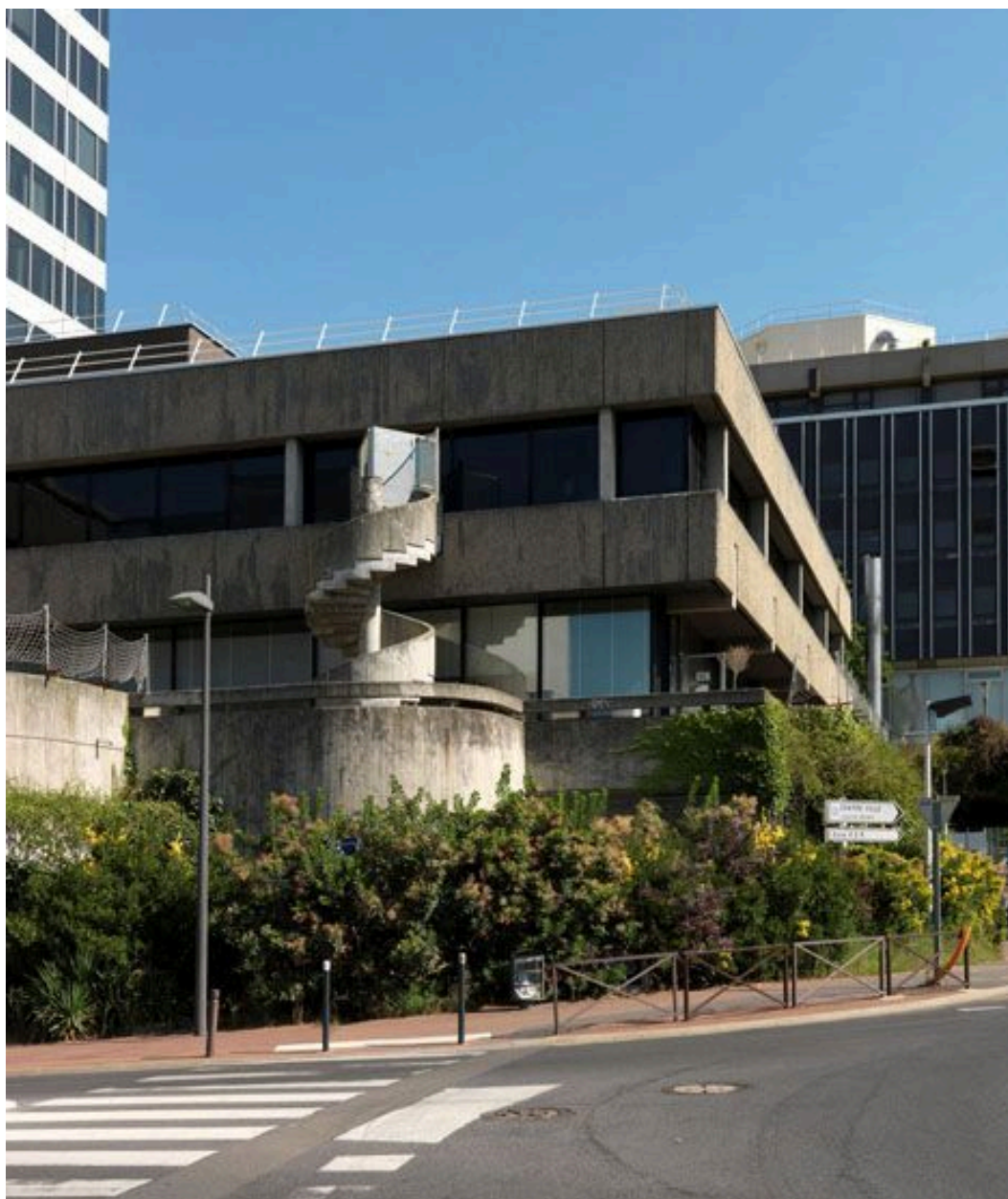
Vue d'un escalier hélicoidal à l'angle de la rue de la Préfecture.
