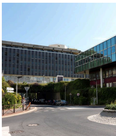
Vue de l'avenue de la Poste au niveau de son passage sous la dalle. Phot. Philippe Ayrault IVR11_20129500579NUC4A
