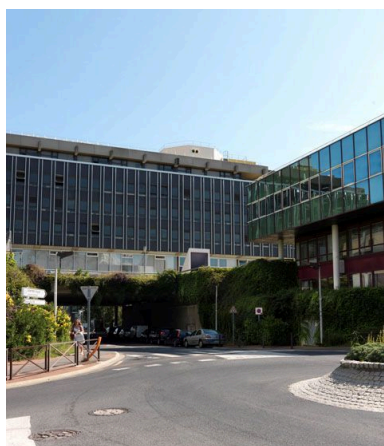
Vue de l'avenue de la Poste au niveau de son passage sous la dalle. Phot. Philippe Ayrault IVR11_20129500579NUC4A
