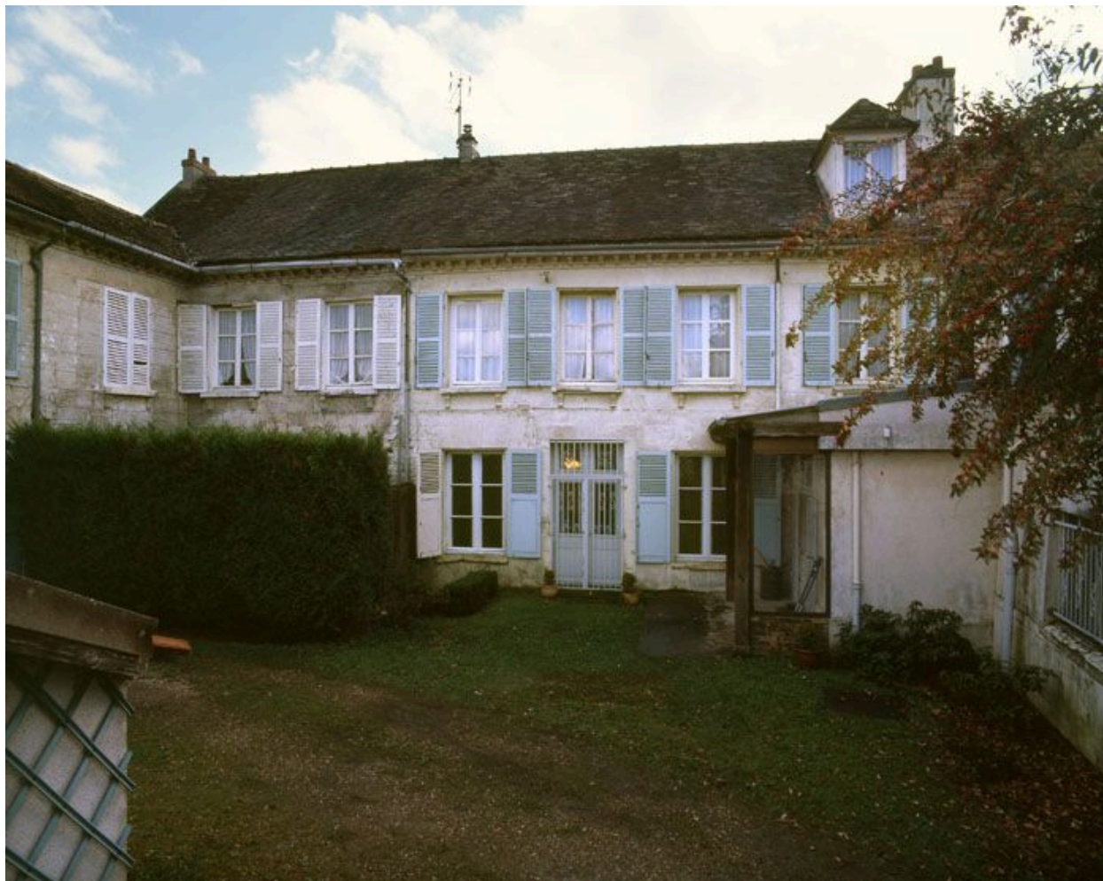
Vue d'ensemble de la façade antérieure.
