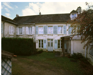
Vue d'ensemble de la façade antérieure. Phot. Laurent Kruszyk IVR11_20077800455XA
