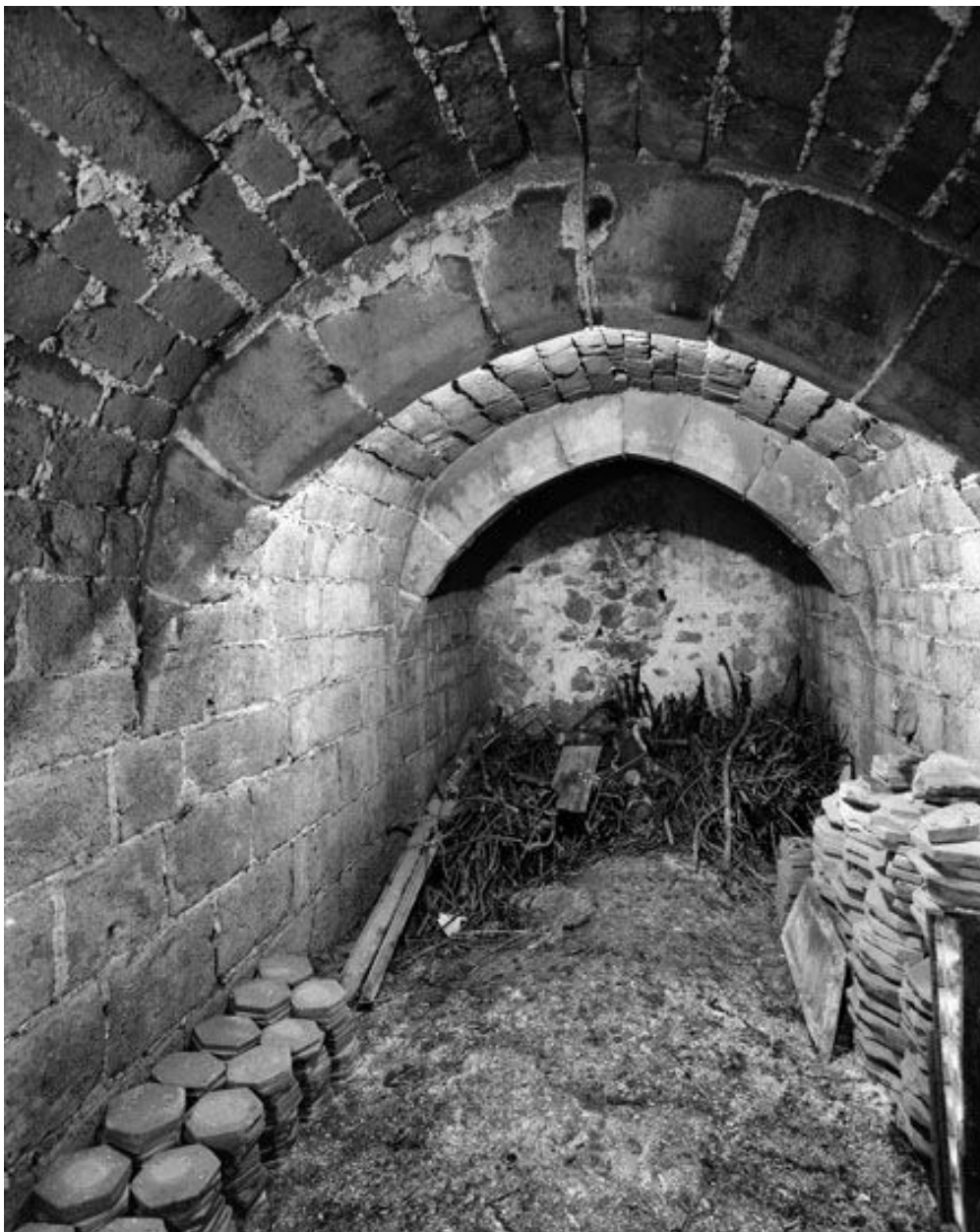
Cellier gothique : le fond du cellier, au delà de la croisée d'ogives.
