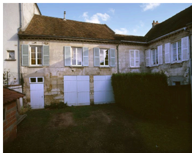
Vue d'ensemble de l'aile gauche qui abritait les communs. Phot. Laurent Kruszyk IVR11_20077800458XA
