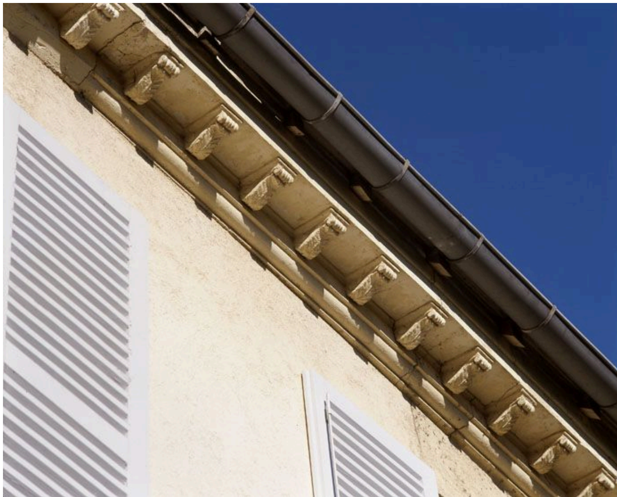
Détail de la corniche à modillons de la façade sur jardin.
