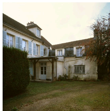
Vue d'ensemble de l'aile droite. Phot. Laurent Kruszyk IVR11_20077800456XA
