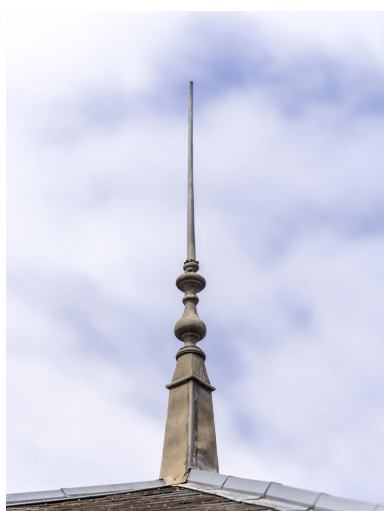
Vue de détail de l'épis de faîtage est. Phot. Asseline Stéphane
