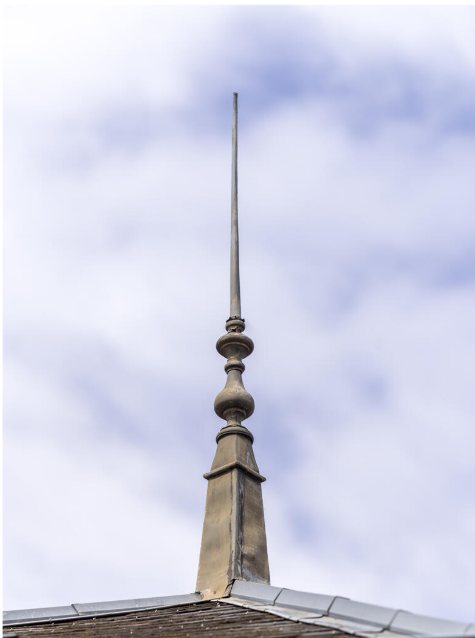
Vue de détail de l'épis de faîtage est.
