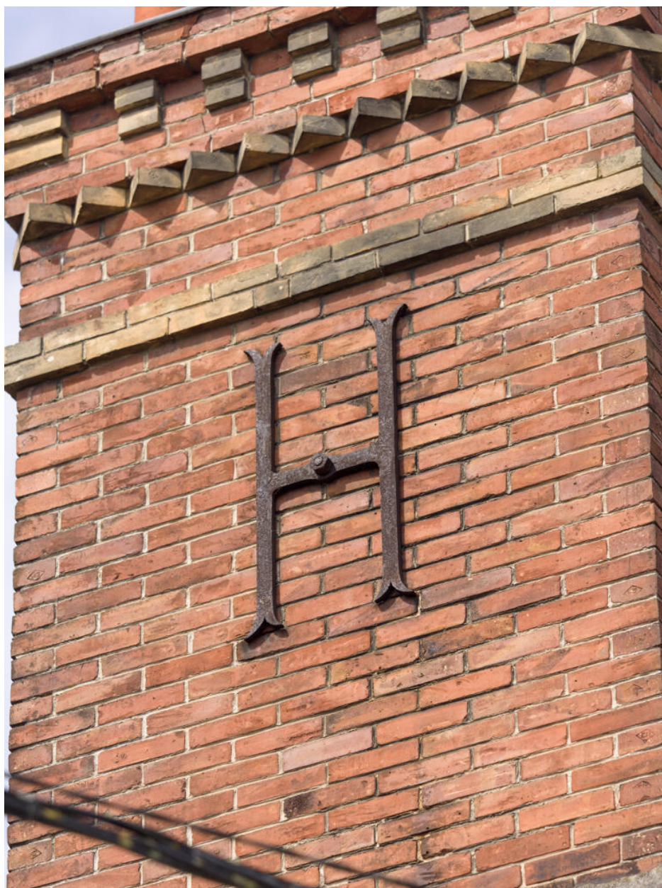
Détail de la souche de cheminée est.
