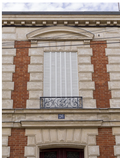
Travée centrale au niveau de l'étage. Phot. Asseline Stéphane IVR11_20259100592NUC4A
