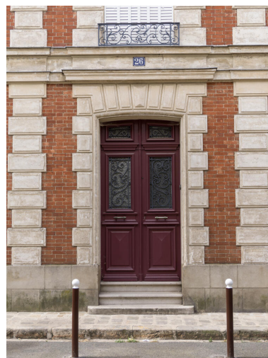
Travée centrale au niveau du rez-de-chaussée. Phot. Asseline Stéphane IVR11_20259100591NUC4A
