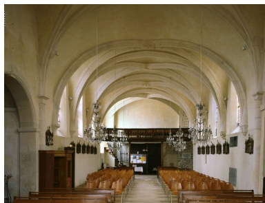
Vue d'ensemble de l'intérieur en direction de la tribune. Phot. Laurent Kruszyk IVR11_20087800289VA
