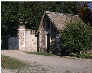
Une remise accolée au mur de clôture, près de l'entrée. Phot. Philippe Ayrault IVR11_20069101239XA
