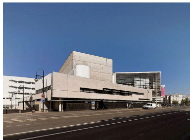
Vue d'ensemble, depuis le nord-est. Phot. Jean-Bernard Vialles IVR11_20137700383NUC4A
