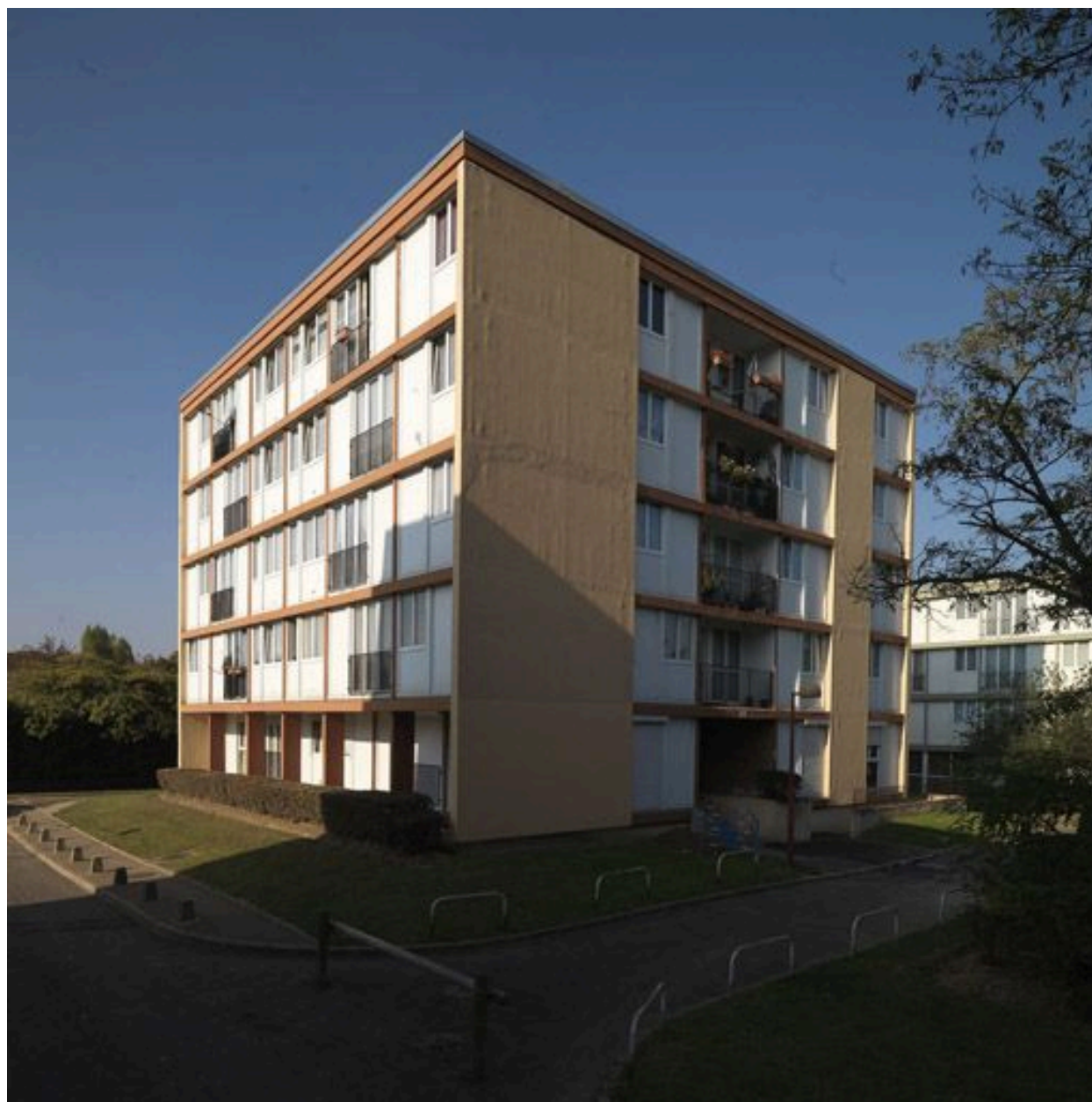
Un bâtiment ""pavé"" ou plot, 2 place Saint-Exupéry.
