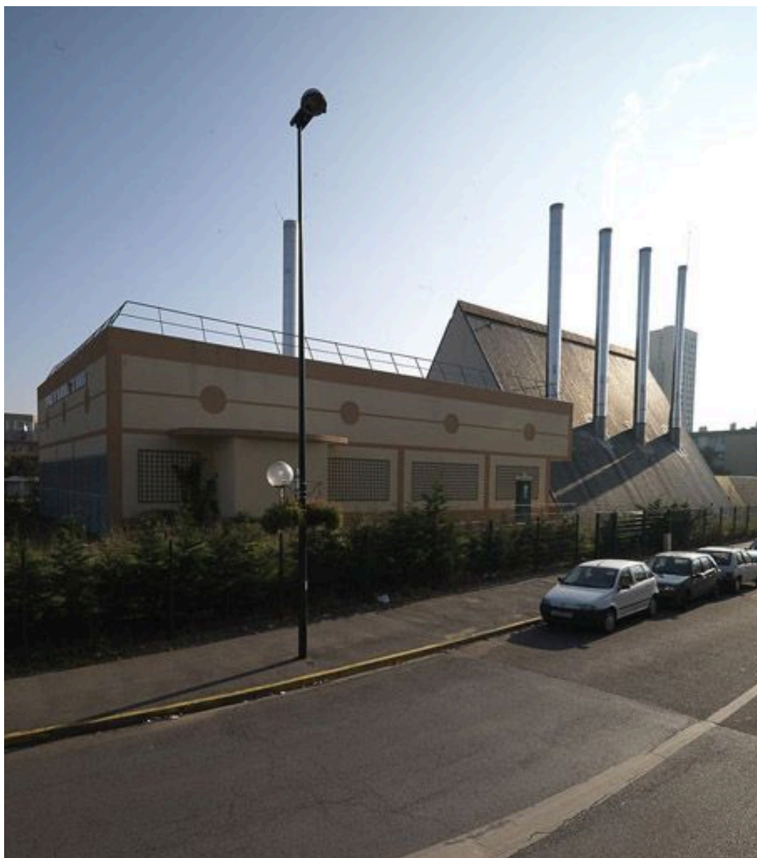
Vue d'ensemble de la chaufferie du grand ensemble, située au début de l'avenue de la Concorde, près de la gare.
