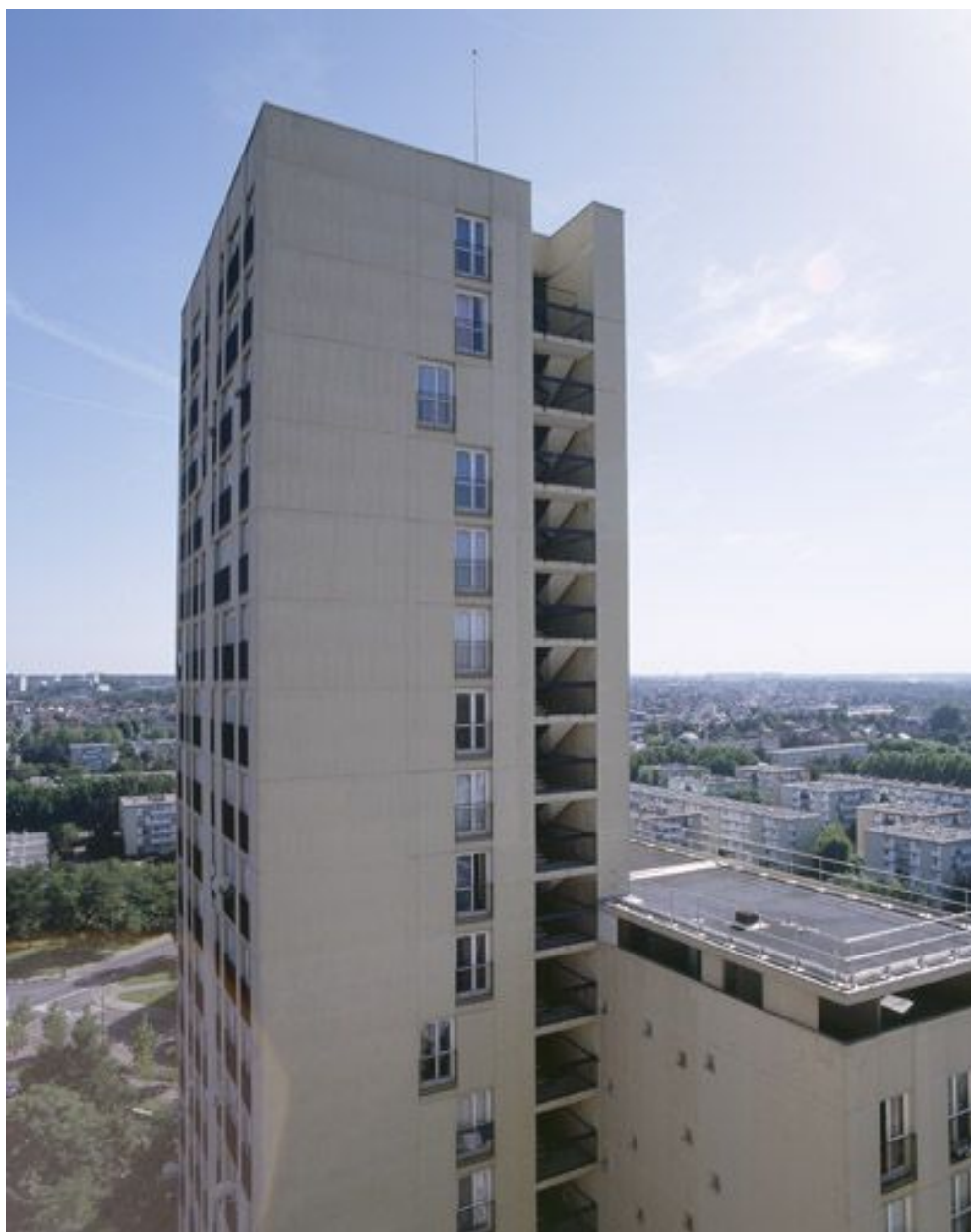
La plateforme du 13e étage et la branche de 23 niveaux côté escalier extérieur.
