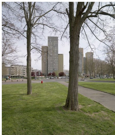
Deux des sept tours vues de l'allée Antoine-Lavoisier. Phot. Philippe Ayrault IVR11_20089100377NUC4A
