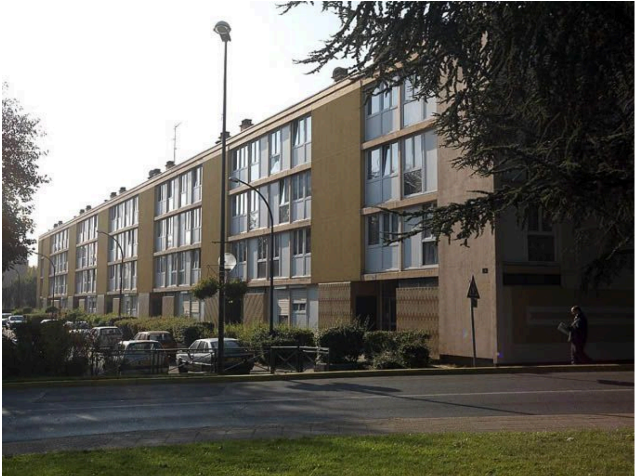
Un immeuble R+3 parallèle à la chaufferie, 2-12, avenue de la Concorde.
