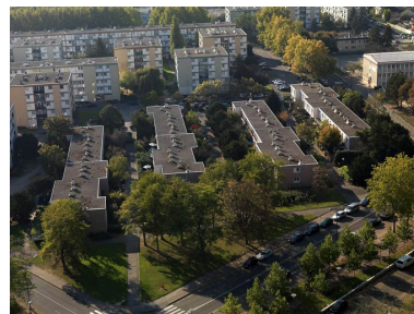
Au premier plan, le long de l'avenue de la Concorde, les 4 ensembles de logements individuels en bande desservis par les allées Lavoisier, Cugnot et Raspail ; à l'arrière, les plots de la place Albert-Einstein ; à droite, une partie des bâtiments du groupe scolaire Marcel-Pagnol.
