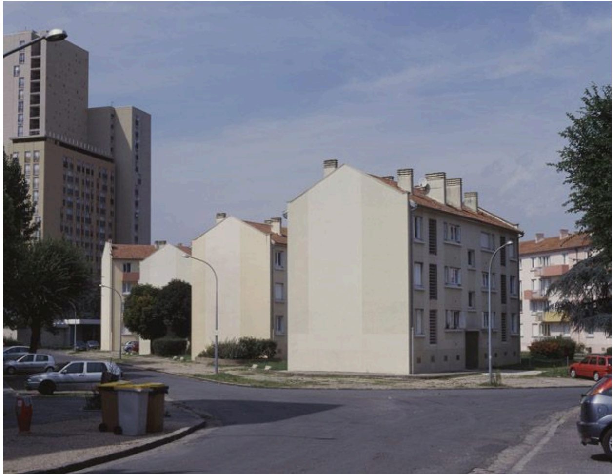
Le carrefour de la rue du Commandant-de-Courcel et de le rue Ambroise-Croizat et une des tours à gauche de la photo.
