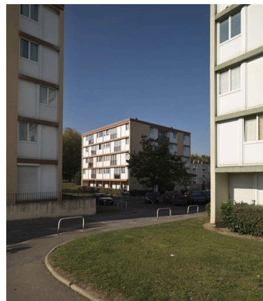
Les trois bâtiments cubiques ou ""pavés"" distribués autour de la place Alain-Fournier.
