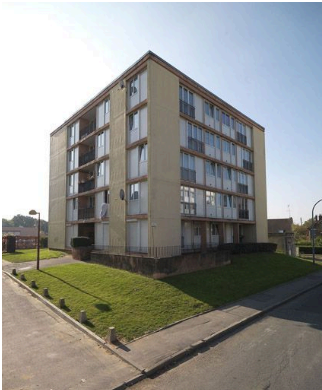
Bâtiment ""pavé"" ou plot, 14 rue Eugène-Varlin.
