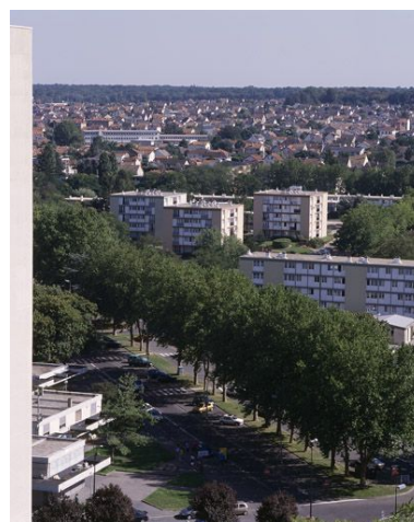
Vue semi-aérienne de l'avenue de la Concorde, à proximité de la gare et les trois plots de la rue Paul-Verlaine, à côté d'un immeuble linéaire. Phot. Philippe Ayrault IVR11_20069100898XA
