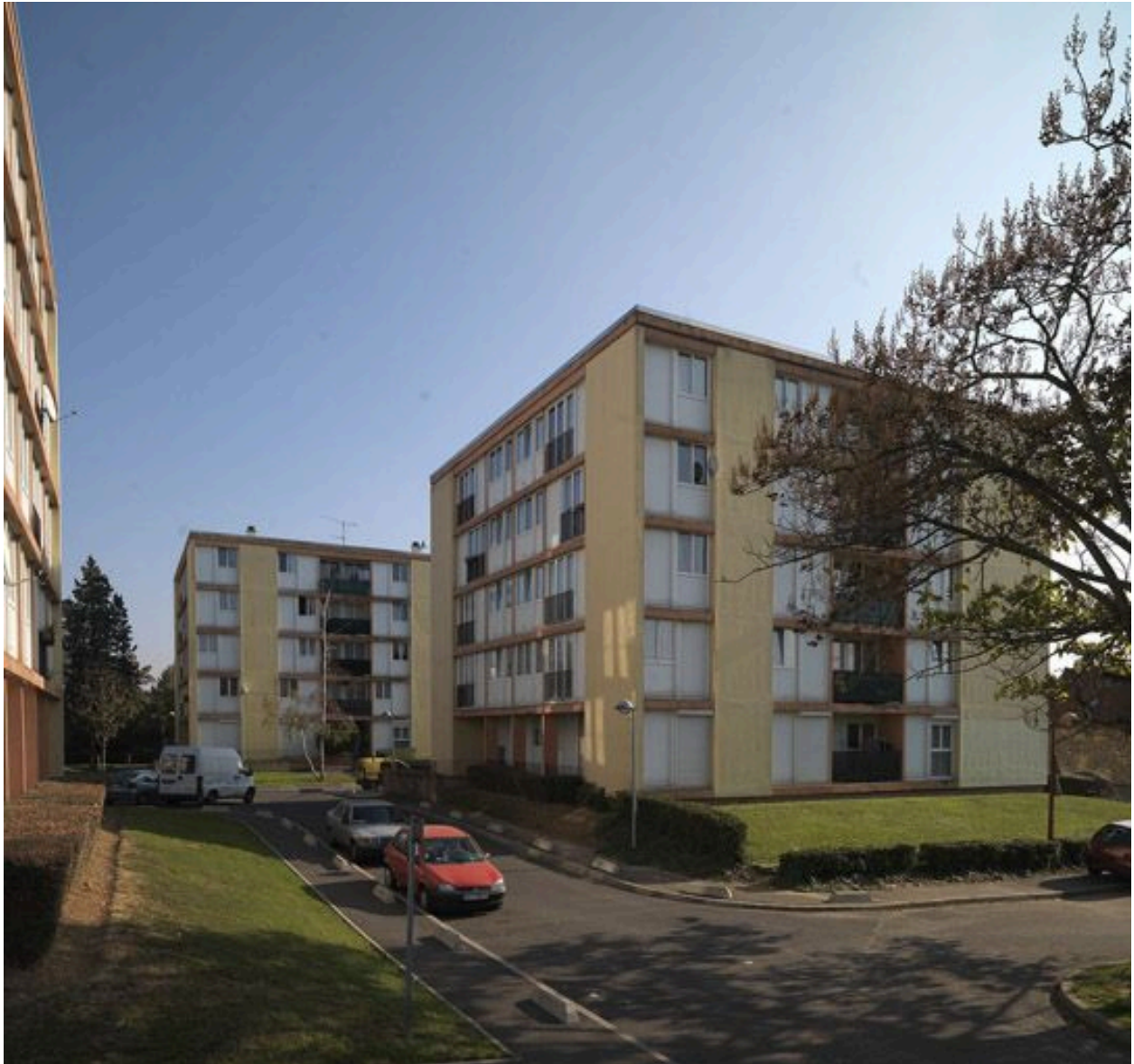
Ensemble de plots ou bâtiments cubiques situés sur la place Pablo-Picasso, au débouché de l'allée Fernand-Léger.
