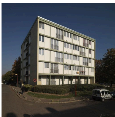
Vue d'ensemble d'un bâtiment ""pavé"" ou plot, situé 2, ruePaul-Verlaine. Phot. Philippe Ayrault IVR11_20089100225NUC4A
