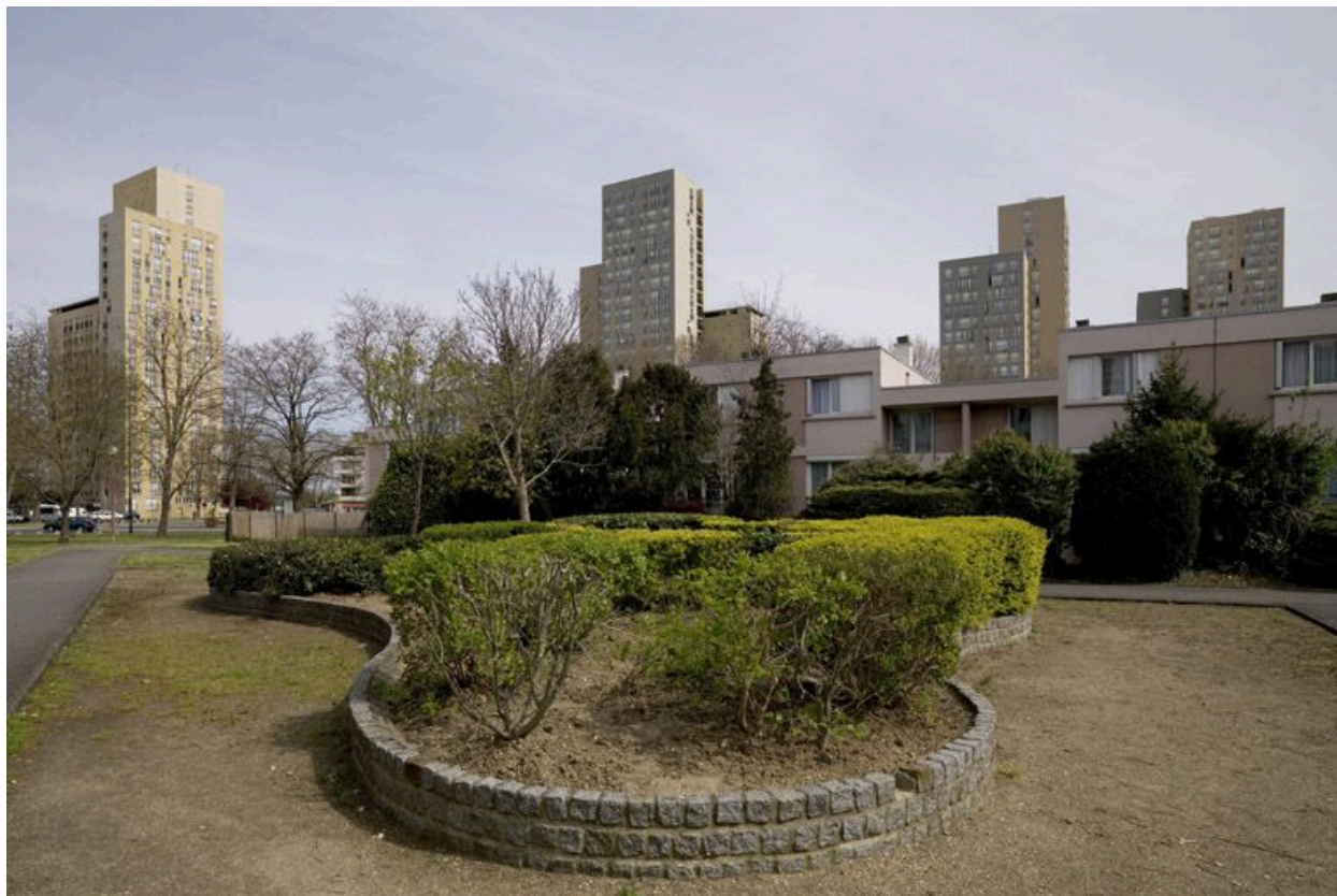
Massif d'arbustes taillés entourés d'une bordure maçonnée devant les logements individuels en bandes situés près de la place Ampère et de la rue Jules-Vallès.
