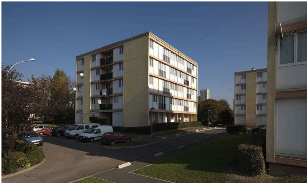
Ensemble de bâtiments ""pavés"" sur la place Pablo-Picasso, à la hauteur du carrefour avec l'allée Eugène-Delacroix.
