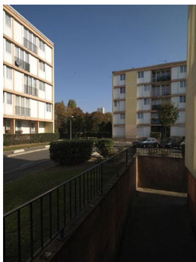
Les plots de la place Pablo-Picasso, dans le prolongement de l'allée Eugène-Delacroix. Phot. Philippe Ayrault IVR11_20089100237NUC4A
