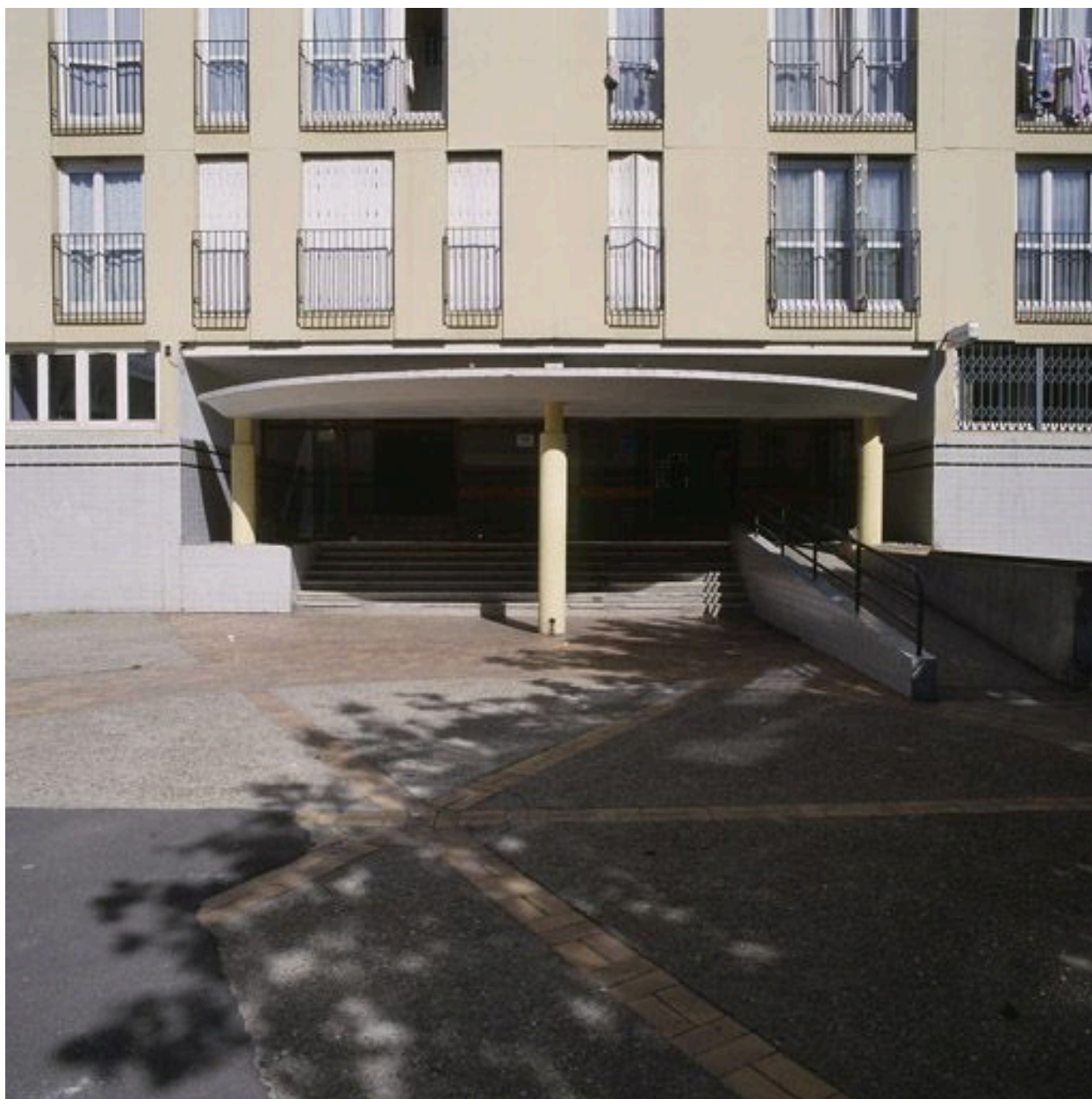
Détail de l'entrée d'une des tours.
