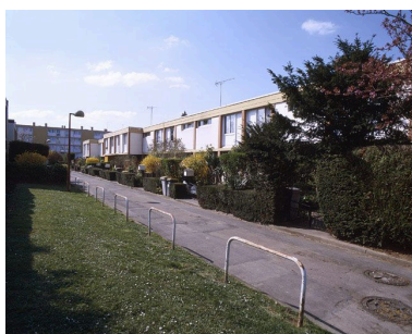
Les logements individuels en bande sont desservis par une voirie indépendante portant le nom d'""allées"".
