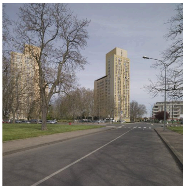
L'avenue Frédéric-Joliot-Curie débouchant sur l'avenue de la Concorde ; à droite des deux tours proches du carrefour et de la place du 14 Juillet, un des immeubles bas en cours de construction. Ces immeubles sont destinés à remplacer les tours dont la démolition est prévue dans le cadre du projet ANRU.
