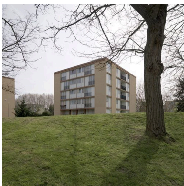
Un immeuble cubique de la place Ambroise-Paré vu de la pelouse descendant vers l'avenue Frédéric-Joliot-Curie. Phot. Philippe Ayrault IVR11_20089100389NUC4A
