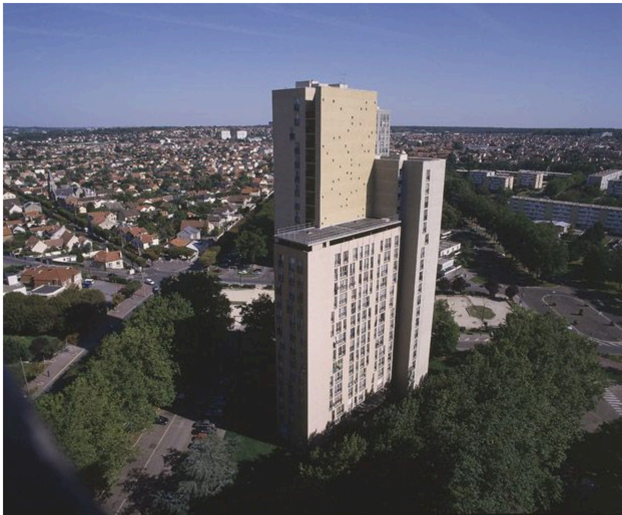
Vue d'ensemble de la tour située à l'arrière de la place du 14 Juillet.
