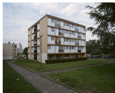
Vue d'un immeuble pavé situé avenue Henri-Barbusse à côté de la Maison de la justice et du droit.
