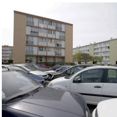
Voitures stationnées entre les immeubles. Phot. Philippe Ayrault IVR11_20089100386NUC4A
