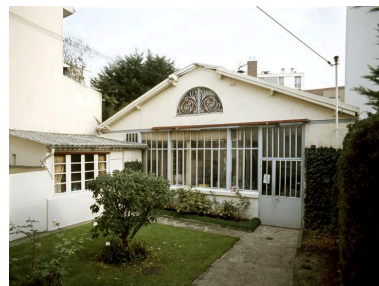
Vue du pignon de l'atelier, côté cour. IVR11_20059300027XA
