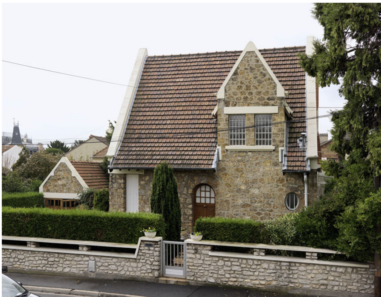
Vue d'ensemble depuis la rue de la maison ""bretonne"" construite en 1927 pour M. Rozelet.
