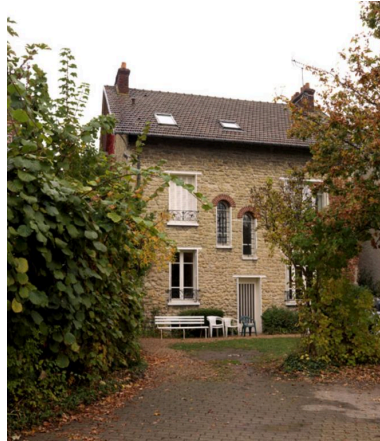
Façade sur jardin. Phot. Philippe Ayrault IVR11_20167800638NUC4A
