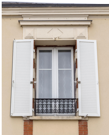
Vue d'une baie de l'étage. Phot. Asseline Stéphane IVR11_20259100274NUC4A
