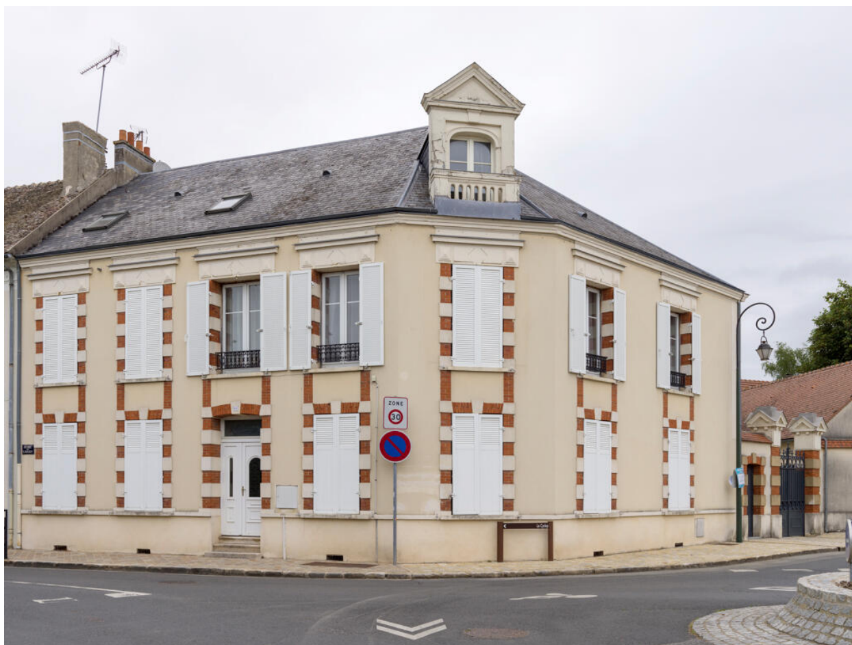
Vue générale depuis le sud-ouest.
