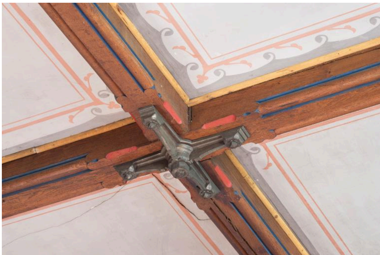
Poutre du plafond (2)
