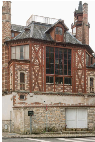
Vue de la verrière de l'atelier Phot. Laurent Kruszyk IVR11_20197700003NUC4A
