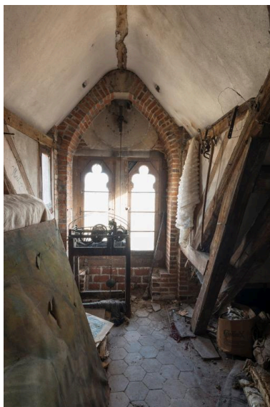
Vue des combles (1) Phot. Laurent Kruszyk IVR11_20197700026NUC4A
