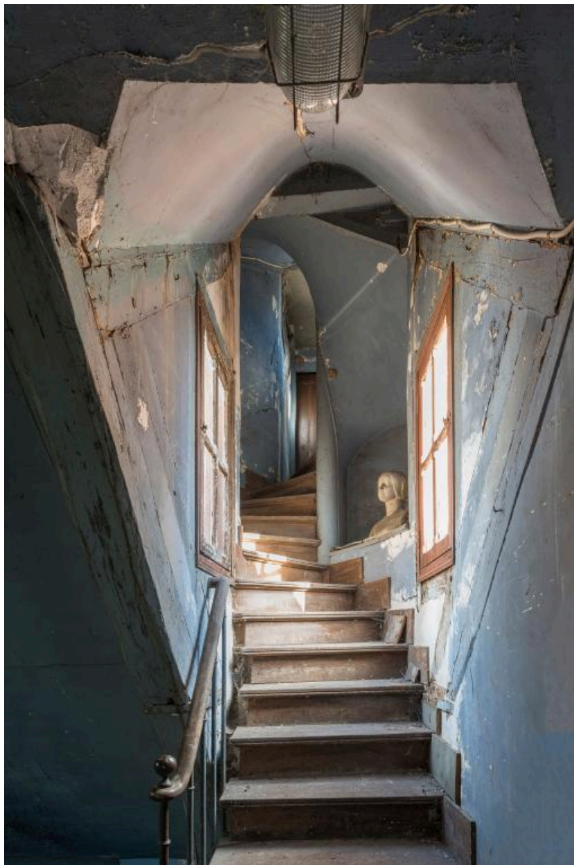
Vue de l'escalier menant aux combles au-dessus de l'atelier
