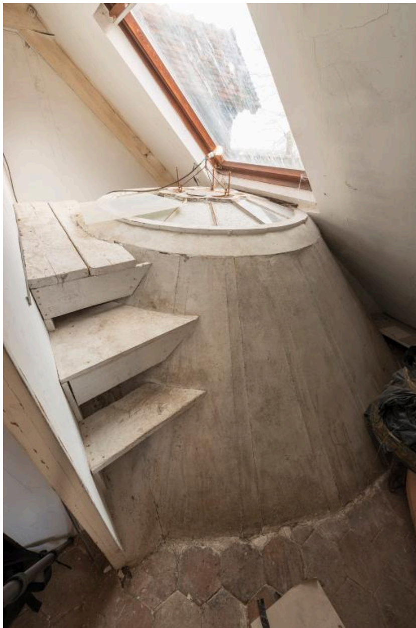
Coupole de béton protégeant le vitrail de l'escalier
