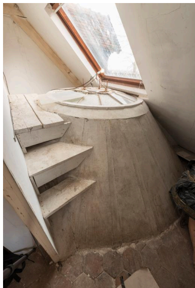
Coupoles de béton protégeant le vitrail de l'escalier Phot. Laurent Kruszyk IVR11_20197700016NUC4A
