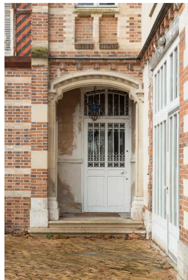
vue de l'entrée de l'atelier Phot. Laurent Kruszyk IVR11_20197700012NUC4A
