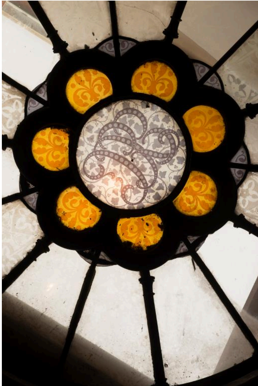
Détail du vitrail en surplomb de l'escalier
