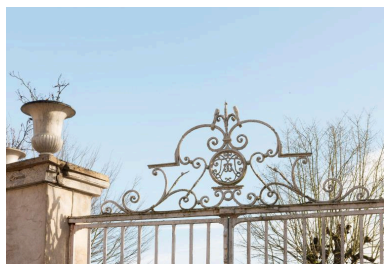
Faux-monogramme au-dessus de la grille d'entrée Phot. Laurent Kruszyk IVR11_20197700004NUC4A
