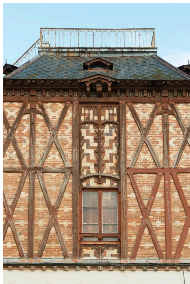
Vue rapprochée de la façade de l'atelier Phot. Laurent Kruszyk IVR11_20197700011NUC4A
