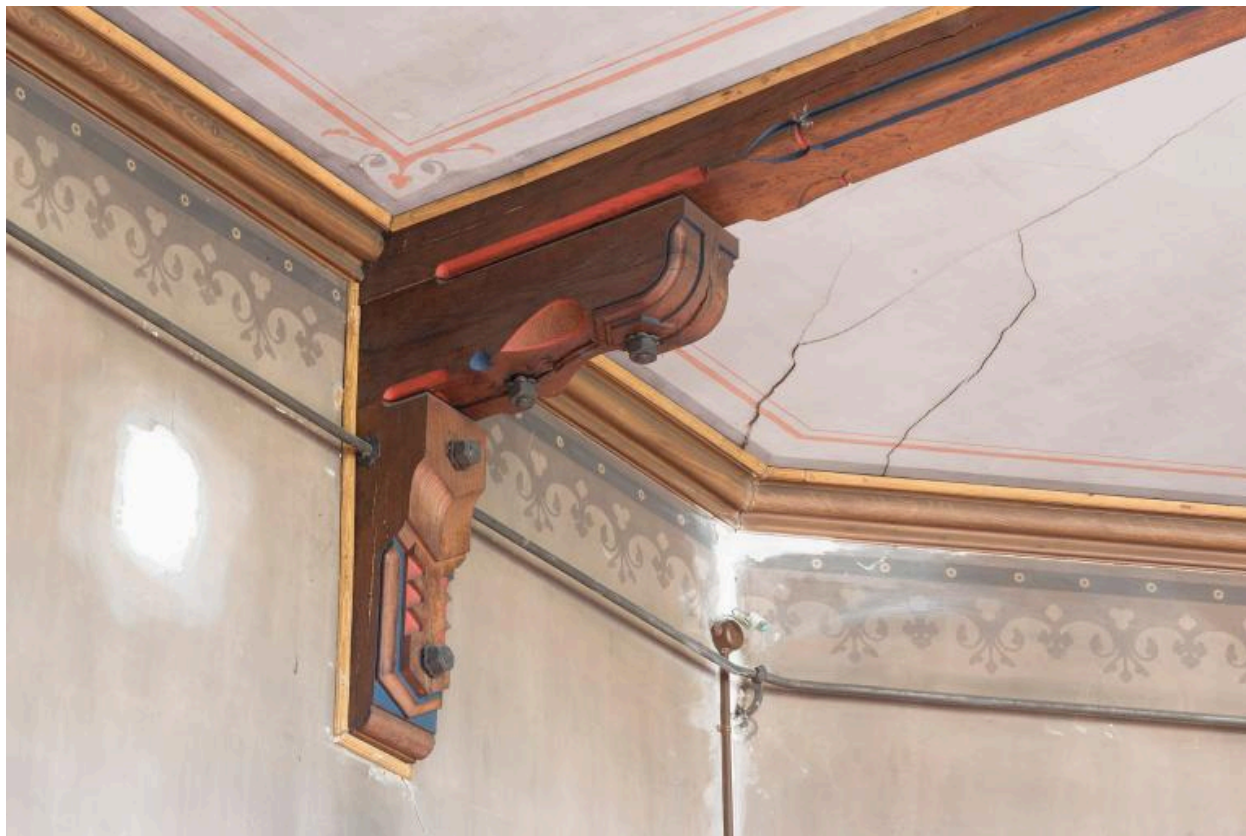
Poutre du plafond (1)
