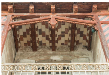
Voûtiens en brique polychromes qui couvrent la loggia Phot. Laurent Kruszyk IVR11_20197700008NUC4A
