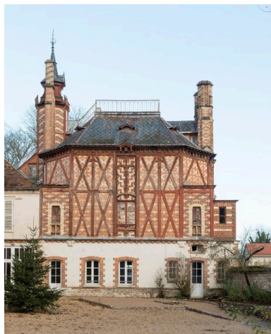
Vue de l'atelier prise depuis la cour (2) Phot. Laurent Kruszyk IVR11_20197700010NUC4A
