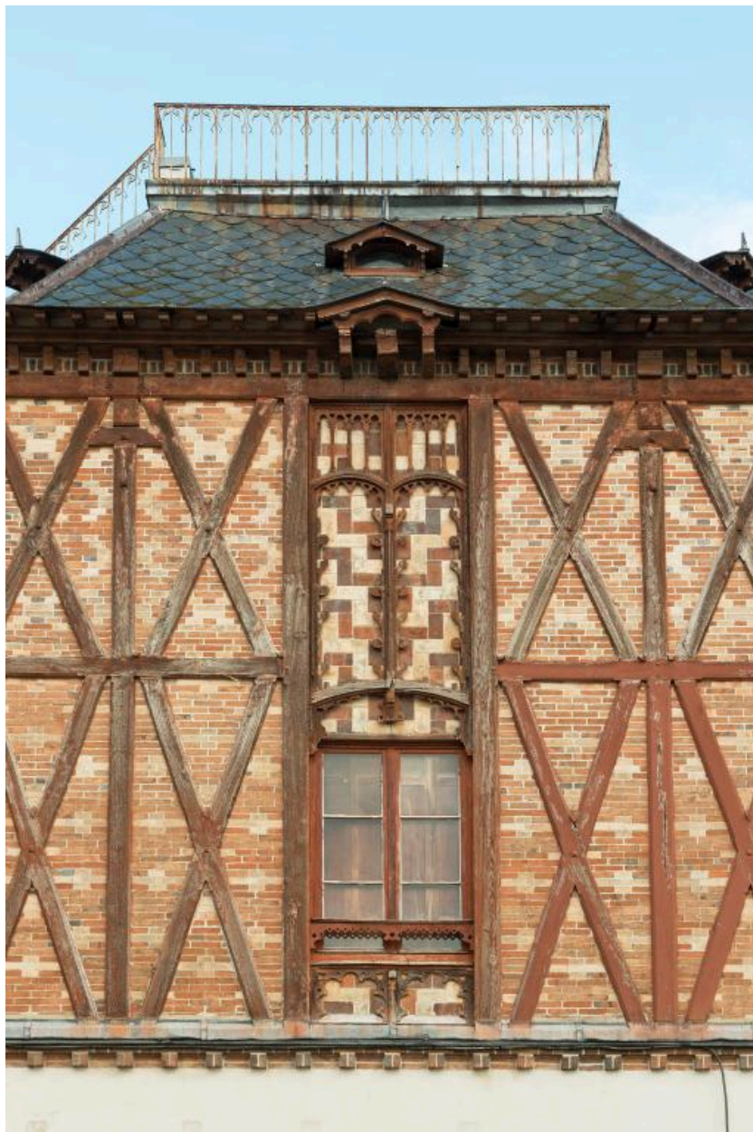
Vue rapprochée de la façade de l'atelier
