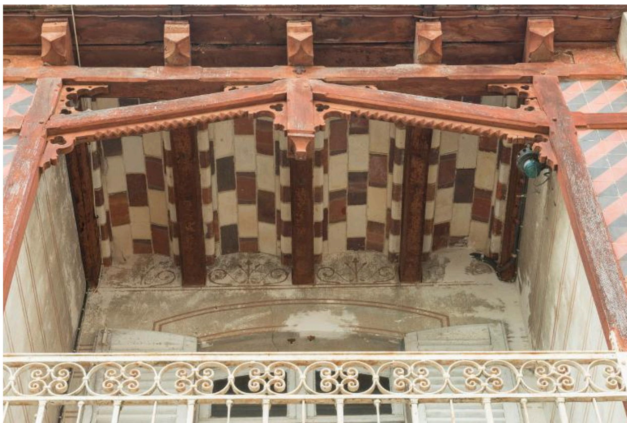
Voûtins en brique polychromes qui couvrent la loggia
