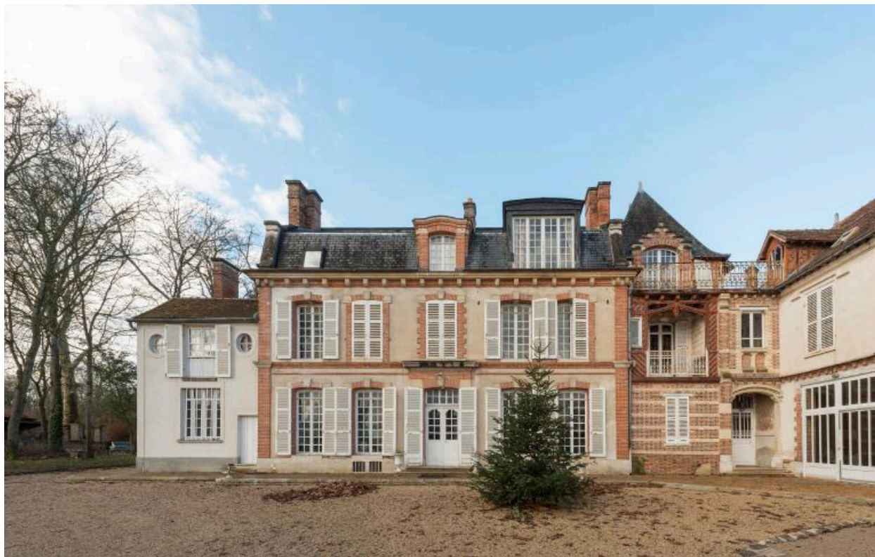
Vue du corps du château et du corps de jonction de Jules Saulnier
