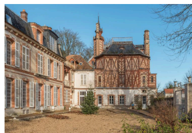
Vue de l'atelier prise depuis la cour (1) Phot. Laurent Kruszyk IVR11_20197700009NUC4A
