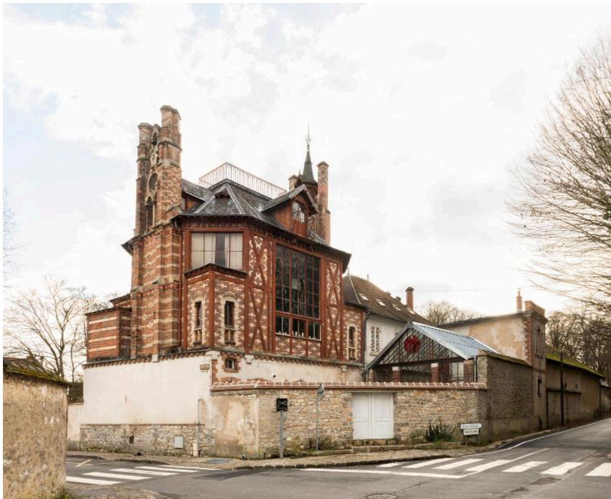
Vue d'ensemble de l'atelier (2)
