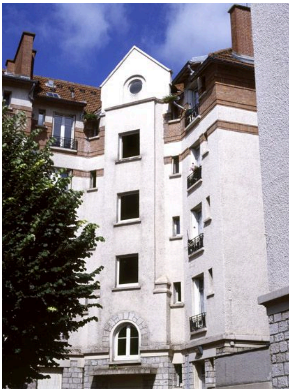
Détail d'un immeuble, avenue de la République.
