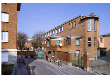
Vue du groupe scolaire Albert-Thomas, rue Charles-Fourier. Phot. Stéphane Asseline IVR11_20079400215XA
