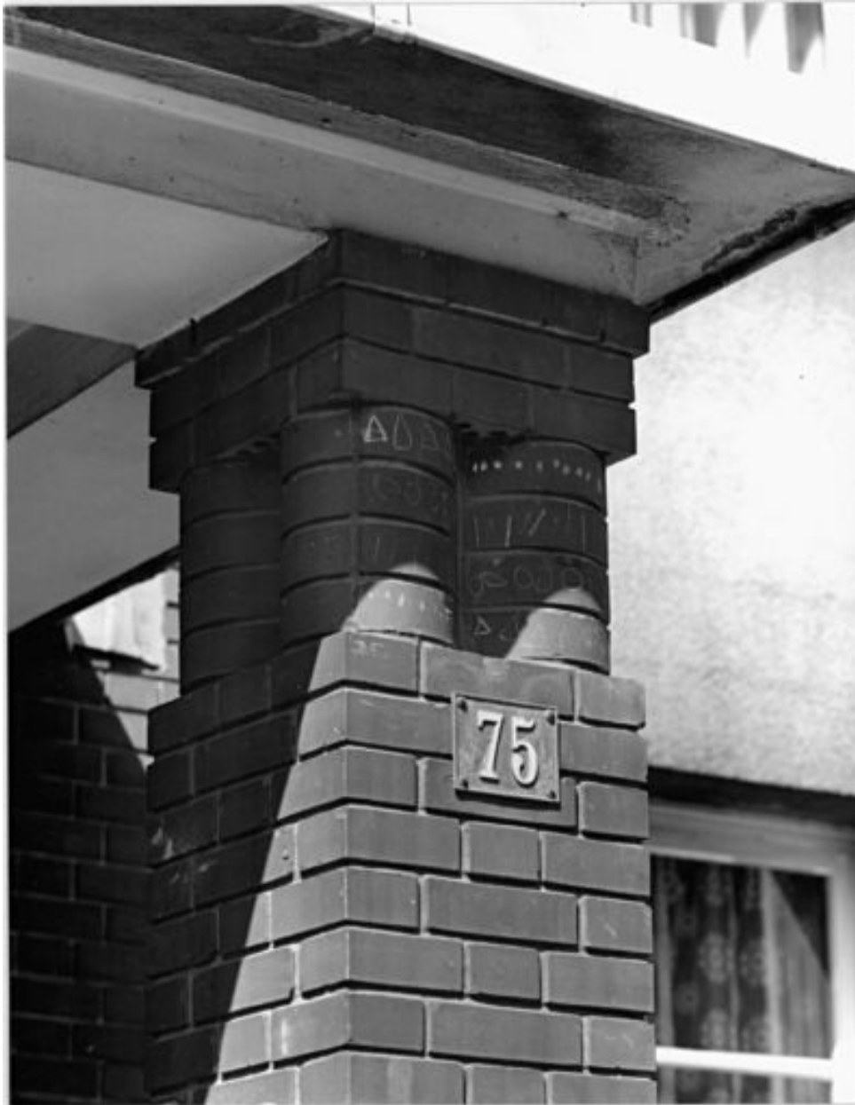
Détail d'un pilier de porche, 75 rue Francis-de-Pressencé.
