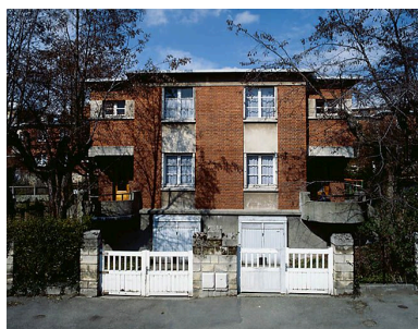
Façades antérieures de maisons jumelles, 15, 17 rue Proudhon. Phot. Christian Décamps IVR11_19869400151XA
