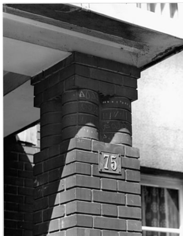
Détail d'un pilier de porche, 75 rue Francis-de-Pressencé. Phot. Christian Décamps IVR11_19869400341X
