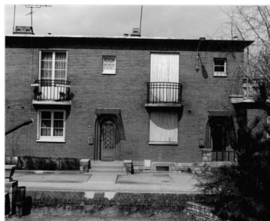
Cour et façades de maisons jumelles, rue Francis-de-Pressencé. Phot. Christian Décamps IVR11_19869400146X
