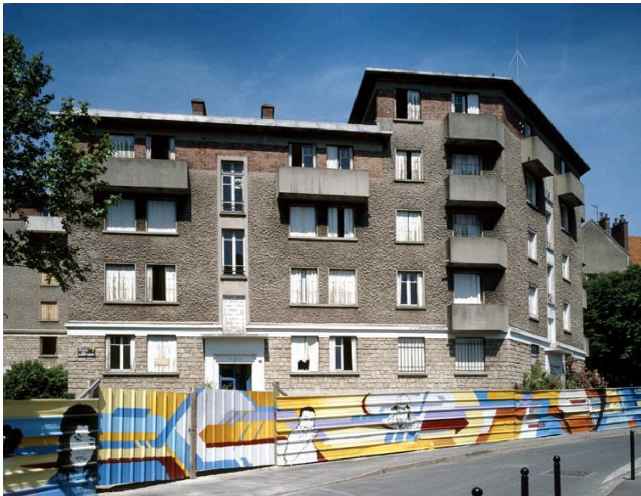
Bâtiments où logea la garde républicaine, avant restaurations, rue Karl-Marx.
