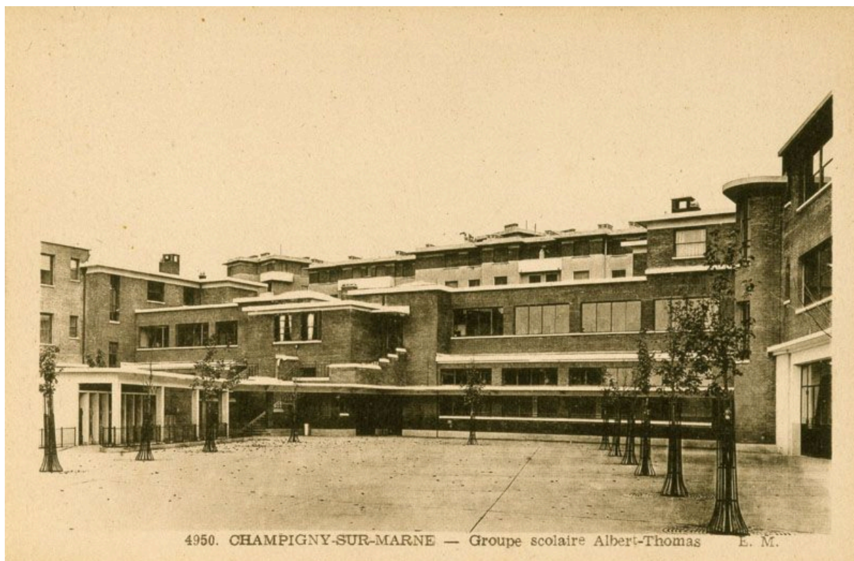
Vue du groupe scolaire depuis les cours. Carte postale. (AD Val-de-Marne. 2Fi Champigny 571)
