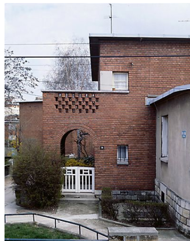
Vue de la maison et de son porche d'entrée, 14 rue Francis-de-Pressencé. Phot. Christian Décamps IVR11_19869400155XA
