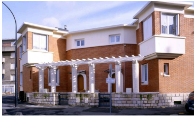
Maisons jumelles reliées par une pergola en béton, rue Proudhon. Phot. Stéphane Asseline IVR11_20079400061XA
