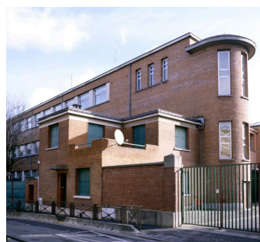
Vue du groupe scolaire Albert-Thomas, rue Charles-Fourier. Phot. Stéphane Asseline IVR11_20079400060XA
