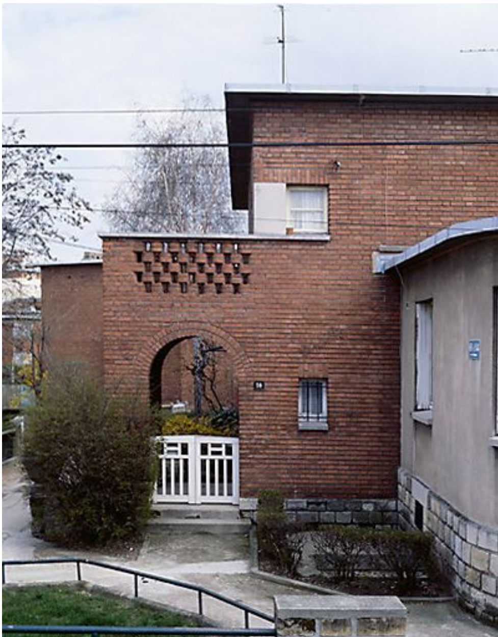
Vue de la maison et de son porche d'entrée, 14 rue Francis-de-Pressencé.
