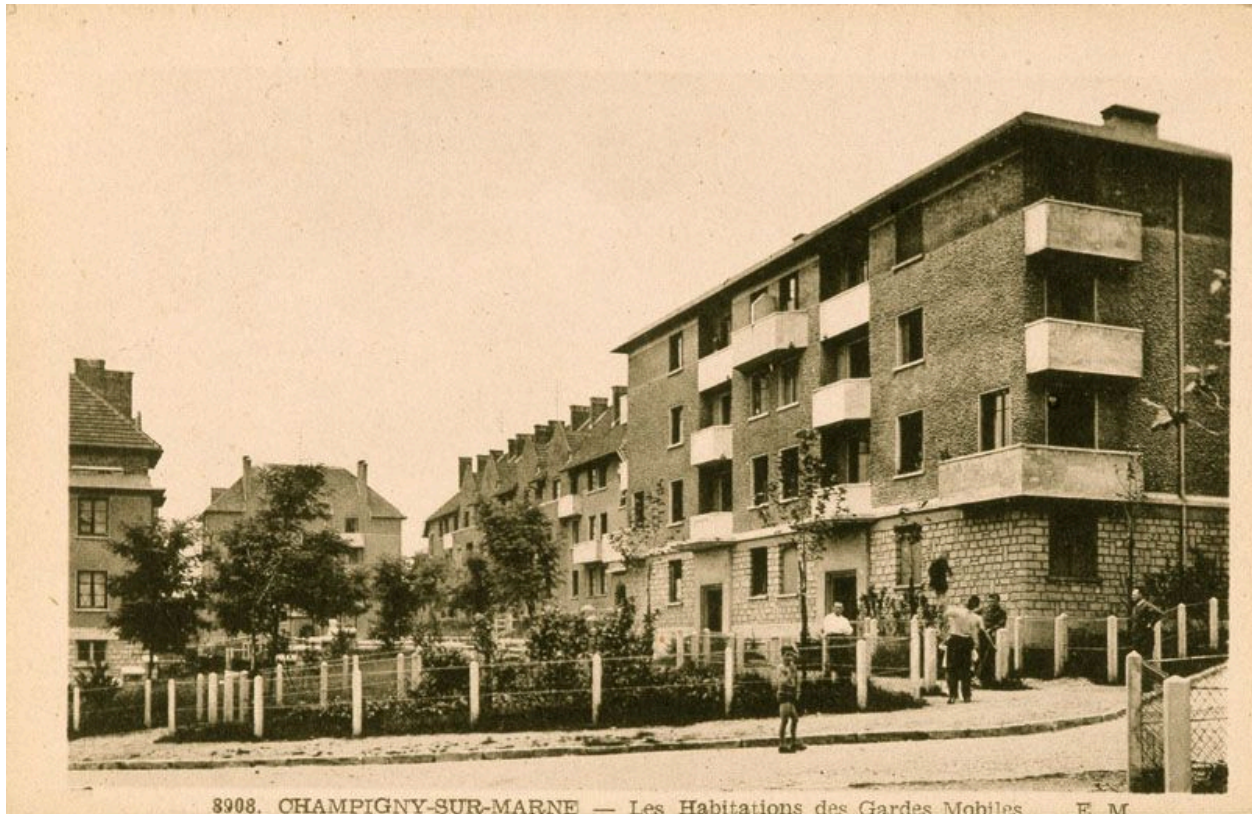
Vue des bâtiments, habitations des gardes mobiles. Carte postale. (AD Val-de-Marne. 2Fi Champigny 313)
