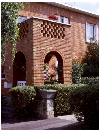
Détail d'un porche conduisant à un pavillon, rue Proudhon. Phot. Stéphane Asseline IVR11_20079400390XA
