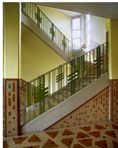
Détail de la balustrade métallique au décor art déco d'un escalier de l'école Albert-Thomas, rue Karl-Marx. Phot. Stéphane Asseline IVR11_20079400261XA
