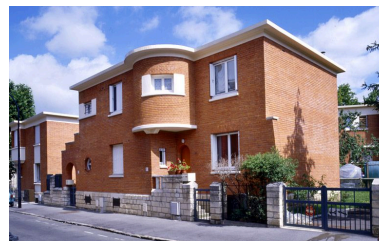
Vue d'ensemble de maisons-jumelles, rue Proudhon. Phot. Stéphane Asseline IVR11_20079400392XA
