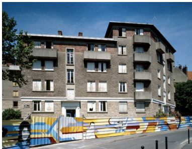
Bâtiments où logea la garde républicaine, avant restaurations, rue Karl-Marx. Phot. Stéphane Asseline IVR11_20069400154VA
