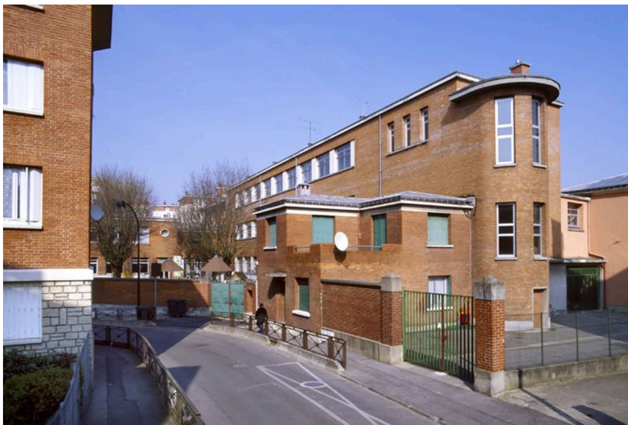
Vue du groupe scolaire Albert-Thomas, rue Charles-Fourier.
