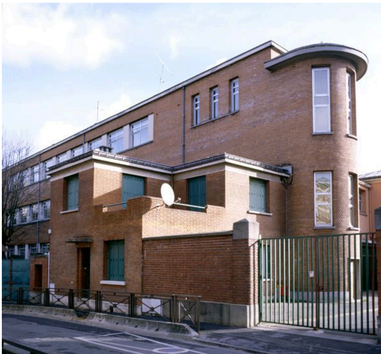
Vue du groupe scolaire Albert-Thomas, rue Charles-Fourier.
