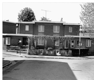
Maisons jumelles et pergola, 16-18 rue Karl-Marx. Phot. Christian Décamps IVR11_19869400338X
