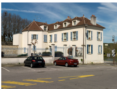
Vue de la façade sur la place. Phot. Laurent Kruszyk IVR11_20157800238NUC4A
