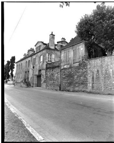
Vue de la façade sur le quai des Cordeliers et la Seine. Phot. Pascal Corbière IVR11_19777800734X
