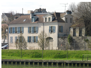
Vue de la façade de l'hôtel du côté du quai des Cordeliers et de la Seine. Phot. Laurent Kruszyk IVR11_20157800211NUC4A
