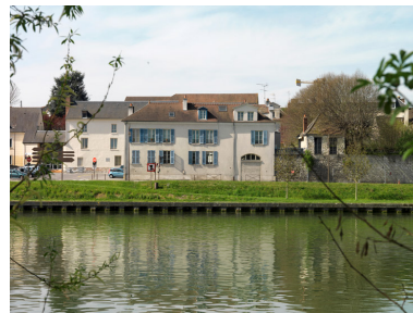
Vue de la maison dans son site, depuis l'île de Limay. Phot. Laurent Kruszyk IVR11_20157800213NUC4A
