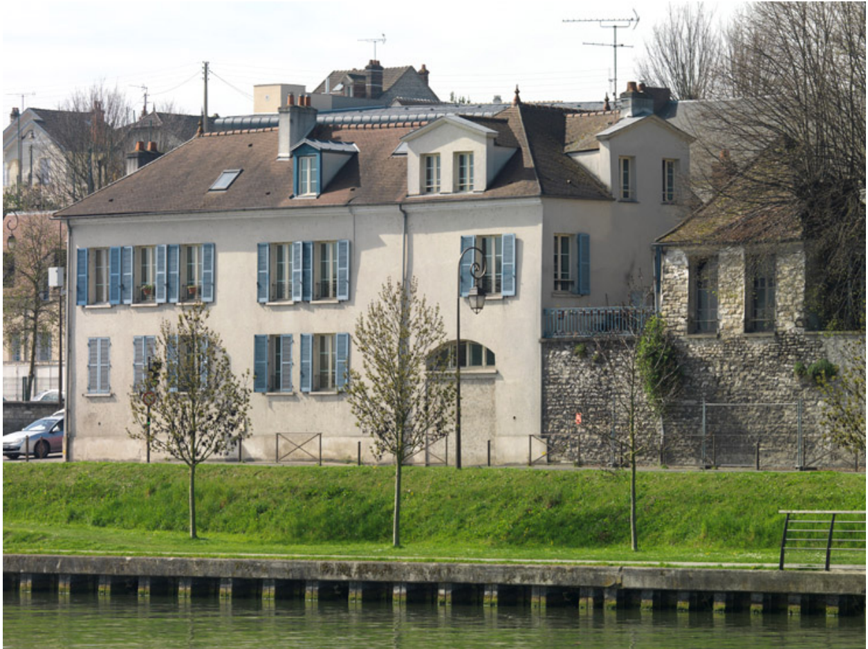
Vue de la façade de l'hôtel du côté du quai des Cordeliers et de la Seine.
