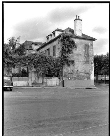
Vue de la maison depuis la place du Hèvre. Phot. Pascal Corbière IVR11_19777800735X
