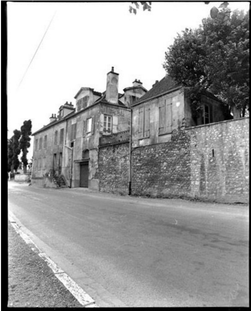
Vue de la façade sur le quai des Cordeliers et la Seine.
