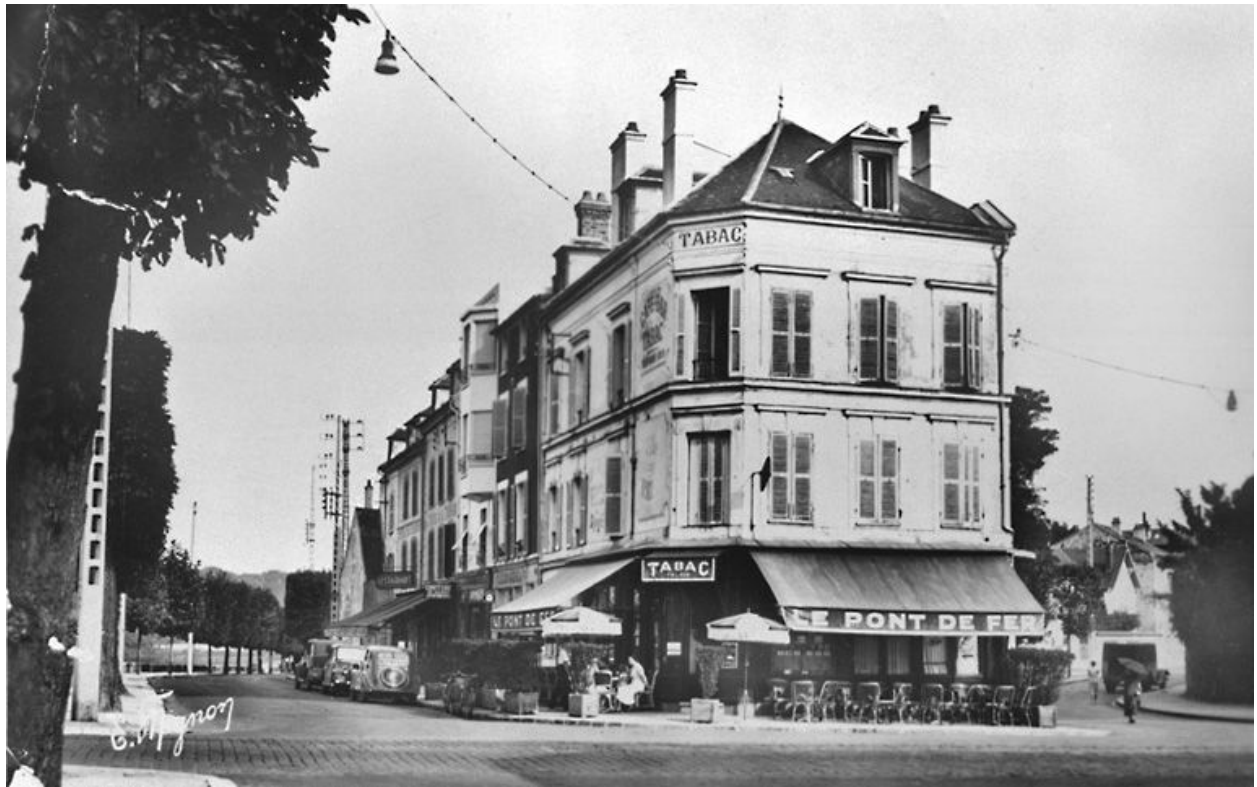
Vue du quai de Seine, rive gauche, en amont du pont de fer, vers 1940. Carte postale. (Musée municipal de Melun. inv. 983.2.354)
