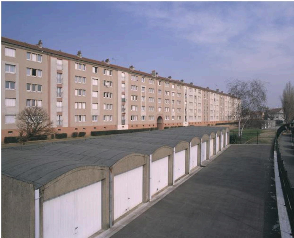
Vue d'ensemble sur l'avenue Jean-Jaurès (en direction du n° 116).
