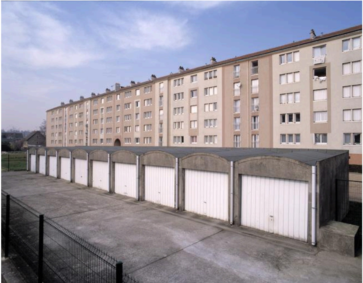
Vue d'ensemble sur l'avenue Jean-Jaurès (en direction du n° 100).
