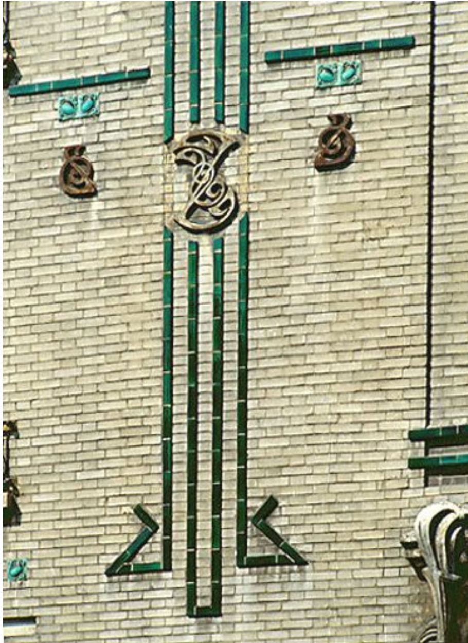
Détail de la façade latérale : décor de céramique et ancrés métalliques.
