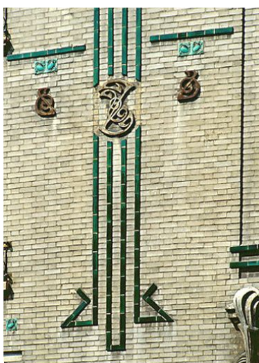
Détail de la façade latérale : décor de céramique et ancrés métalliques. Phot. Christian Décamps IVR11_19869400469XA
